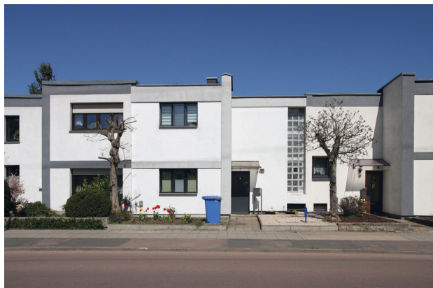
10 Damaschkestraße , 2016. Am mittleren Gebäude sind die Stahlfenster sehr wahrscheinlich noch erhalten, wobei ein Flügel fehlt,
