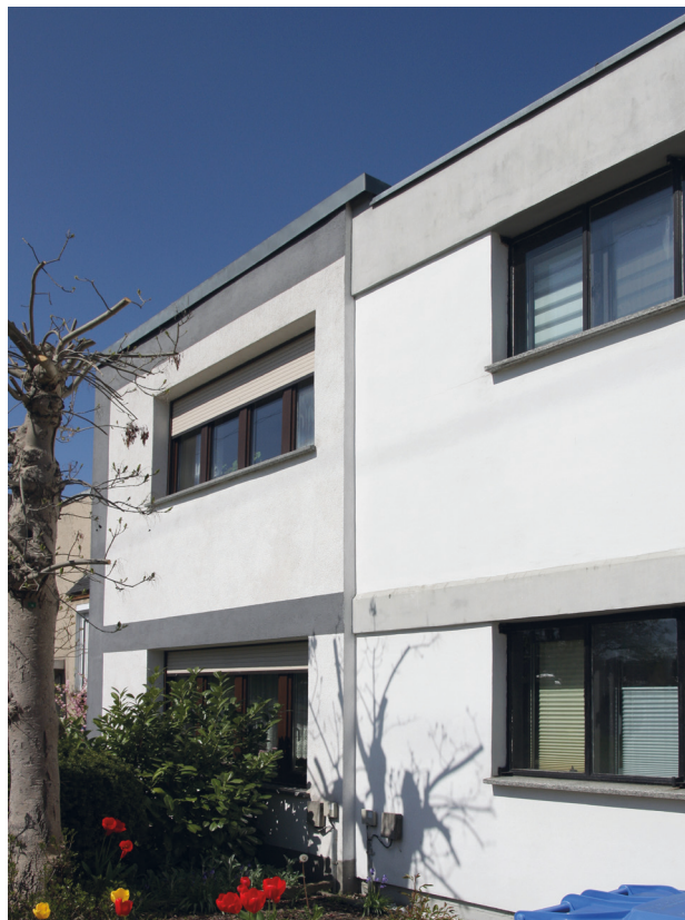
19 Fassaden in der Damaschkestraße , 2016.
