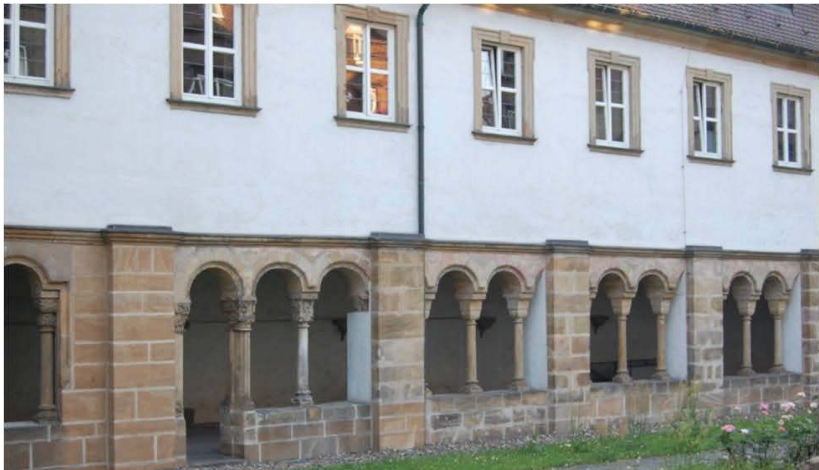
Abb. 2: Bamberg, St. Theodor: westlicher Kreuzgangflügel. Zustand nach Öffnung der Arkaden
