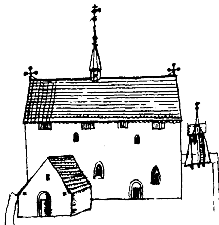
Abb. 11. Böda um 1634. Mehrgeschossige Rechteckkirche mit Wehrfunktionen.
