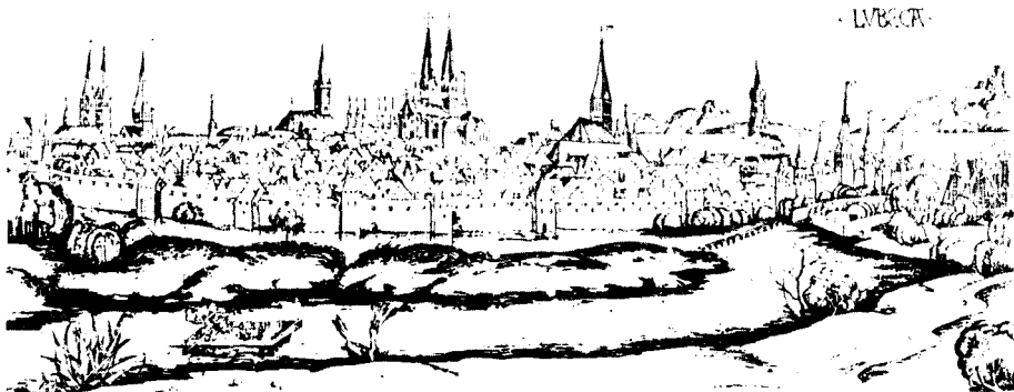
Abb. 9. Lübeck. Stadtmauer im ausgehenden 15. Jahrhundert. Ansicht von Osten.
