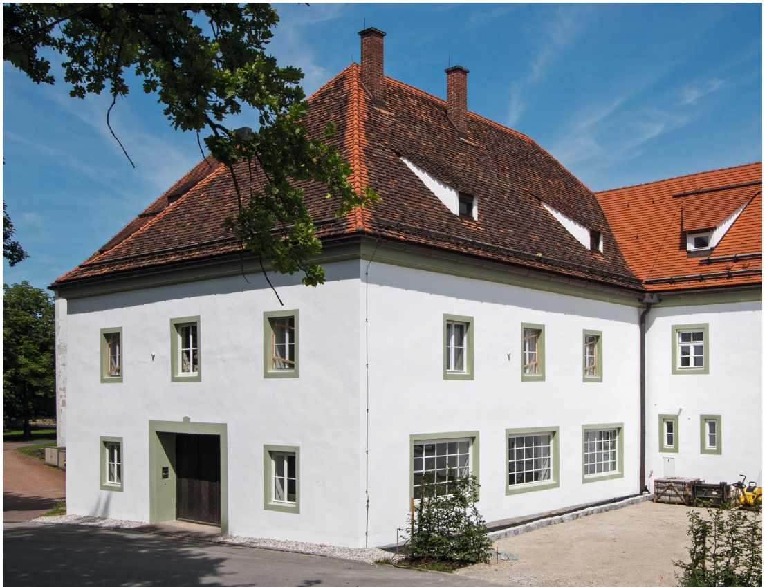
3 Die Fassade der Alten Schäferei in Benediktbeuern wird, wie viele andere Denkmalfassaden, von verschiedenen Fenstertypen geprägt.
