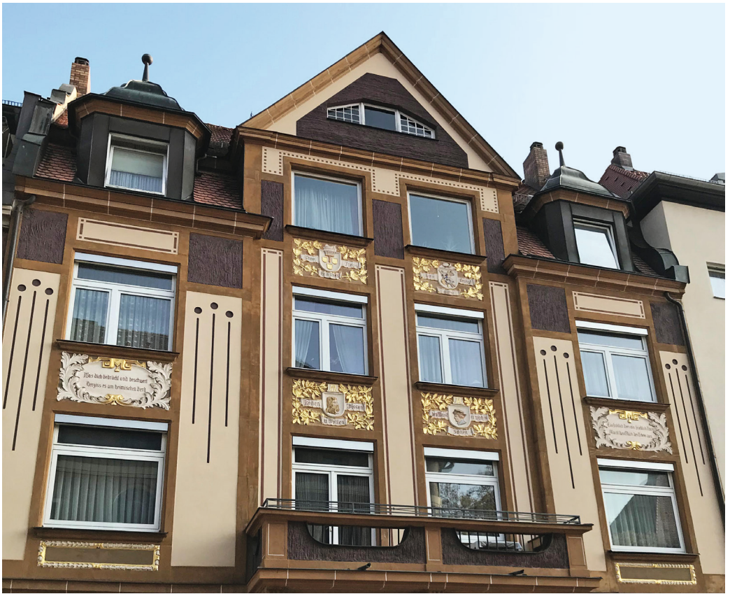
2 Fassade eines Hauses um 1900 in der Herzog-Max-Strasse, Bamberg, mit neuen modern geteilten Alufenstern.
