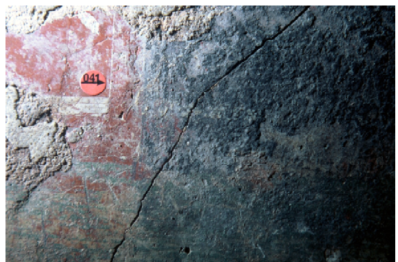
Abb. 225 Befund 041-K34, das grüne Band ist mit dicker, pastoser Farbe aufgemalt und überdeckt auf diese Weise den unsauberen Zwischenbereich der Wandzonen.
