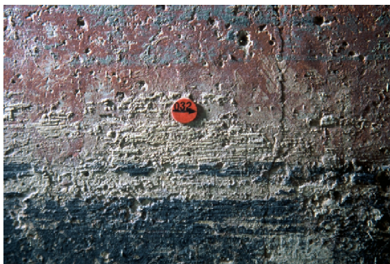
Abb. 111 Befund 032-K37, Oberputzauftrag auf den Sockel. Der Putz läuft im Bereich der waagerechten Bänder aus und überdeckt die Streichspuren der Mittelzone.
