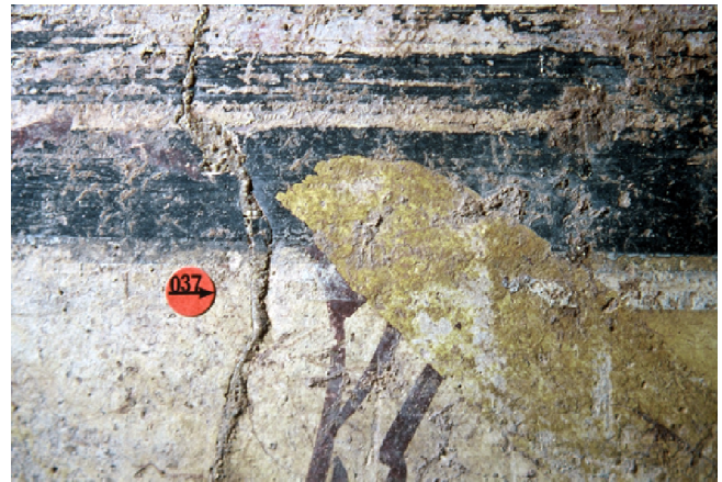
Abb. 218 Befund 037-K37, über die gelben Streifen des Marmorfeldes weiße und graue Flächen gelegt.
