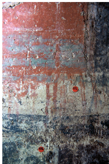
Abb. 206, 207 Befund 031-K37, mindestens zweifacher Auftrag der roten Farbe in flüssiger Konsistenz im Bereich der Spiegel. Die Farbe ist in Trielern in den Übergangsbereich von Mittelzone und Sockel hingelaufen. Die Ritzung auf dem Oberputz, um das Mittelfeld einzuteilen ist ebenfalls deutlich erkennbar.
