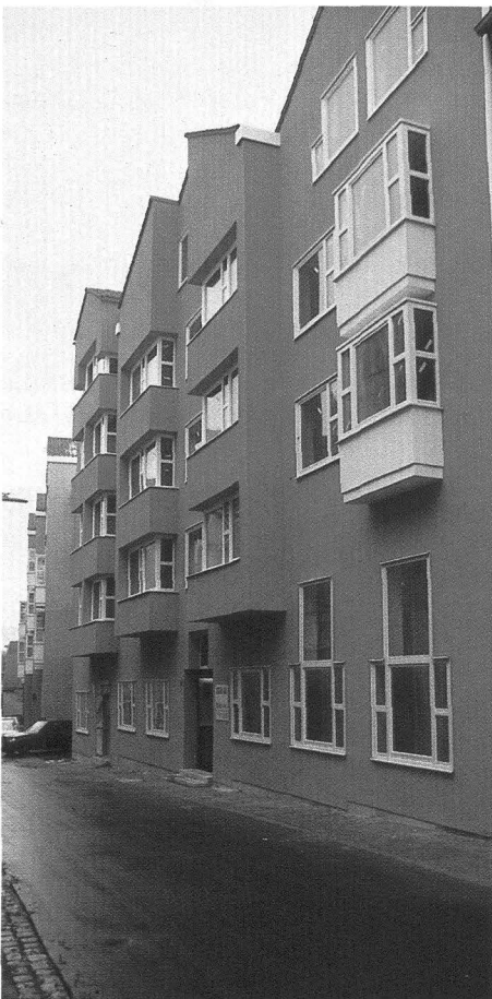
Außenansicht der Filiale Eichstätt, Pedettistraße Nr. 4
