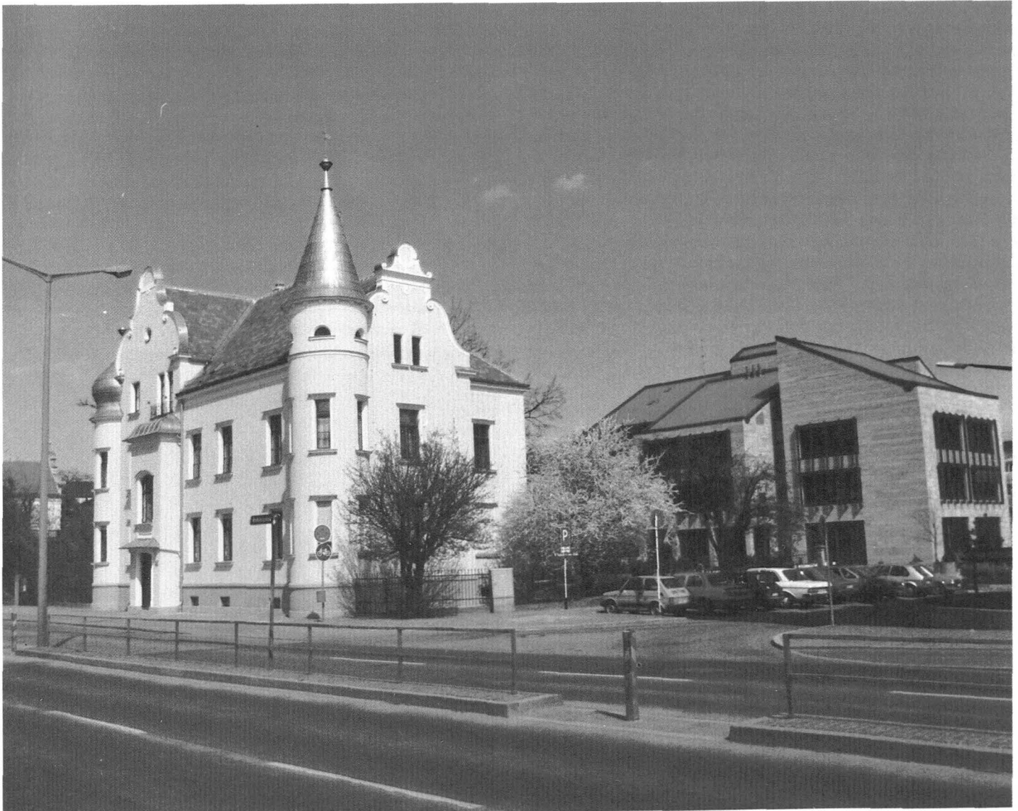
Blick auf die LIGA-Zentrale von der Weißenburg-Straße aus
