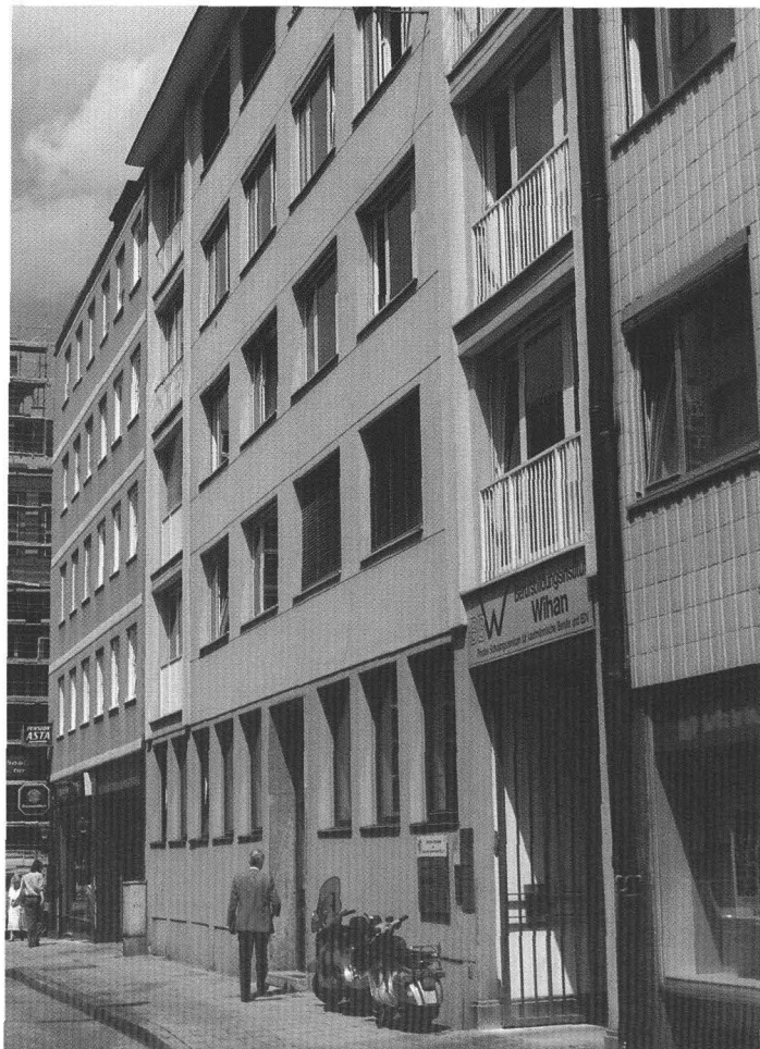
Außenansicht der Filiale München, Hirtenstraße 26
