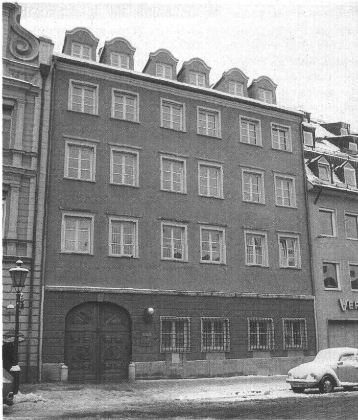
Außenansicht der Filiale Augsburg, Ulrichsplatz Nr. 6
