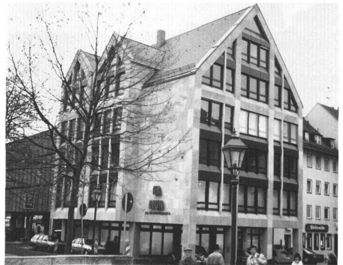
Außenansicht der Filiale Nürnberg
