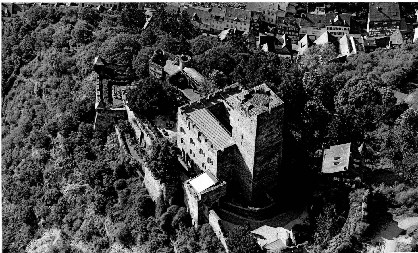
14 Burg Gutenfels ist eine sogenannte Frontturmberg: Der Bergfried schützt mit seiner Mauermaße die dahinterliegende Burg in Spornlage.
