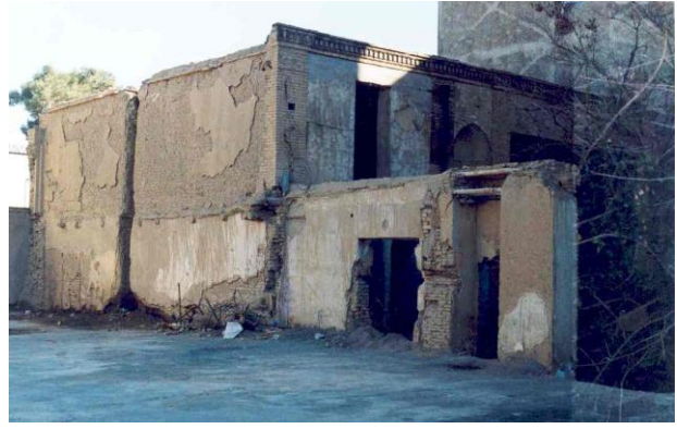
Image 5-16: Historic House of Farzāne (Source: Afrund: Gozāreš-e Pažuheši va Barresi va Šenāsā'i-e Āsār-e Bāstāni va Tārihi )
