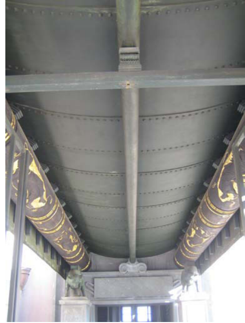
Abb. 131: Stiertreppe, Holzbalken. Abb. aus: Foto der Verfasserin.
