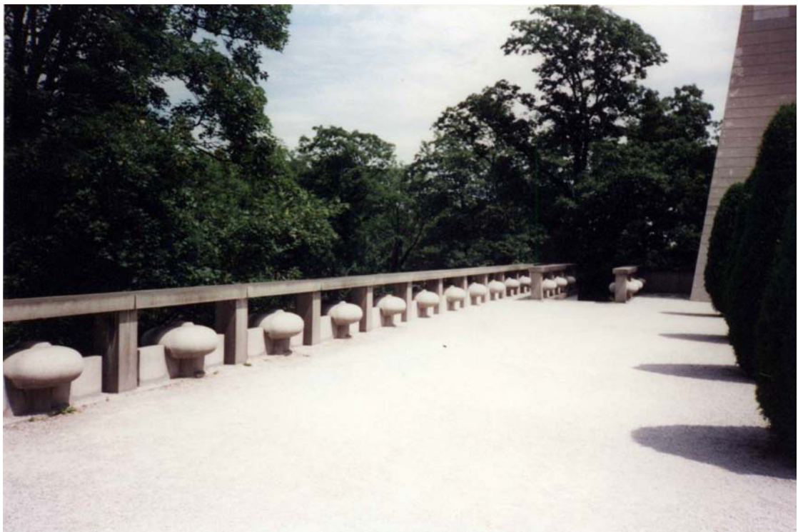
Abb. 142: Basteigarten, Balustrade, Steg zur Pulverbrücke. Abb. aus: Foto der Verfasserin.
