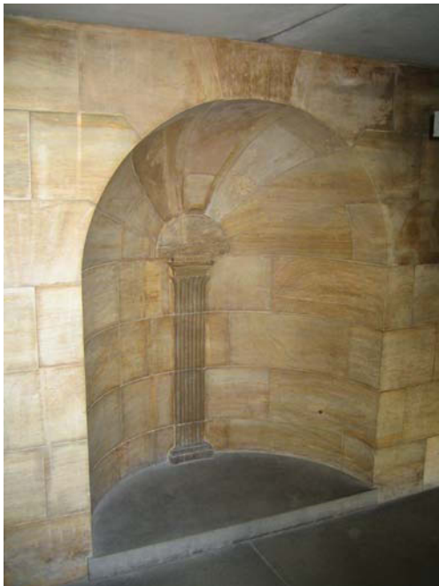
Abb. 125: Stiertreppe, Treppenhaus. Abb. aus: Foto der Verfasserin.
