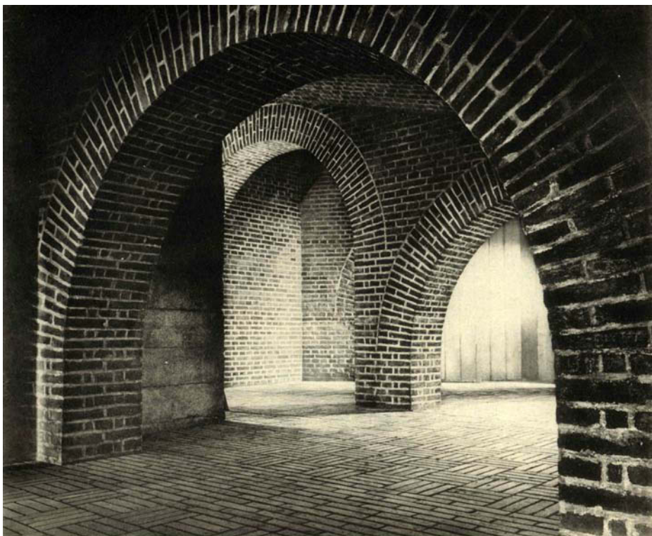
Abb. 48: Paradiesgarten, Kellergewölbe unter der Granittreppe, 1920–27, hist. Aufnahme, um 1928. Abb. aus: BAUVERWALTUNG DER PRAGER BURG, 1928, S. 38.
