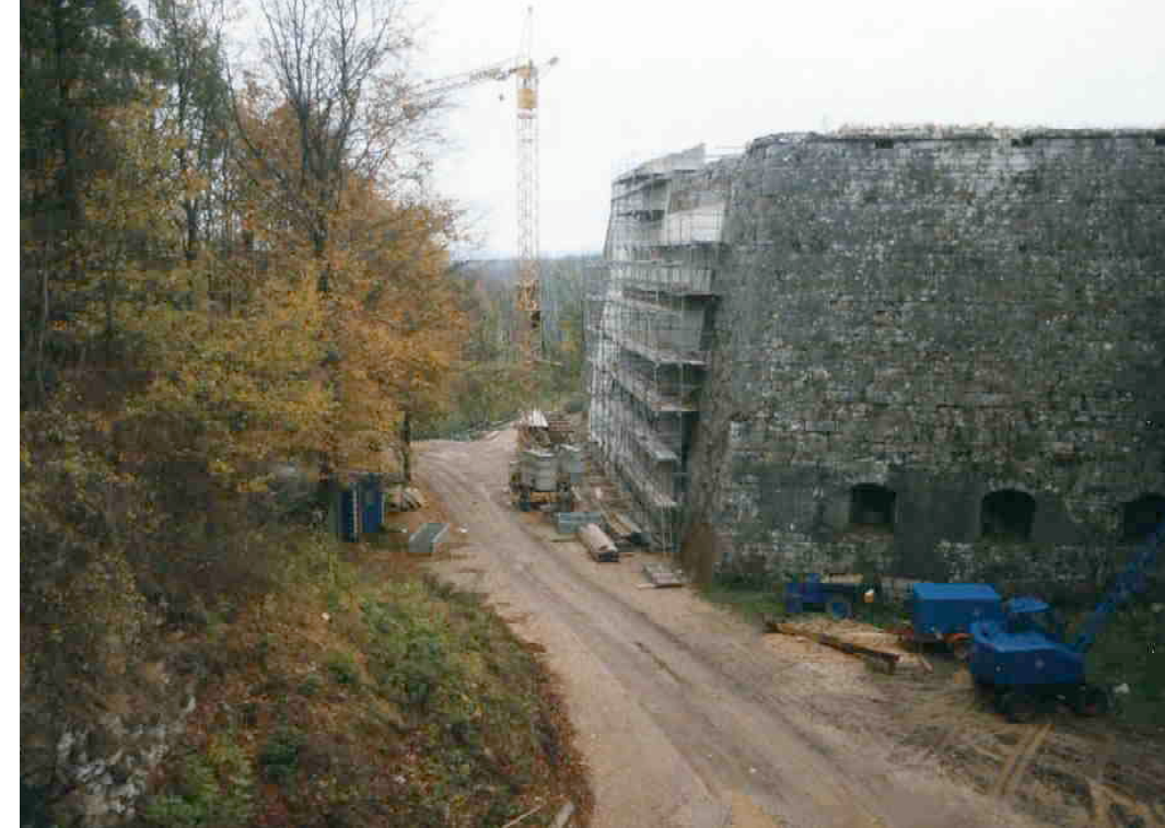
F 254 Bastion Karl Instandsetzung der Ostface 1986 A. Wörler Heimatverein Schnaittach
