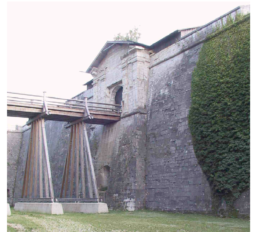
R 13 Portal F 448 2004 S. Thole
