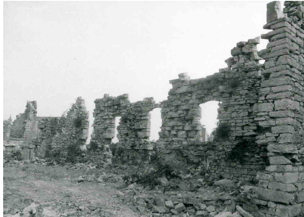
F 261 Amalienkaserne Noch unsanierte Südmauer 1986 A. Wörler Heimatverein Schnaittach
