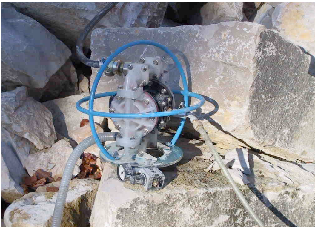
F 371 Verpressung 1 im November 2003 Injektionsförderpumpe 2003 S. Thole
