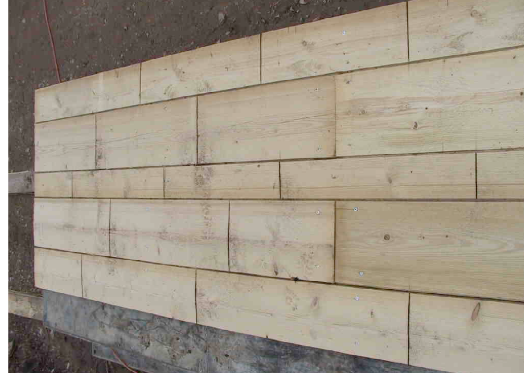
F 330 Holzbreter für die Betonverschalung
