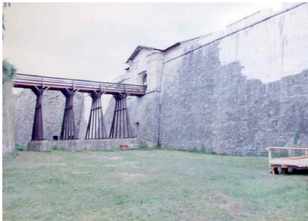
F 207 Portal Sanierte Mauerflächen 1982 A. Wörler Heimatverein Schnaittach
