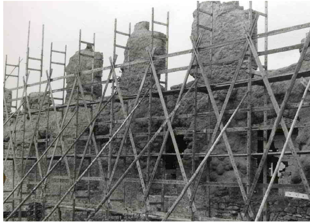
F 225 Zeughaus, Westflügel Torkretieren der Mauern
