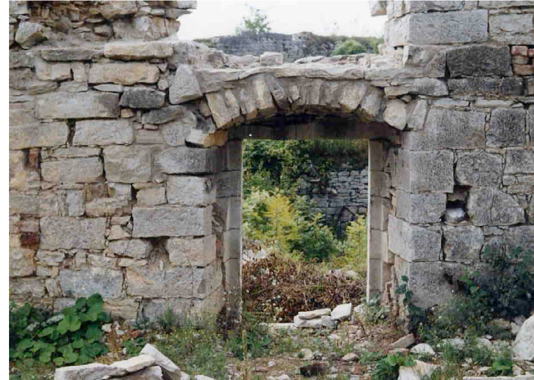
F 296 Karlskaserne Sanierter Fensterbogen 1990 W. Kaschel Heimatverein Schnaittach
