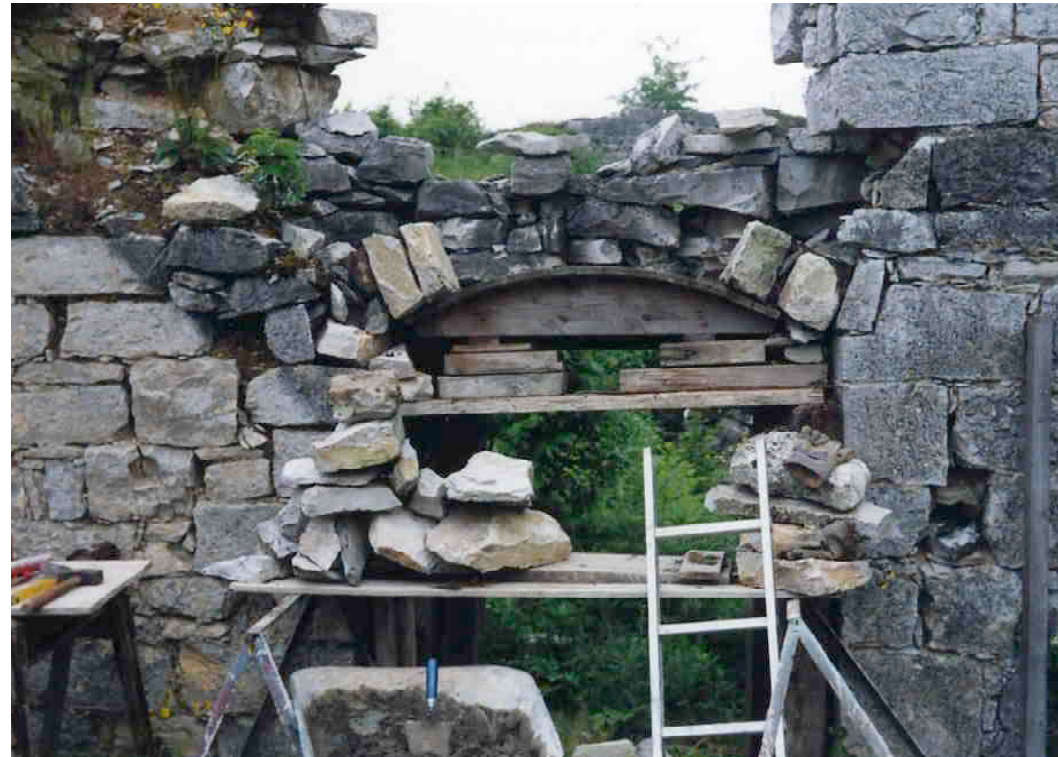
F 295 Karlskaserne Instandsetzung der Fensterbögen 1990 W. Kaschel Heimatverein Schnaittach
