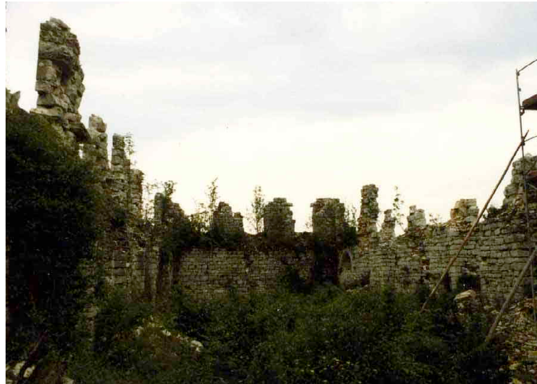
F 275 e Zeughaus Ostflügel vor der Instandsetzung 1984 Unbekannt Heimatverein Schnaittach
