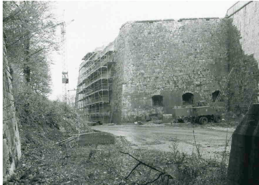
F 253 Bastion Karl Instandsetzung der Ostface 1986 O. Kohlmann Heimatverein Schnaittach
