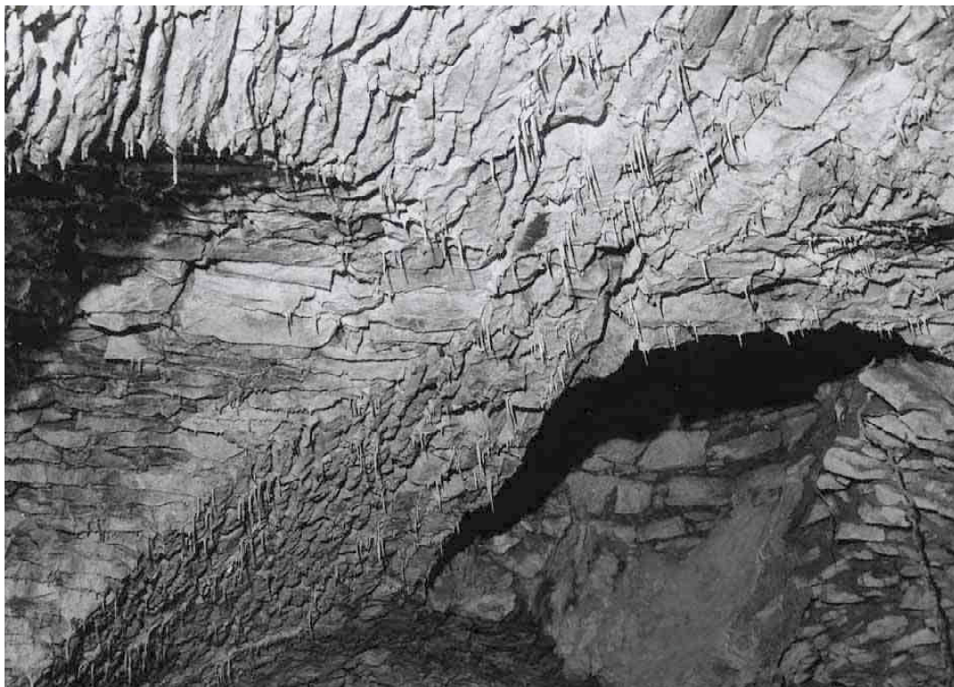
F 079 Kasematten Unter der Kommandantur 1966 Maul, Schnaittach Heimatverein Schnaittach
