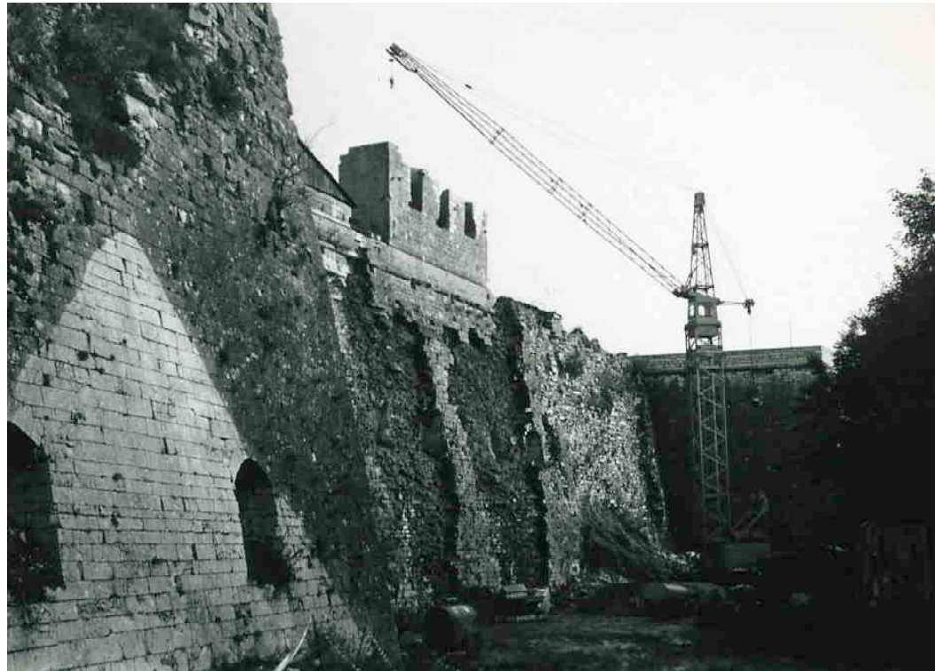
F 237 Kurtine zwischen den Bastionen Amalie und Schnaittach Instandsetzungsarbeiten 1984 O. Kohlmann Heimatverein Schnaittach
