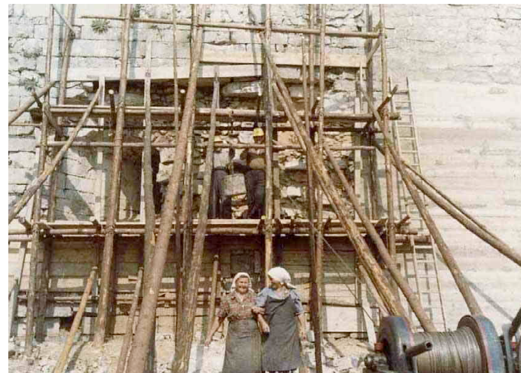
F 056 Bastion Karl Instandsetzungsarbeiten
