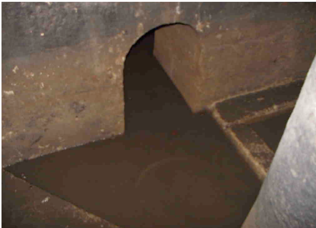
F 399 Schneckenbrunnen Fuss des Treppenhauses mit Eingang zum Wasserstollen 2004 S. Thole
