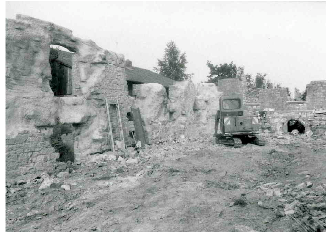
F 260 Amalienkaserne Torkretierung der Nordmauer
