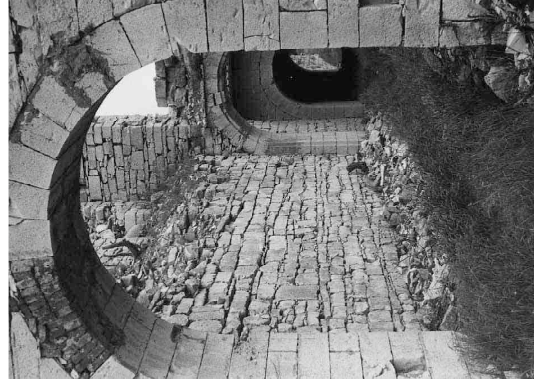
F 070 Zeughaus, Westteil Durchfahrt an der Mauerfront
