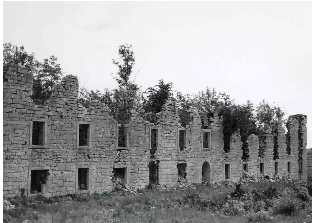
F 061 Karlskaserne Südseite 1966 Maul, Schnaittach Heimatverein Schnaittach
