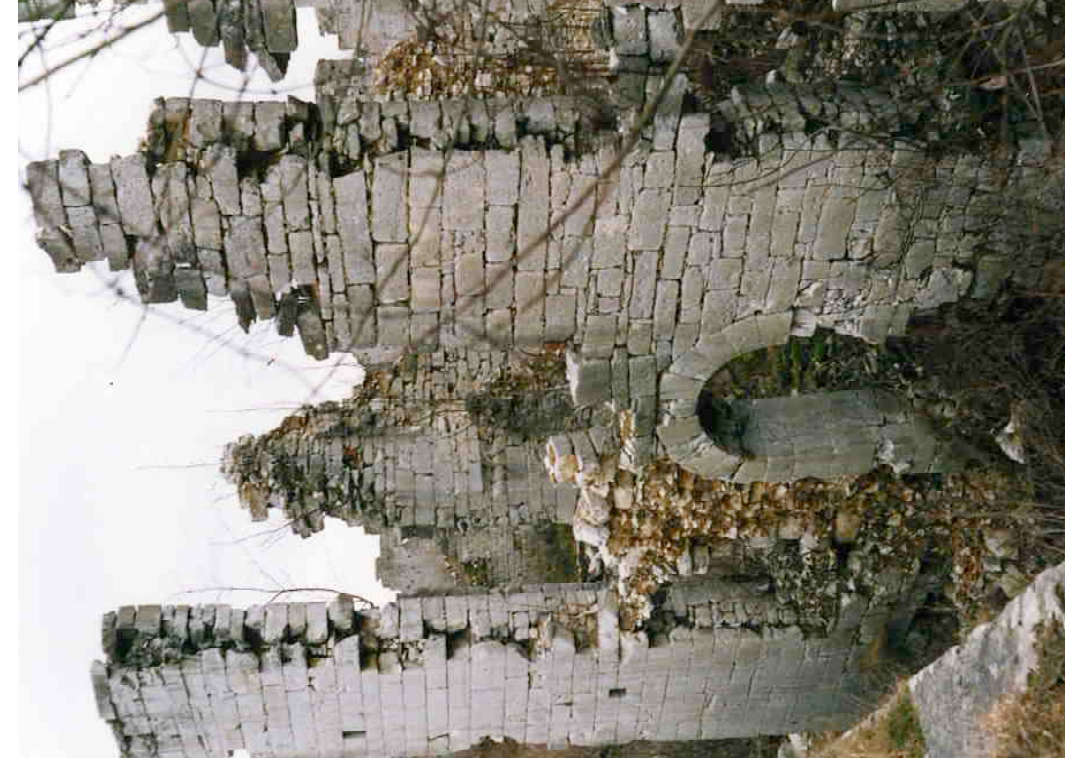
F 312 Karlskaserne, Ostseite Vor Beginn der Instandsetzungsarbeiten 1991 W. Kaschel Heimatverein Schnaittach
