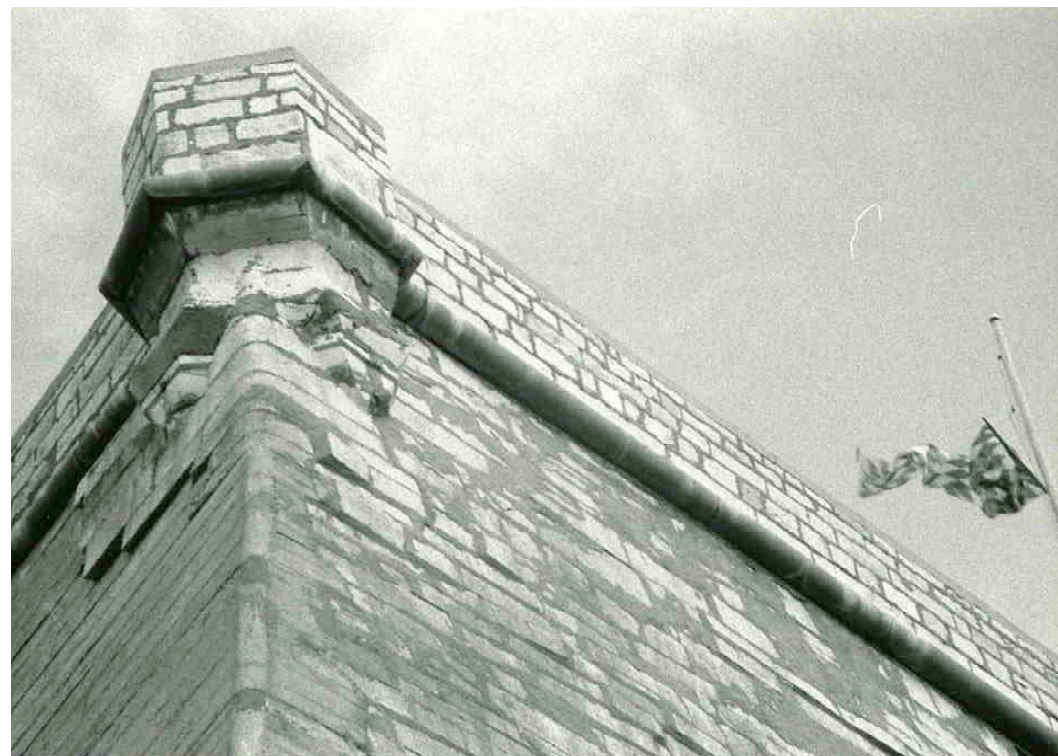
F 251 Bastion Schnaittach Saniertes Wachturmchen
