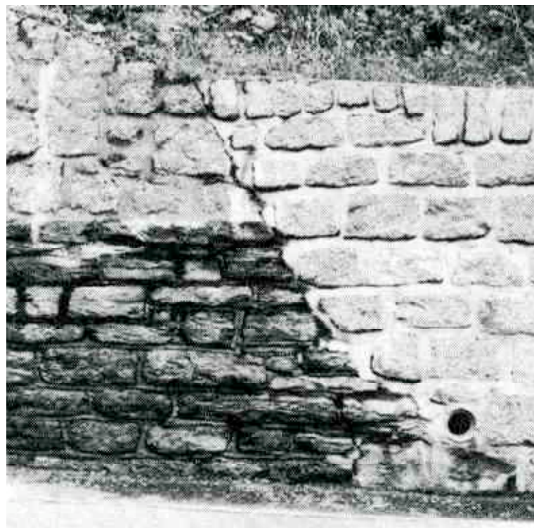
F 475 Wasseraustrittsöffnungen von Vertikaldrainagen 1989 A. Hegland, J. Simonett Straßen als Baudenkmäler
