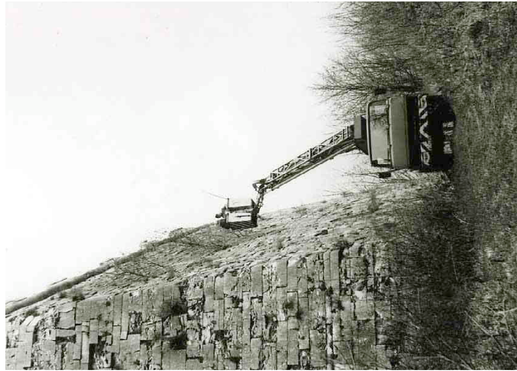
F 185 Bastion Glatzenstein Bewuchsentfernung 1981 W. Kaschel Heimatverein Schnaittach
