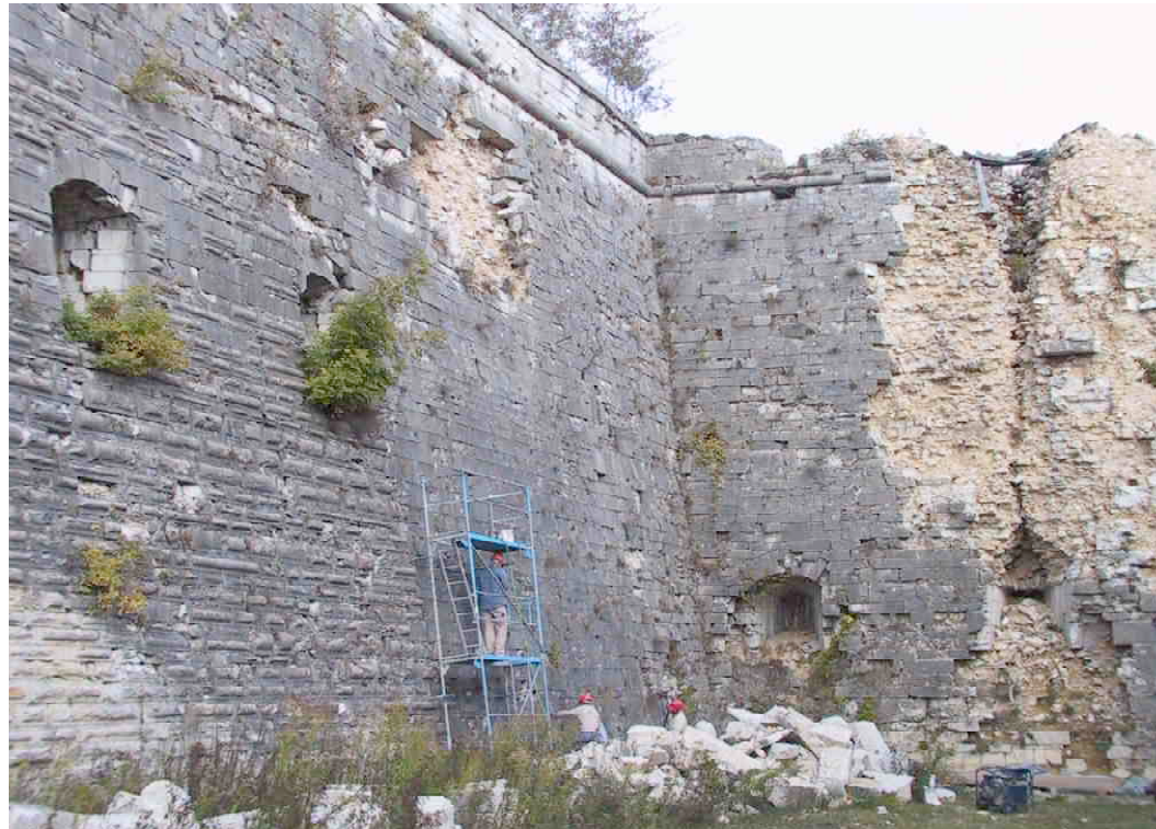
F 417 Kurtine zwischen den Bastionen Glatzenstein und Kersbach Vorbereitung zur Bohrkernentnahme A im Oktober 2003 2003 S. Thole
