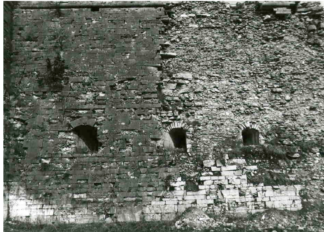
F 269 Bastion Kersbach Abbruch des Mauermantels
