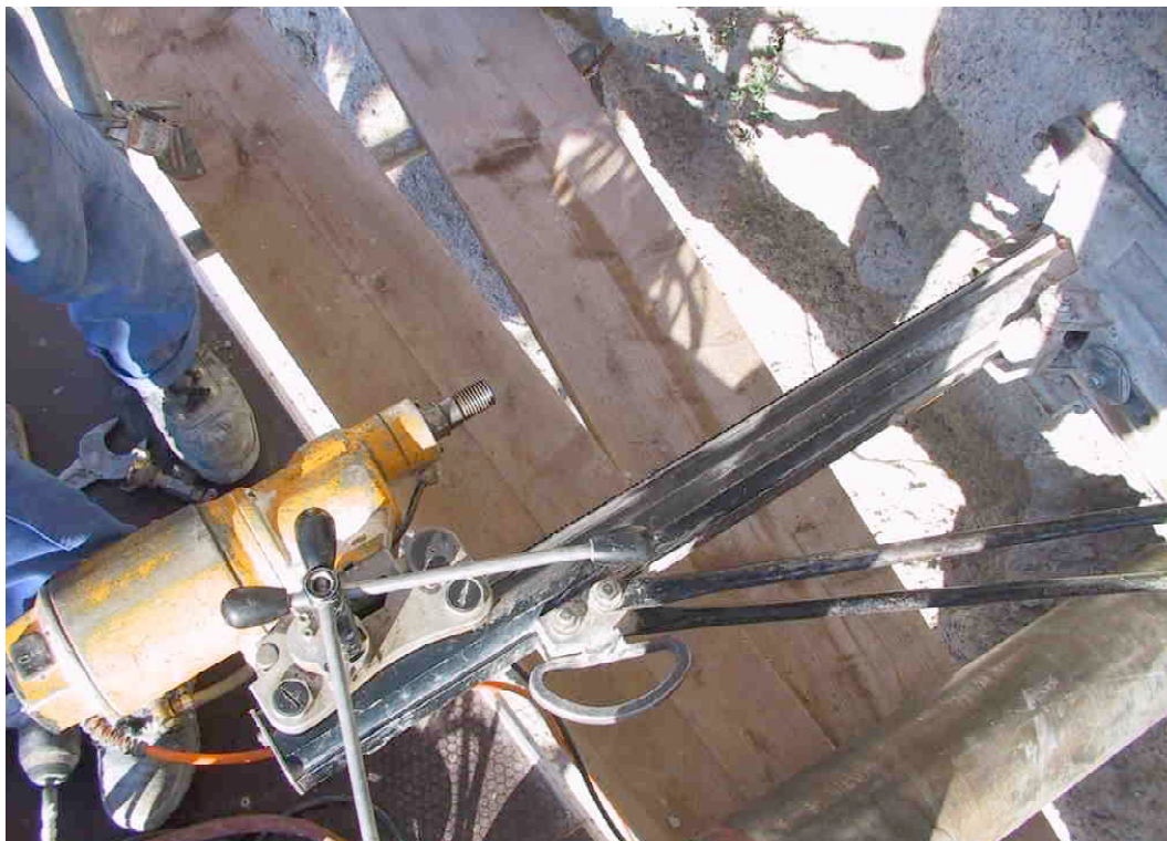
F 411 Bastion Glatzenstein Bohrkernentnahme A Oktober 2003 2003 S. Thole
