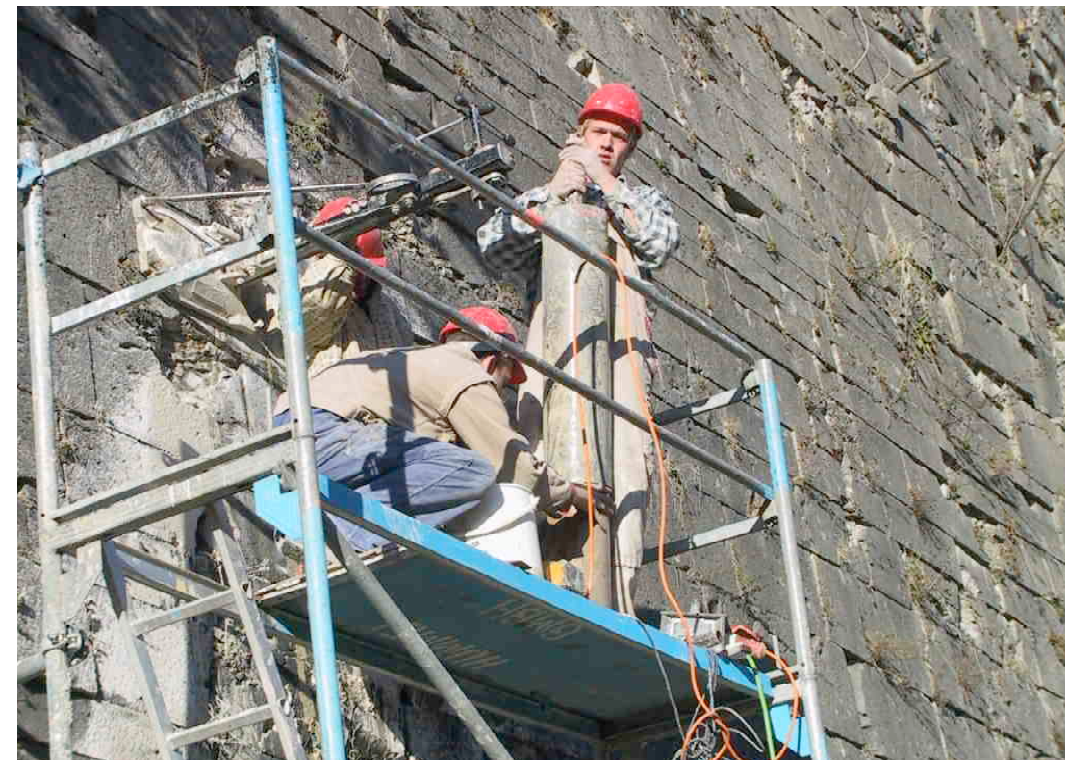
F 420 Kurtine zwischen den Bastionen Glatzenstein und Kersbach Entnahme von Bohrkern A 2 im Oktober 2003 2003 S. Thole
