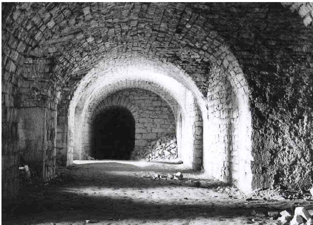
F 075 Kasematten Unter der Kommandantur 1966 Maul, Schnaittach Heimatverein Schnaittach
