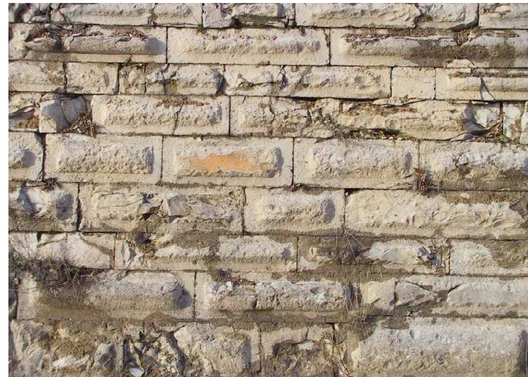
F 380 Kurtine zwischen den Bastionen Glatzenstein und Kersbach Profilierte Quader 2003 S. Thole
