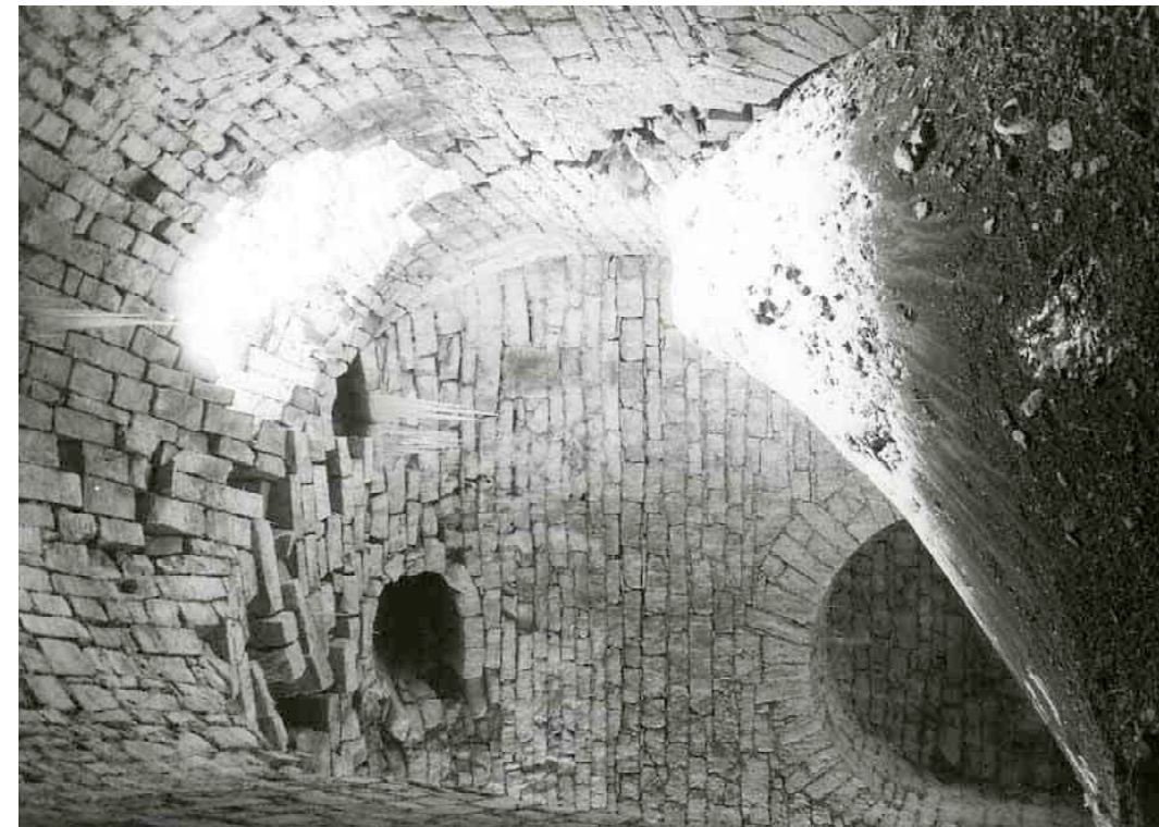
F 178 Bastion Glatzenstein Kasematte
