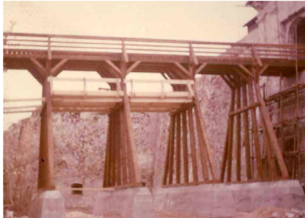
F 117 Brücke Bau durch die Bayrische Schlösserverwaltung 1968 Unbekannt Heimatverein Schnaittach
