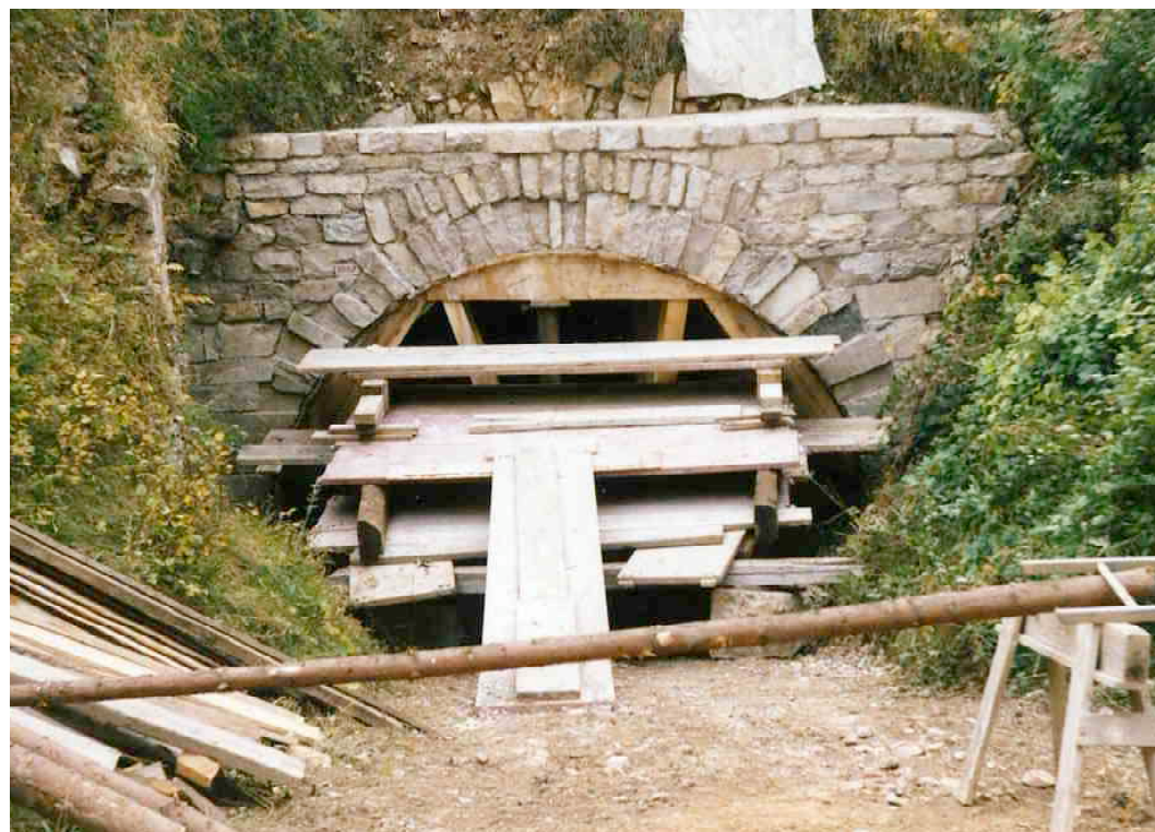
F 289 Zugang zu den Kasematten Stützkonstruktion
