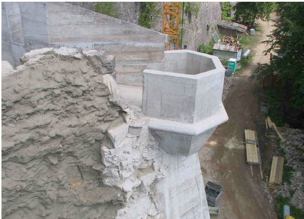
F 327 Bastion Glatzenstein Vorgespritzter Mauertorso und ausgebildetes Wachtürmchen 2003 S. Thole
