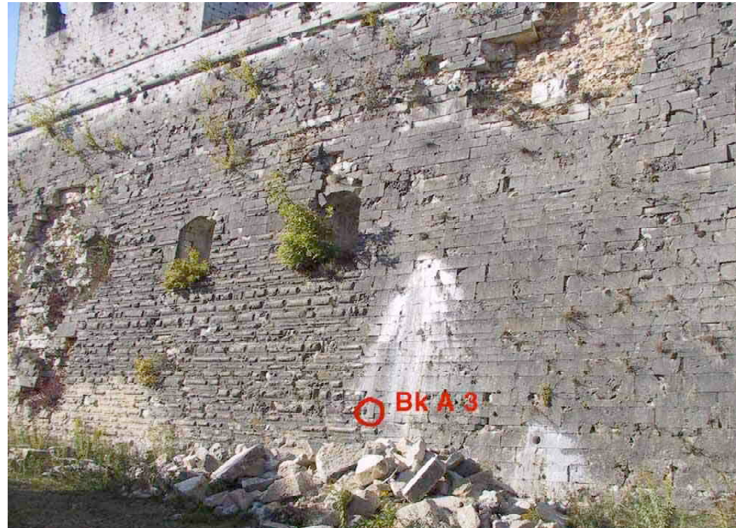
F 425 Kurtine zwischen den Bastionen Glatzenstein und Kersbach Lage von Bohrkernloch A 3 2003 S. Thole
