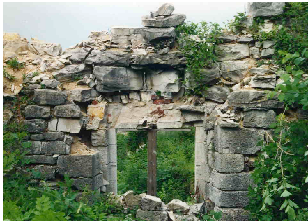
F 297 Karlskaserne Fensterbogen vor der Instandsetzung 1990 W. Kaschel Heimatverein Schnaittach
