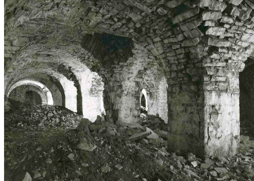
F 054 Kasematte Einbruch der Gewölbe
