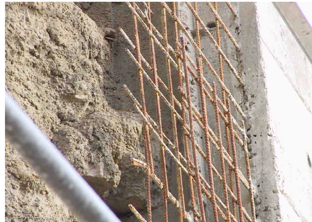
F 336 Armierung für die Betonverschalung
