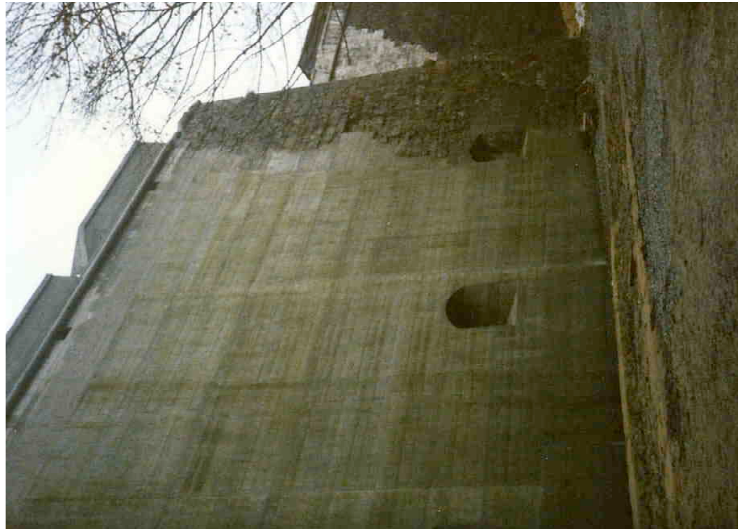
F 279 Bastion Karl Sanierte Nordface 1987 Unbekannt Heimatverein Schnaittach
