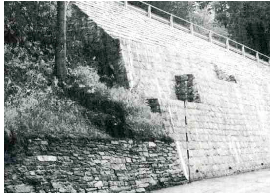
F 474 Wasseraustrittsöffnungen von Vertikaldrainagen 1989 A. Hegland, J. Simonett Straßen als Baudenkmäler
