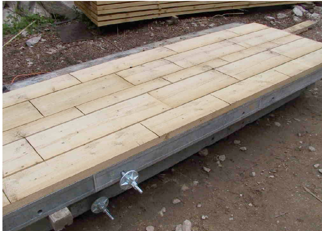
F 329 Holzbreter für die Betonverschalung
