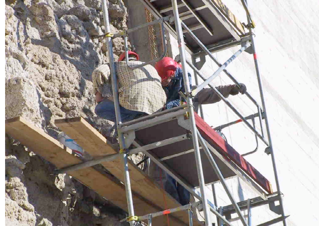
F 410 Bastion Glatzenstein Bohrkernentnahme A Oktober 2003 2003 S. Thole
