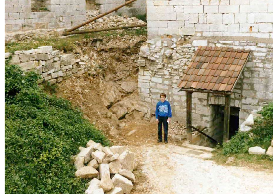
F 284 Kommandantur Aushubstelle für Stützmauer an der Ecke der Kommandantur 1987 W. Kaschel Heimatverein Schnaittach
