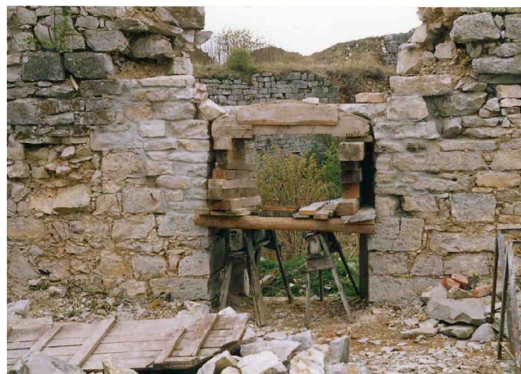
F 310 Karlskaserne, Südseite Renovierung eines Fensters 1991 W. Kaschel Heimatverein Schnaittach
