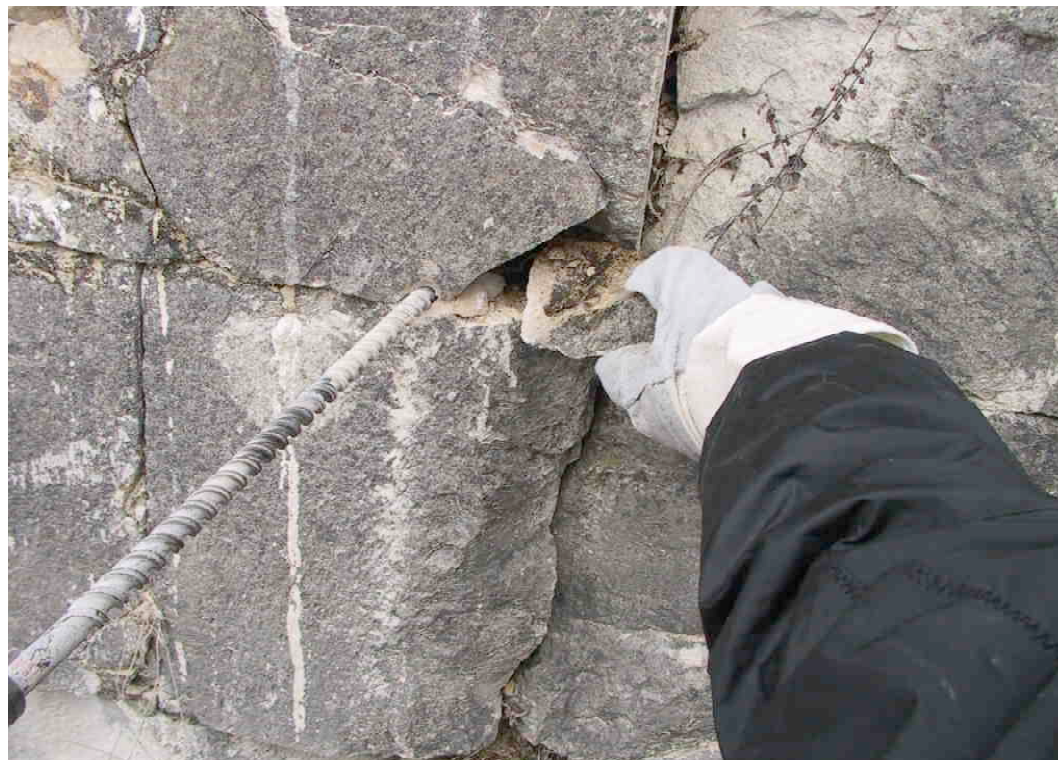
F 355 Verpressung 1 im November 2003 Vorbohren der Löcher 2003 S. Thole
