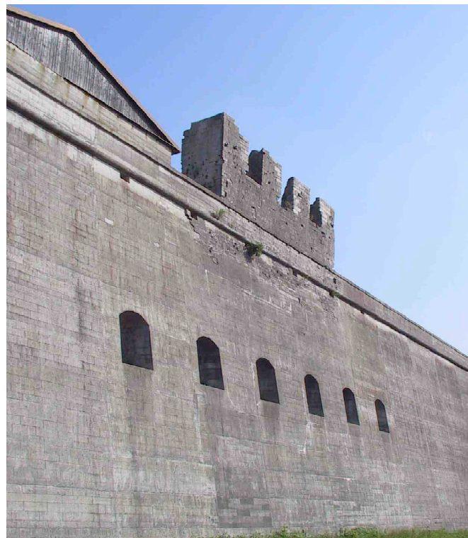
F 443 Kurtine zwischen den Bastionen Amalie und Schnaittach 2004 S. Thole
