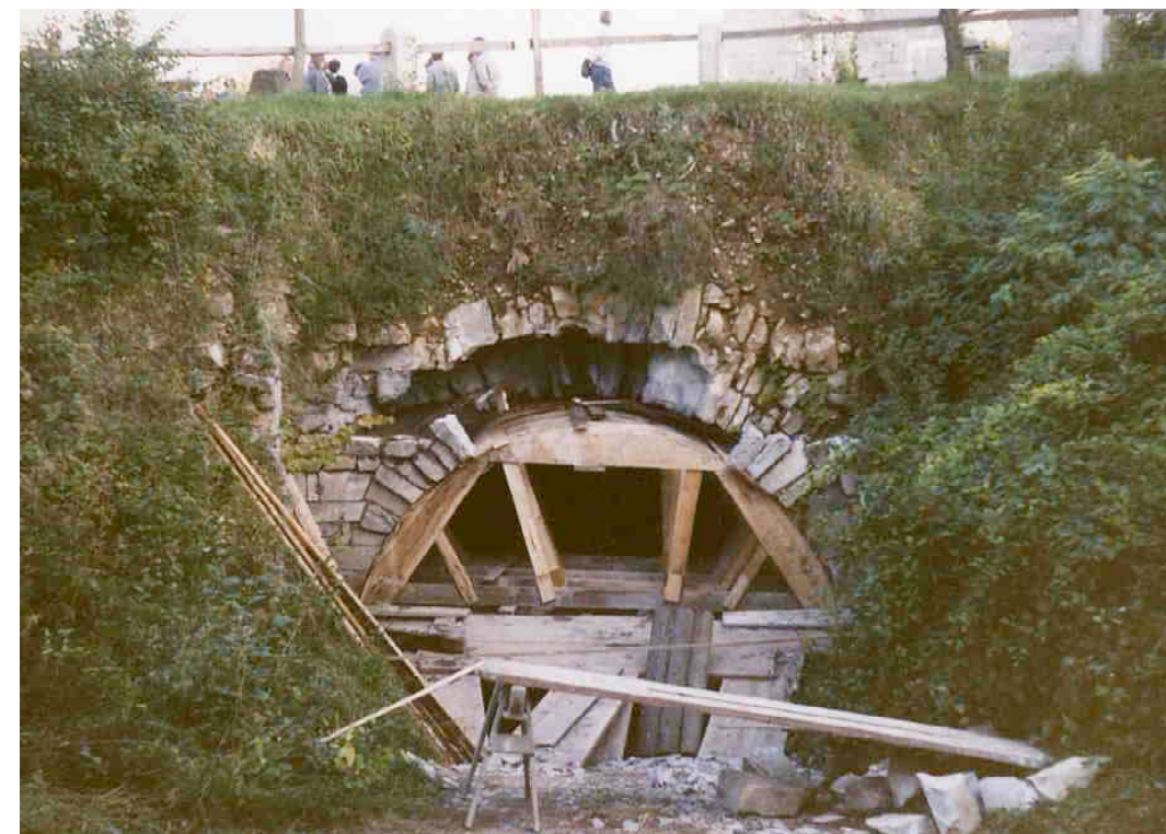
F 290 Zugang zu den Kasematten Stützkonstruktion
