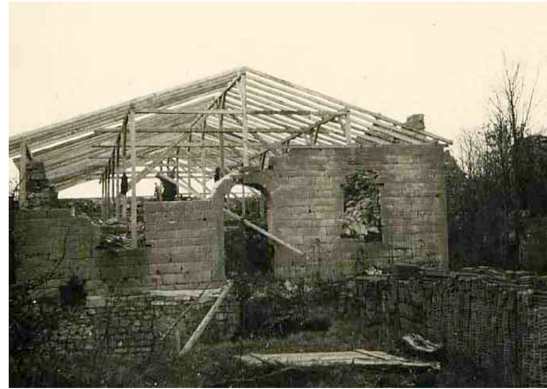
F 046 Kommandantur Bau der Überdachung
