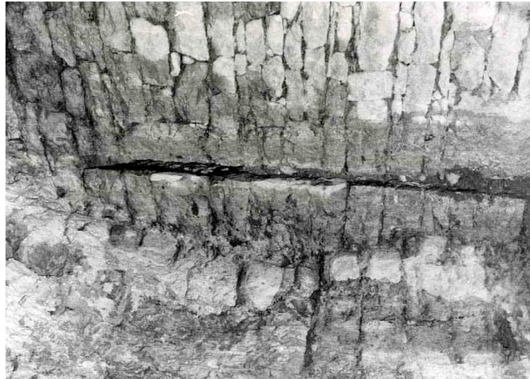
F 189 Bogenscharte Im "Kasemattensaal" 1982 O. Kohlmann Heimatverein Schnaittach
