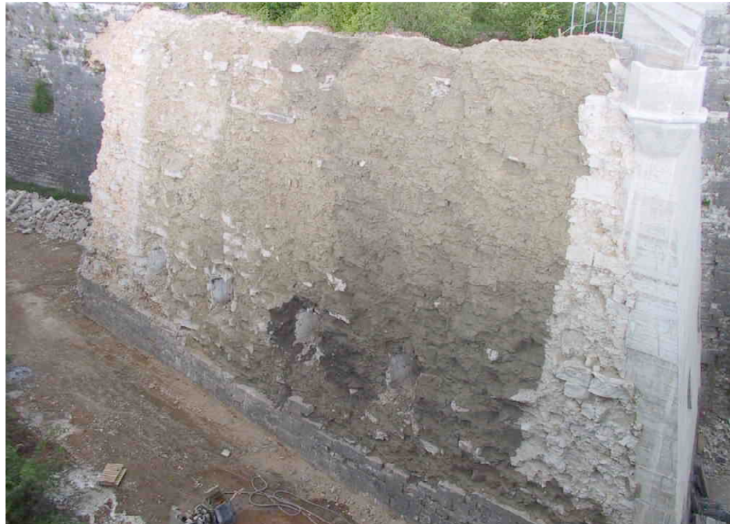
F 325 Bastion Glatzenstein Mauertorso, vorgespritzte Bastion 2003 S. Thole
