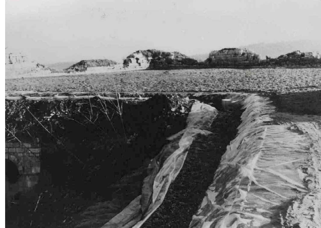
F 126 Bastion Kersbach Isolierung mit Folien 1970 W. Kaschel Heimatverein Schnaittach
