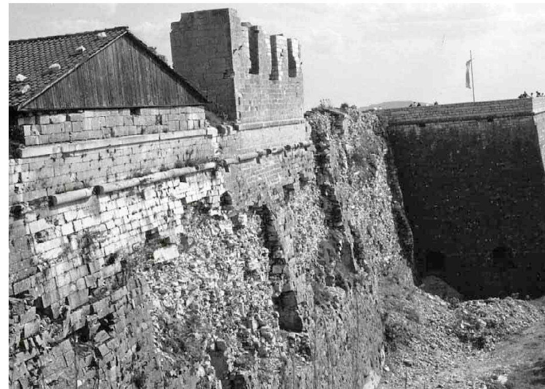
F 228 Kurtine zwischen den Bastionen Amalie und Schnaittach
