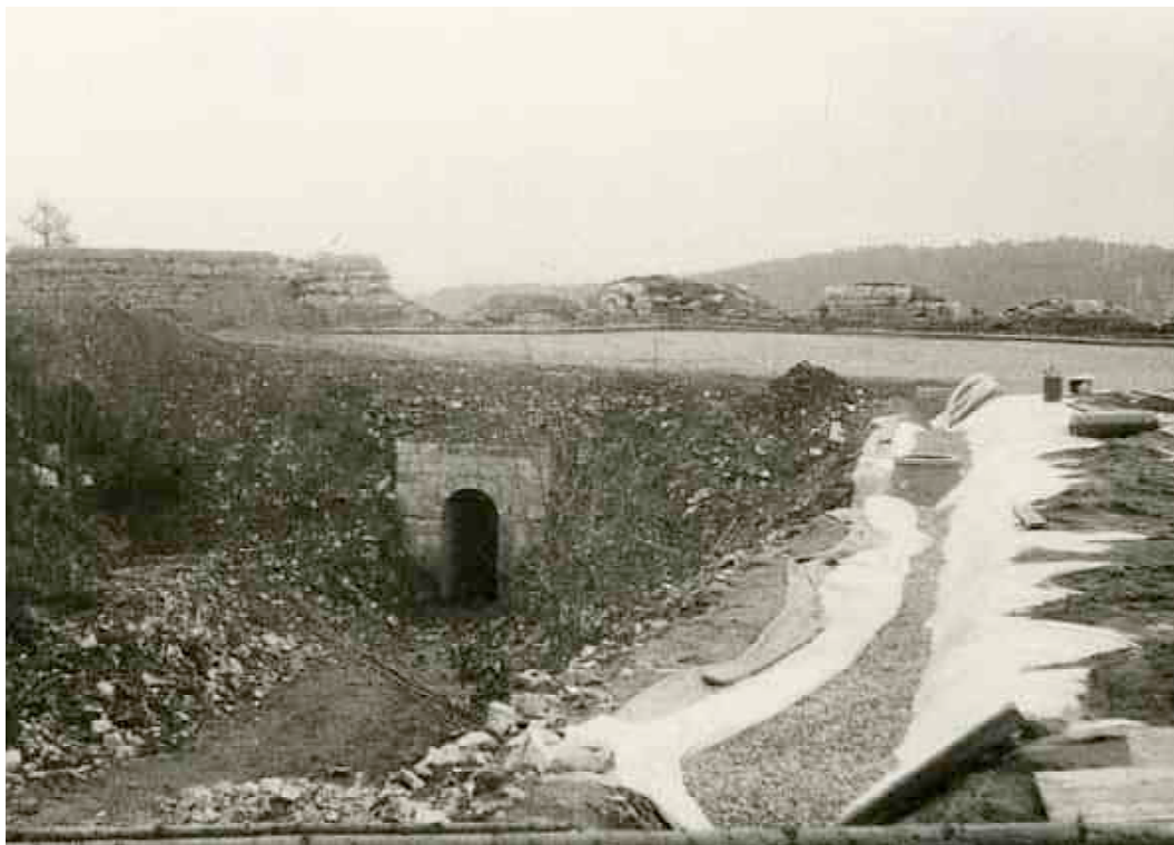
F 127 Bastion Nürnberg Isolierung mit Folie 1970 Unbekannt Heimatverein Schnaittach
