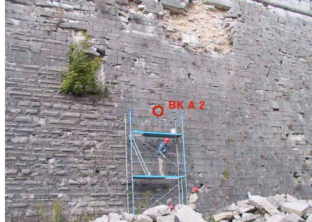
F 418 Kurtine zwischen den Bastionen Glatzenstein und Kersbach Vorbereitung zur Bohrkernentnahme A im Oktober 2003 2003 S. Thole
