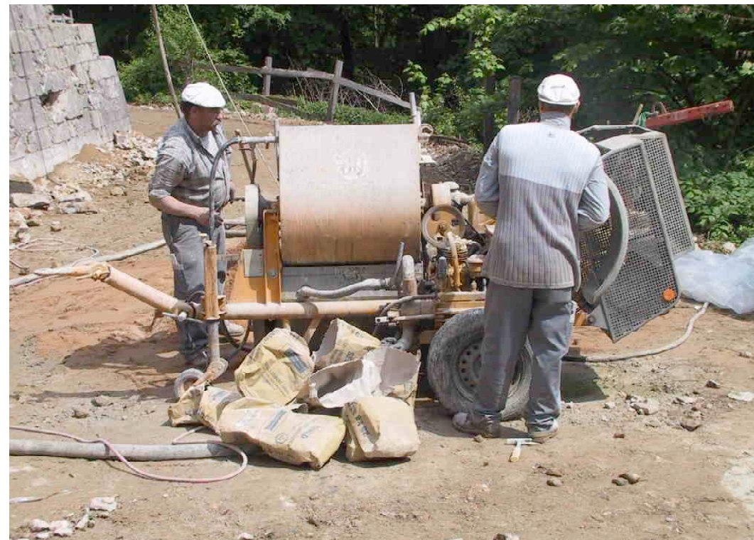
F 320 Bastion Glatzenstein Mörtelspritzmaschine 2003 S. Thole
