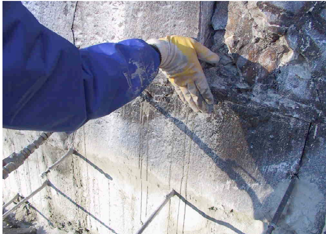
F 377 Verpressung 1 im November 2003 Fugenabdichtung 2003 S. Thole
