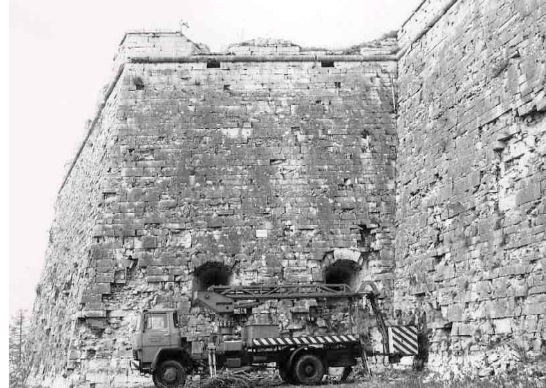
F 182 Bastion Kersbach und Kurtine nach Kersbach -Glatzenstein Bewuchsentfernung
