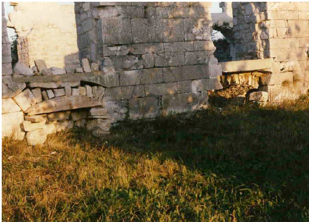
F 281 Zeughaus, Ostflügel Bögen über den Luftschachtöffnungen 1987 W. Kaschel Heimatverein Schnaittach
