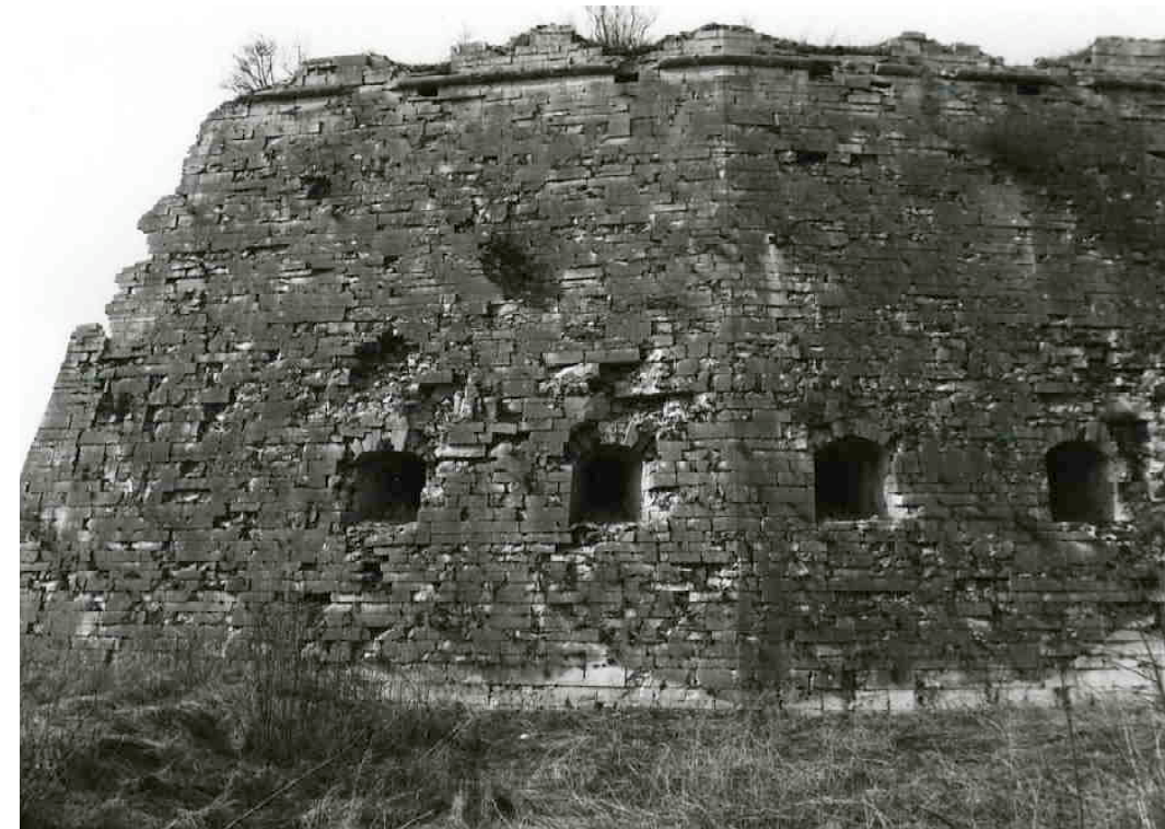
F 268 Bastion Nürnberg Zustand 1986
