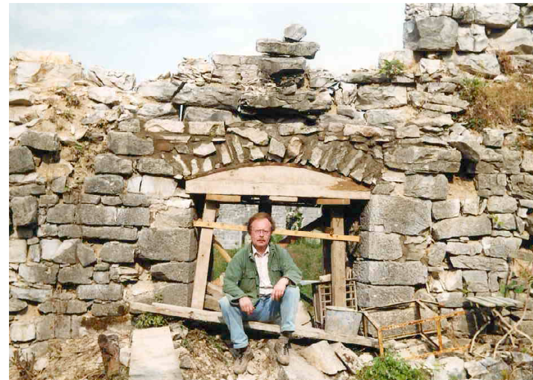
F 298 Karlskaserne Fensterbogen nach der Instandsetzung durch W. Kaschel 1990 W. Kaschel Heimatverein Schnaittach
