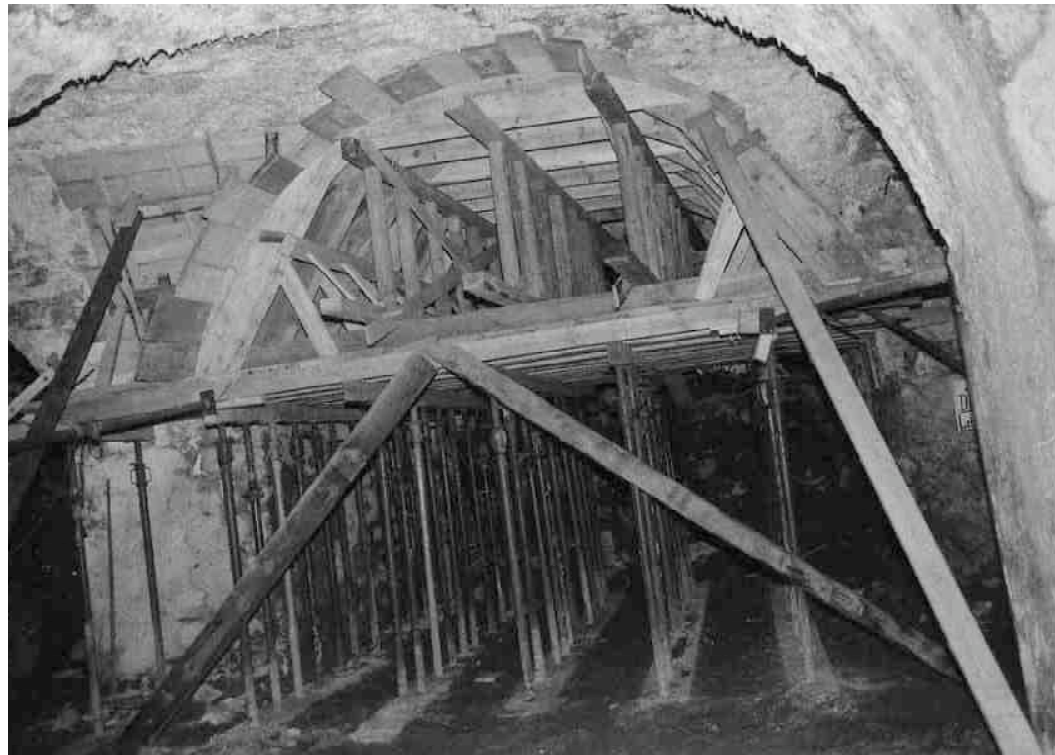
F 177 Kreuzgewölbe Verschalung des Loches
