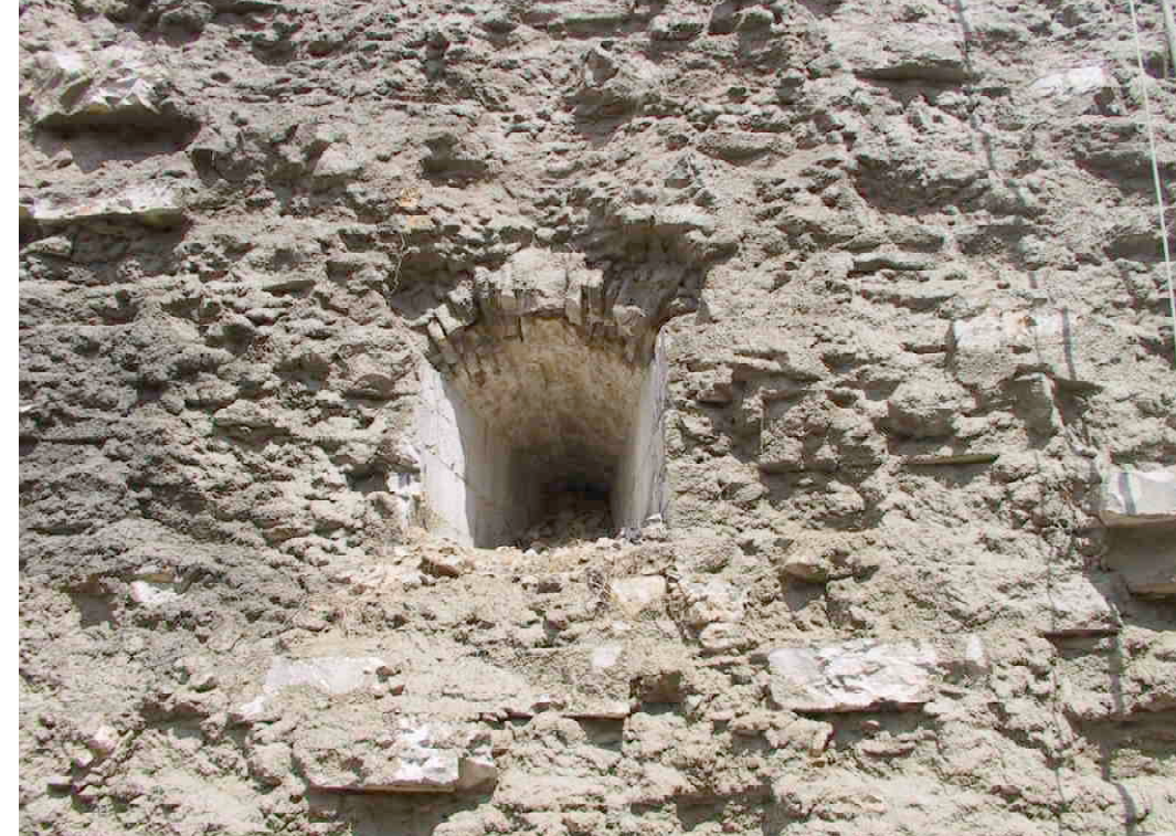
F 322 Bastion Glatzenstein Spritzmörtel auf Mauertorso
