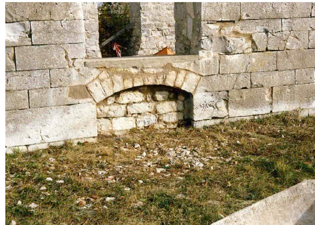
F 282 Zeughaus, Ostflügel Saniertter Bogen über den Luftschachtöffnungen 1987 W. Kaschel Heimatverein Schnaittach
