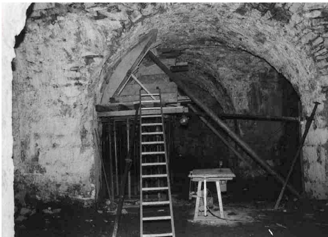
F 179 Kreuzgewölbe Verschalung des Loches
