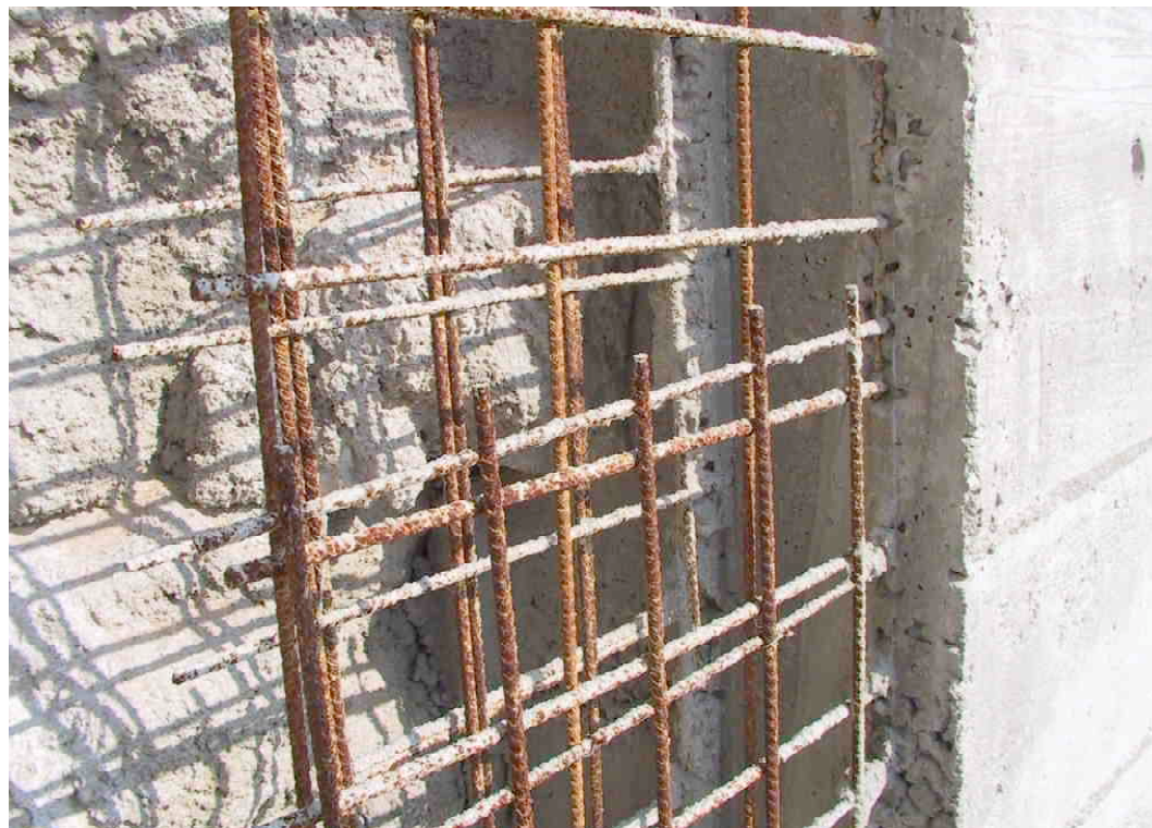
F 335 Armierung für die Betonverschalung
