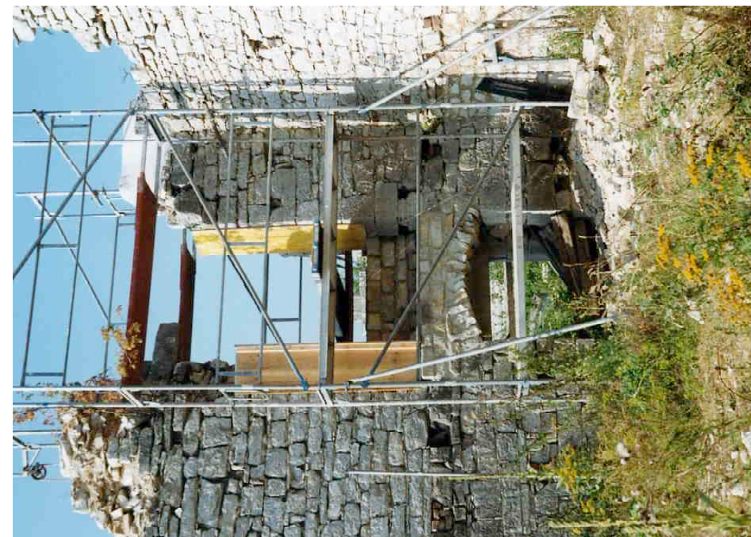
F 302 Karlskaserne, Mittelteil Einfügen einer Fensterrahmung 1990 W. Kaschel Heimatverein Schnaittach
