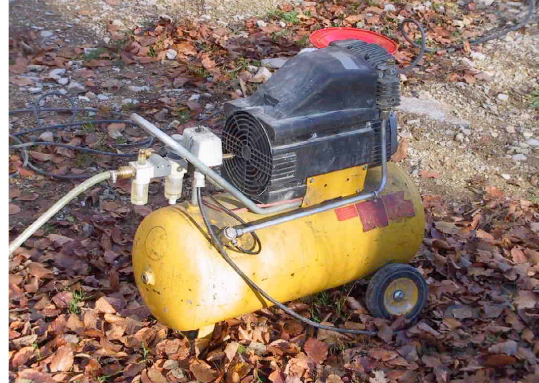
F 370 Verpressung 1 im November 2003 Druckluftgerät 2003 S. Thole
