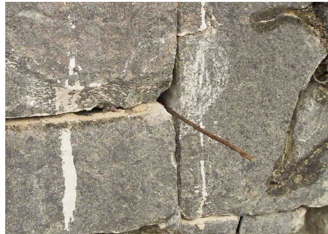
F 356 Verpressung 1 im November 2003 Vorgebohrtes Loch 2003 S. Thole
