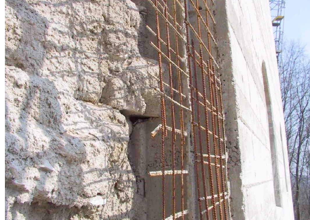
F 334 Armierung für die Betonverschalung
