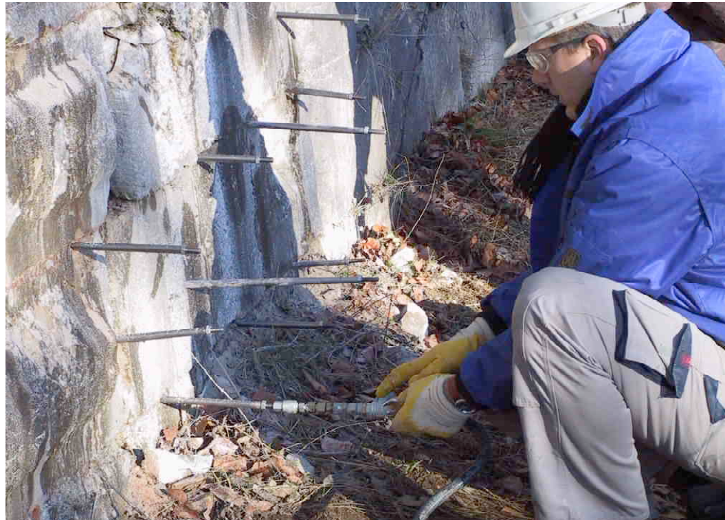
F 373 Verpressung 1 im November 2003 Steinreihenweise Verpressung 2003 S. Thole
