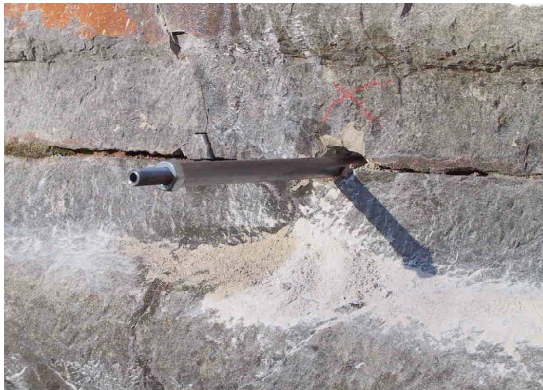
F 359 Verpressung 1 im November 2003 Eingesetzter Packer 2003 S. Thole
