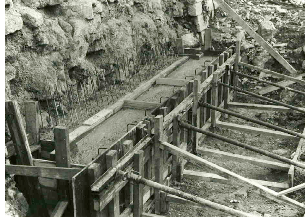
F 234 Kurtine zwischen den Bastionen Amalie und Schnaittach Betonfundament für die Mauerverschalung 1984 A. Wörler Heimatverein Schnaittach
