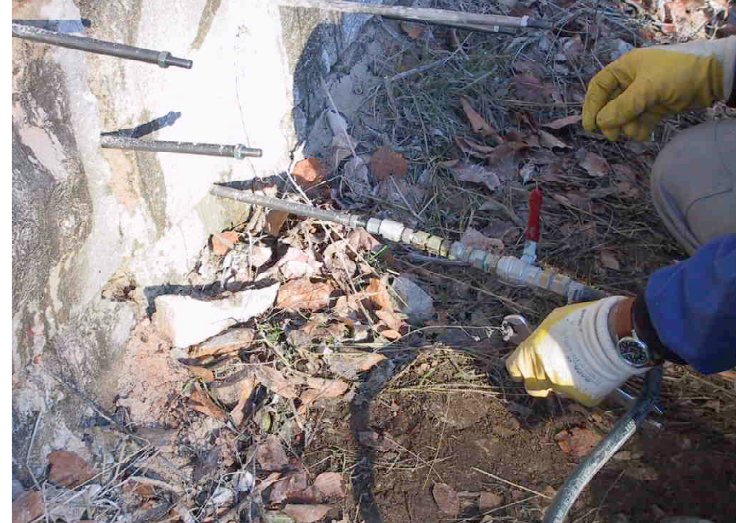
F 374 Verpressung 1 im November 2003 Steinreihenweise Verpressung 2003 S. Thole
