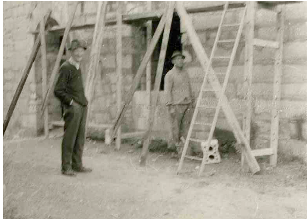
F 161 Karlskaserne, Westfront Aufmauern und Verfugen der Mauern 1976 W. Kaschel Heimatverein Schnaittach
