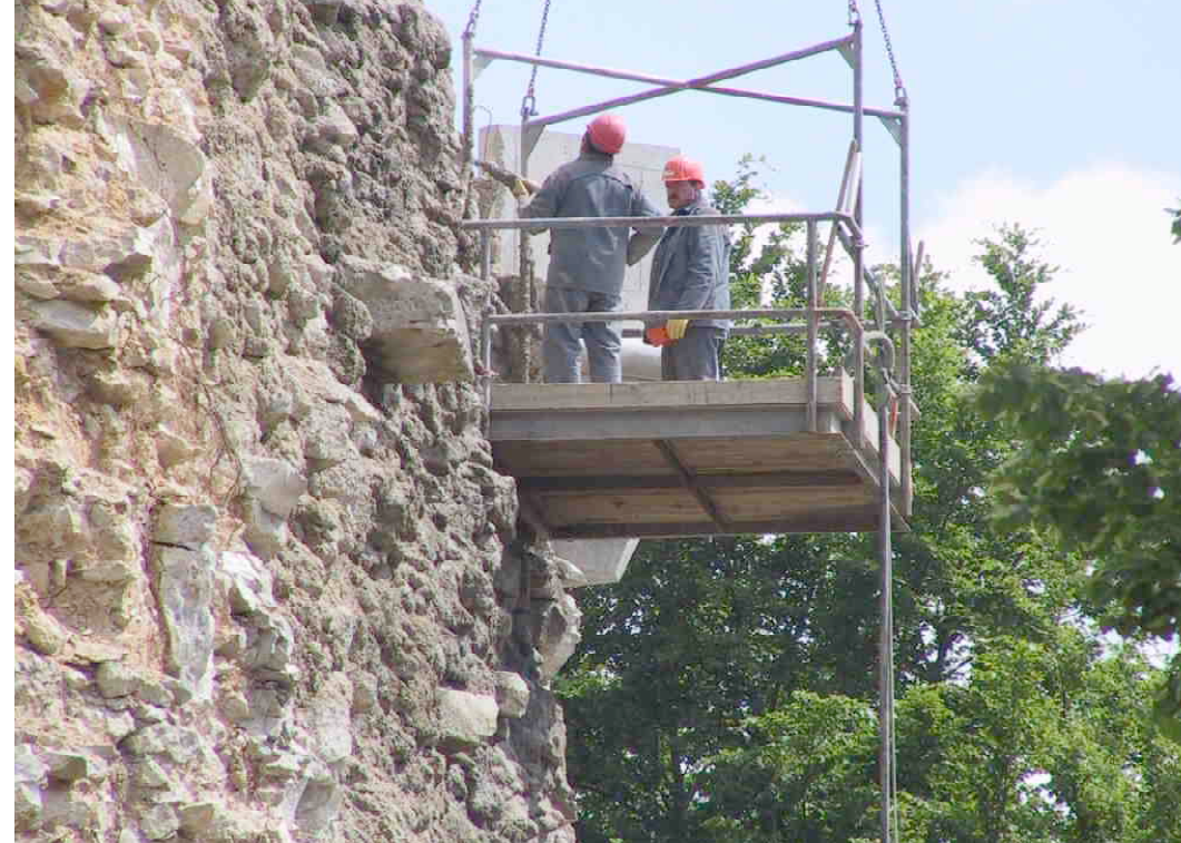
F 318 Bastion Glatzenstein Torso der Hinterfüllung 2003 S. Thole
