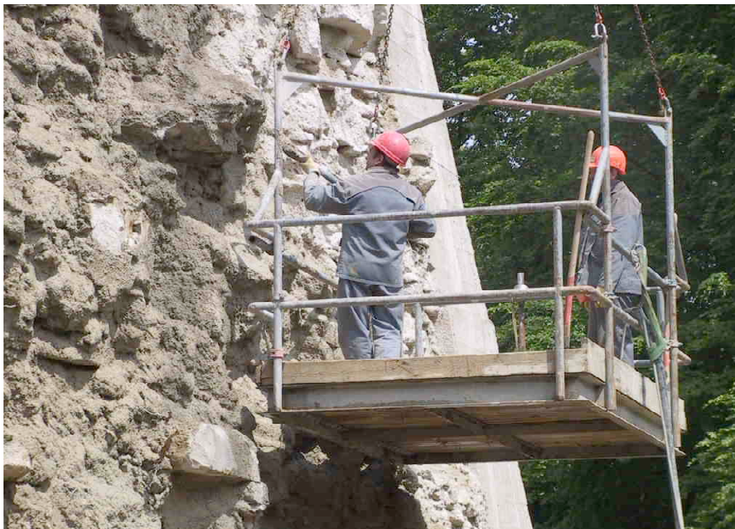
F 319 Bastion Glatzenstein Sicherung mit Spritzmörtel 2003 S. Thole
