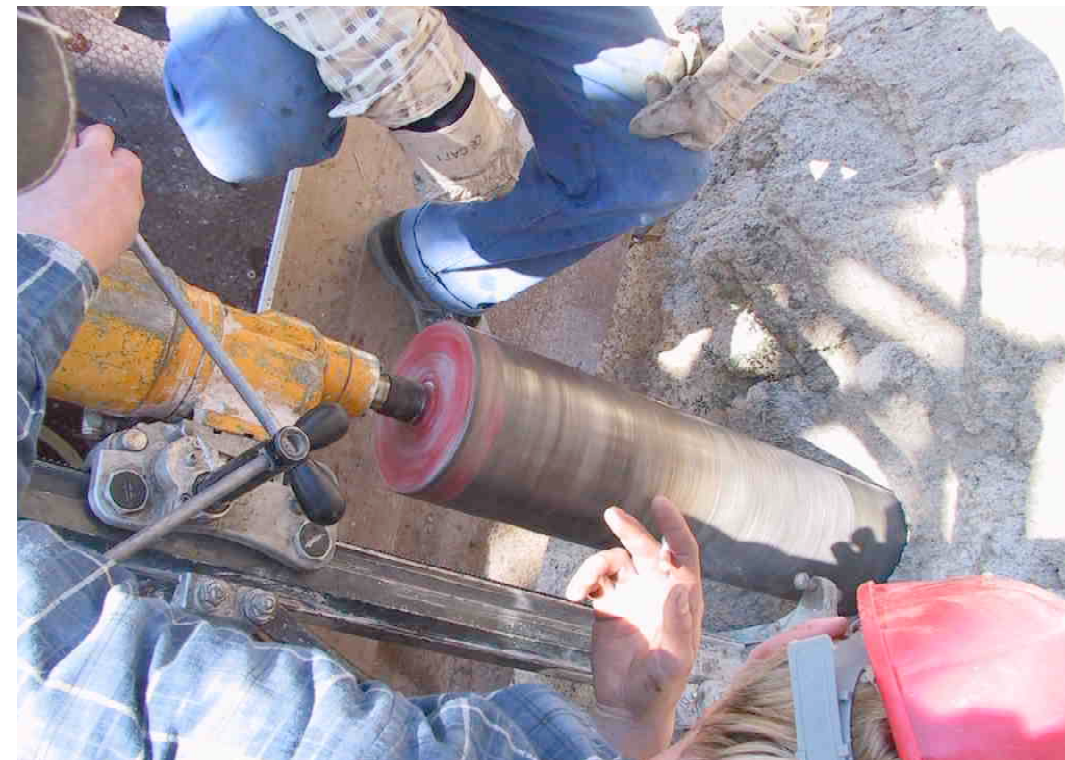
F 412 Bastion Glatzenstein Bohrkernentnahme A Oktober 2003 2003 S. Thole
