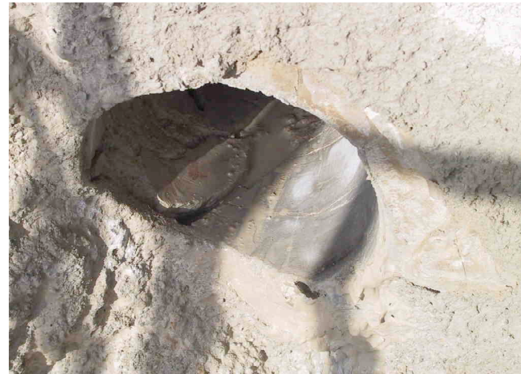
F 414 Bohrkernloch A 1 Bastion Glatzenstein im Oktober 2003 2003 S. Thole
