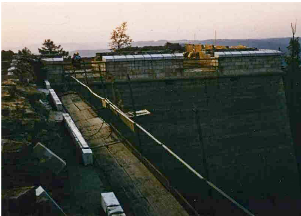
F 139 Portalkurtine und Bastion Amalie Instandsetzung der Brüstung 1975 W. Kaschel Heimatverein Schnaittach
