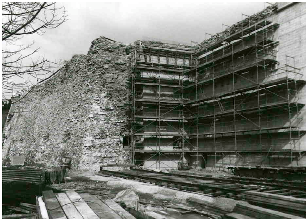
F 267 Bastion Amalie und Kurtine Instandsetzungsarbeiten
