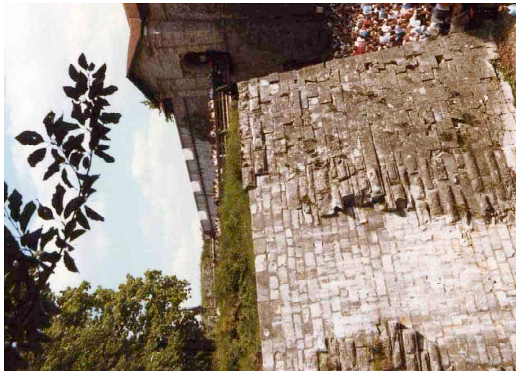
F 227 Ravelin und Torhaus Sanierte Mauerfläche
