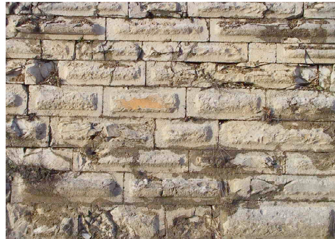
F 312b Südostkurtine Kersbach-Glatzenstein Bossierte Quader 2003 S. Thole
