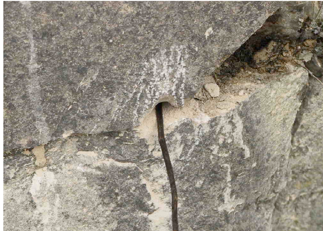
F 357 Verpressung 1 im November 2003 Vorgebohrtes Loch 2003 S. Thole
