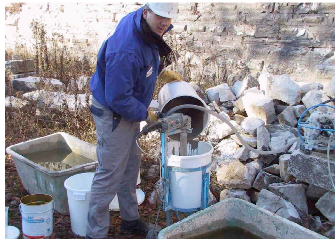
F 368 Verpressung 1 im November 2003 Vorratsbehälter 2003 S. Thole
