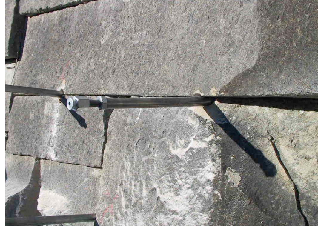
F 358 Verpressung 1 im November 2003 Eingesetzte Packer 2003 S. Thole
