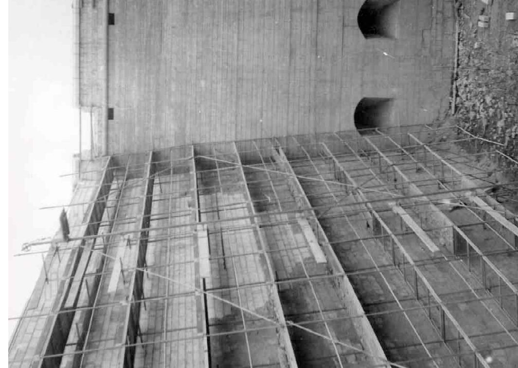
F 150 Portalkurtine zwischen Bastion Amalie und Portal Betonsanierung durch die Schlösserverwaltung 1974 H. Neumann, Jülich Heimatverein Schnaittach
