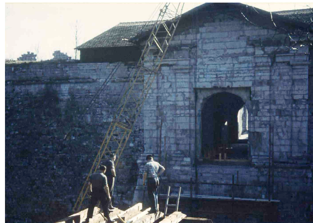
F 112 Portal Brückenbau durch die Bayerische Schlösserverwaltung
