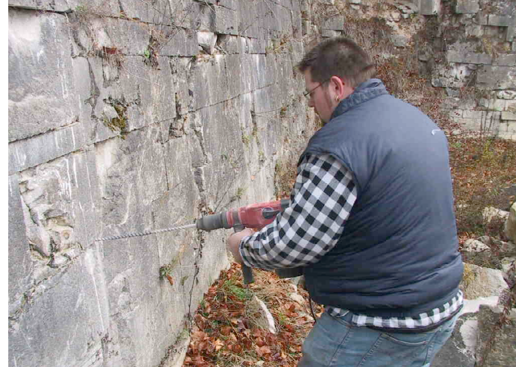
F 353 Verpressung 1 im November 2003 Vorbohren der Löcher 2003 S. Thole
