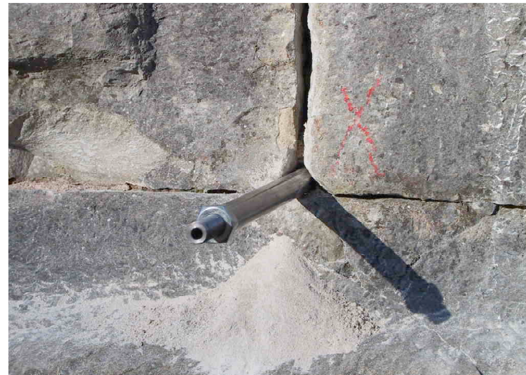
F 360 Verpressung 1 im November 2003 Eingesetzter Packer 2003 S. Thole
