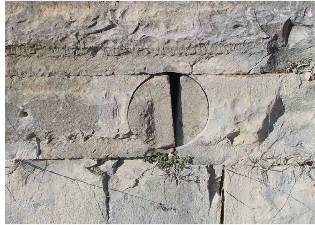
F 426 Bohrkern A 3 "Bosse" Kurtine zwischen den Bastionen Glatzenstein und Kersbach 2003 S. Thole
