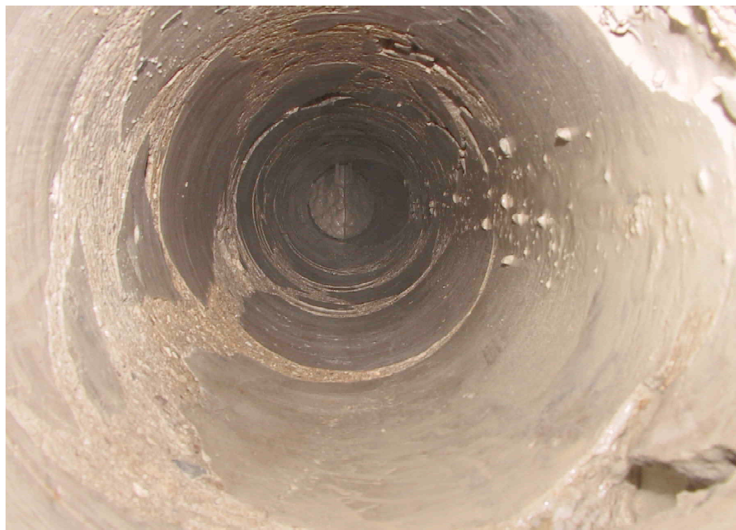
F 415 Blick in Bohrkernloch A 1 Bastion Glatzenstein im Oktober 2003 2003 S. Thole
