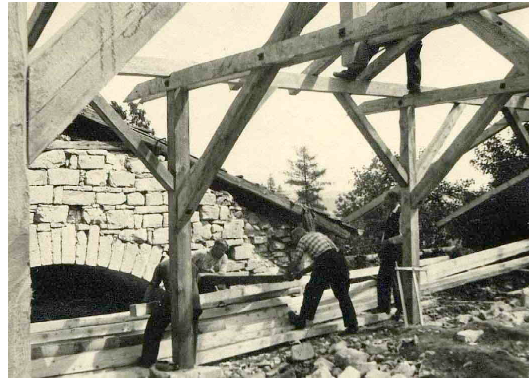
F 040 Bau des Daches über dem Torhaus Um 1950 Unbekannt
