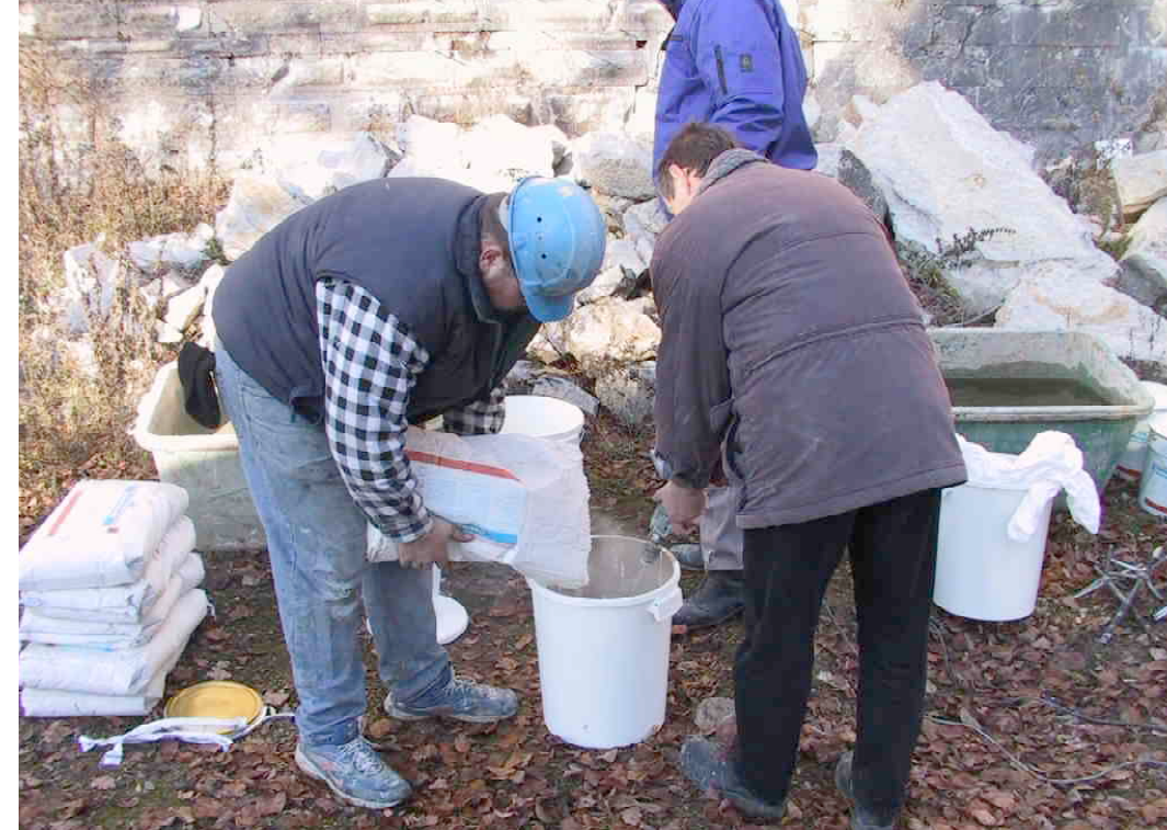
F 366 Verpressung 1 im November 2003 Anmischen des Verpressungsmaterials 2003 S. Thole
