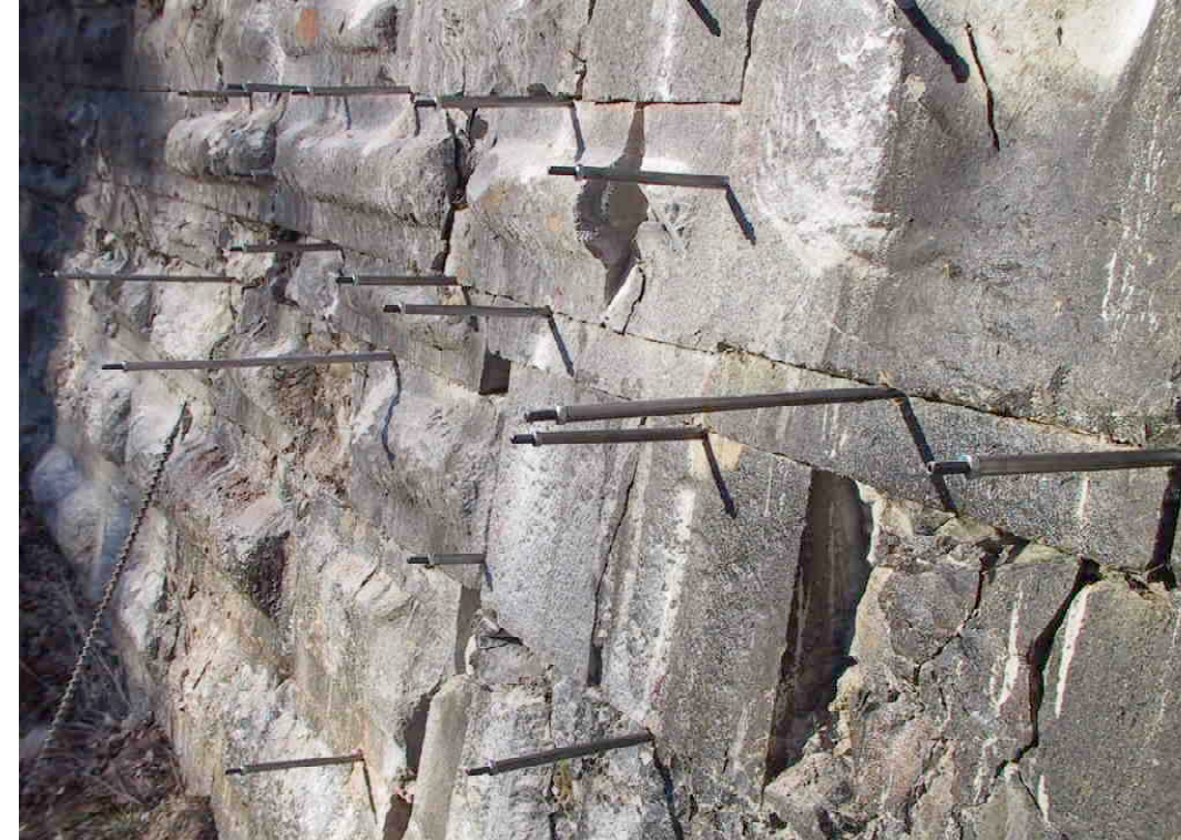
F 362 Verpressung 1 im November 2003 Eingesetzte Packer 2003 S. Thole
