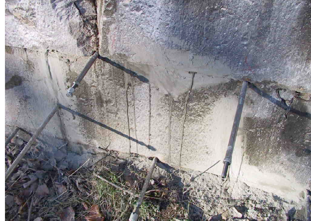
F 378 Verpressung 1 im November 2003 Fugenabdichtung 2003 S. Thole
