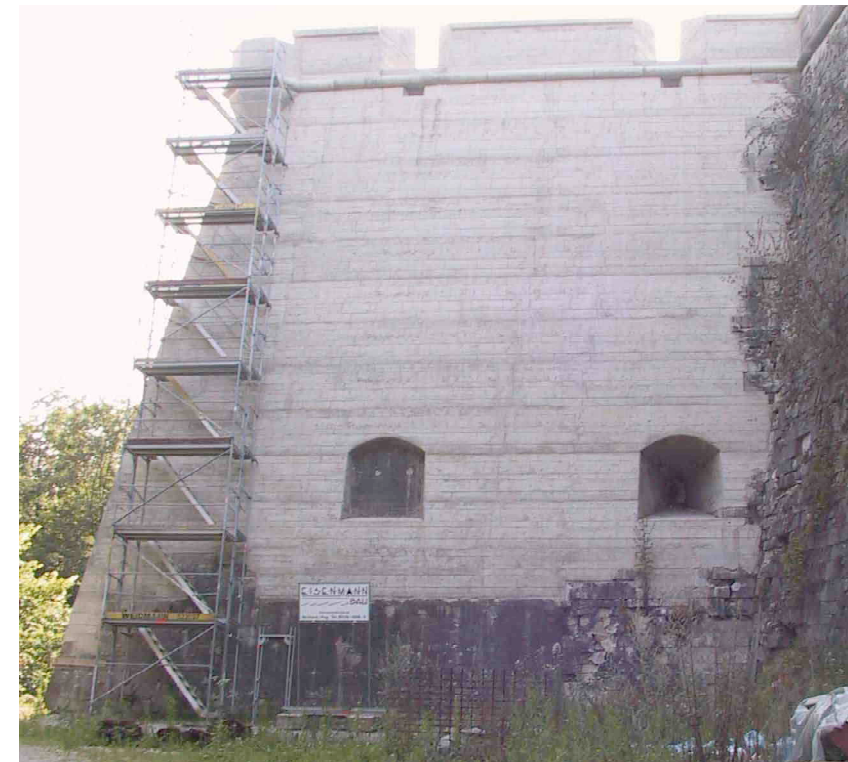
F 442 Bastion Glatzenstein Nordflanke 2004 S. Thole
