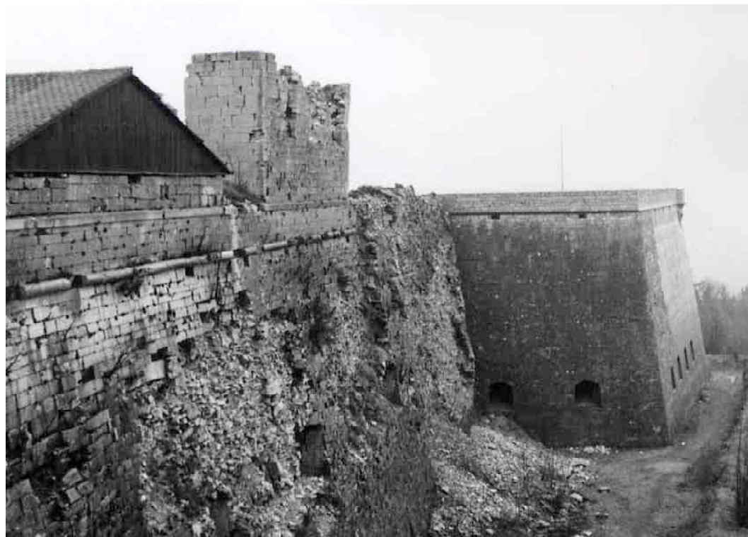
F 191 Kurtine zwischen den Bastionen Amalie und Schnaittach Abbruch des Mauermantels 1980/81 W. Landkammer Heimatverein Schnaittach
