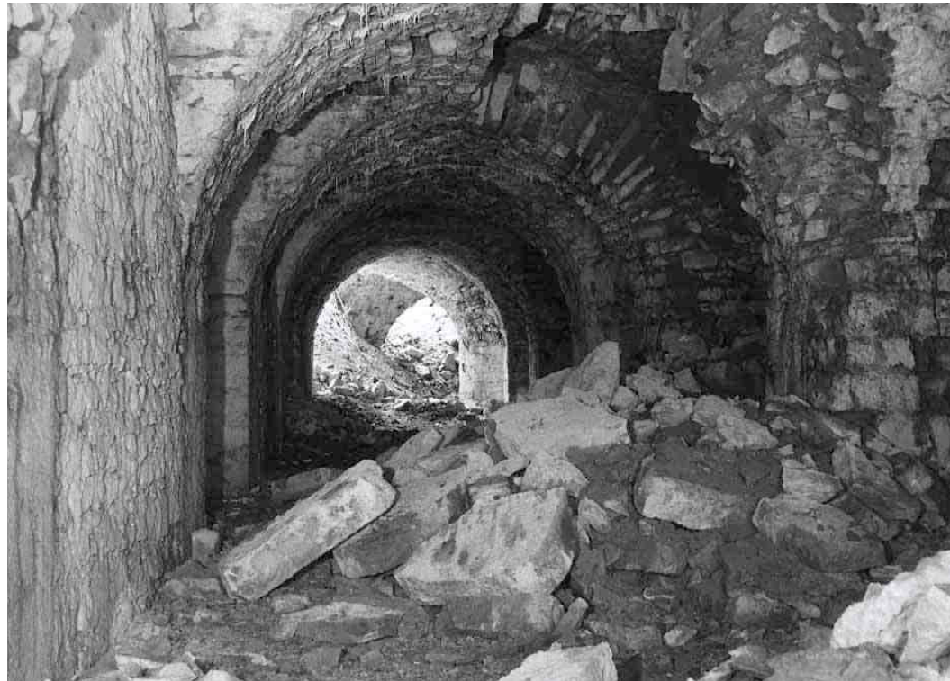
F 081 Kasematten Unter der Kommandantur 1966 Maul, Schnaittach Heimatverein Schnaittach
