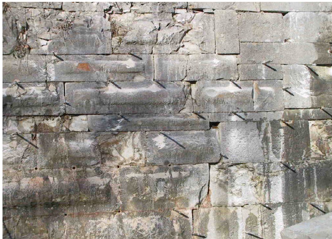
F 363 Verpressung 1 im November 2003 Eingesetzte Packer 2003 S. Thole
