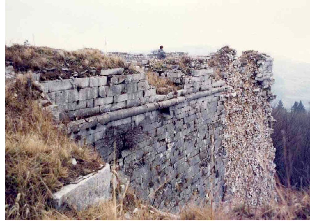
F 186 Bastion Kersbach Wulstkante, Abzugsschachtloch und Mauerschäden 1983 A. Wörler Heimatverein Schnaittach
