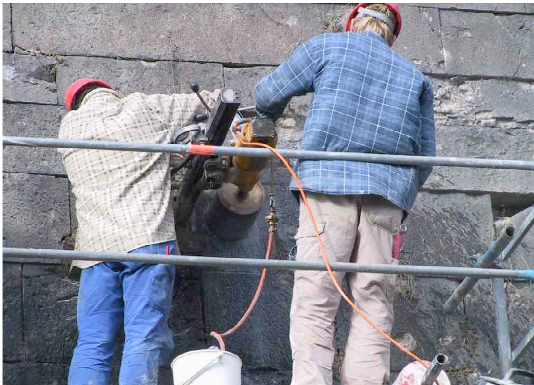
F 419 Kurtine zwischen den Bastionen Glatzenstein und Kersbach Entnahme von Bohrkern A 2 im Oktober 2003 2003 S. Thole
