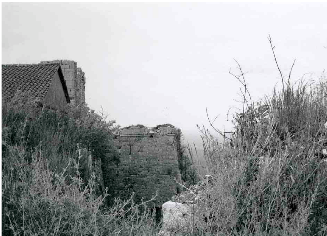
F 071 Bastion Schnaittach Ansicht von Bastion Amalie
