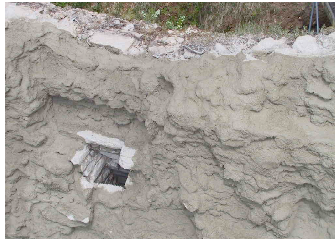
F 324 Bastion Glatzenstein Spritzmörtel auf Mauertorso
