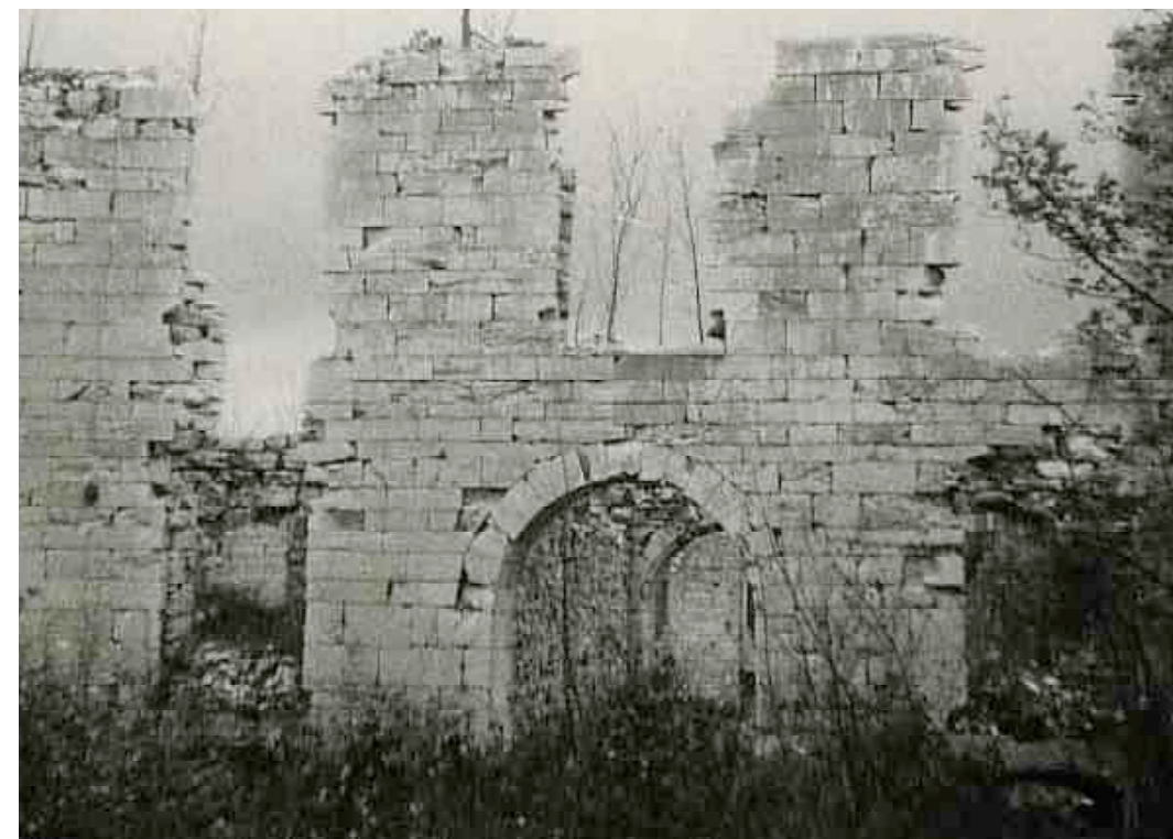
F 032 Zeughaus Ansicht von Süden
