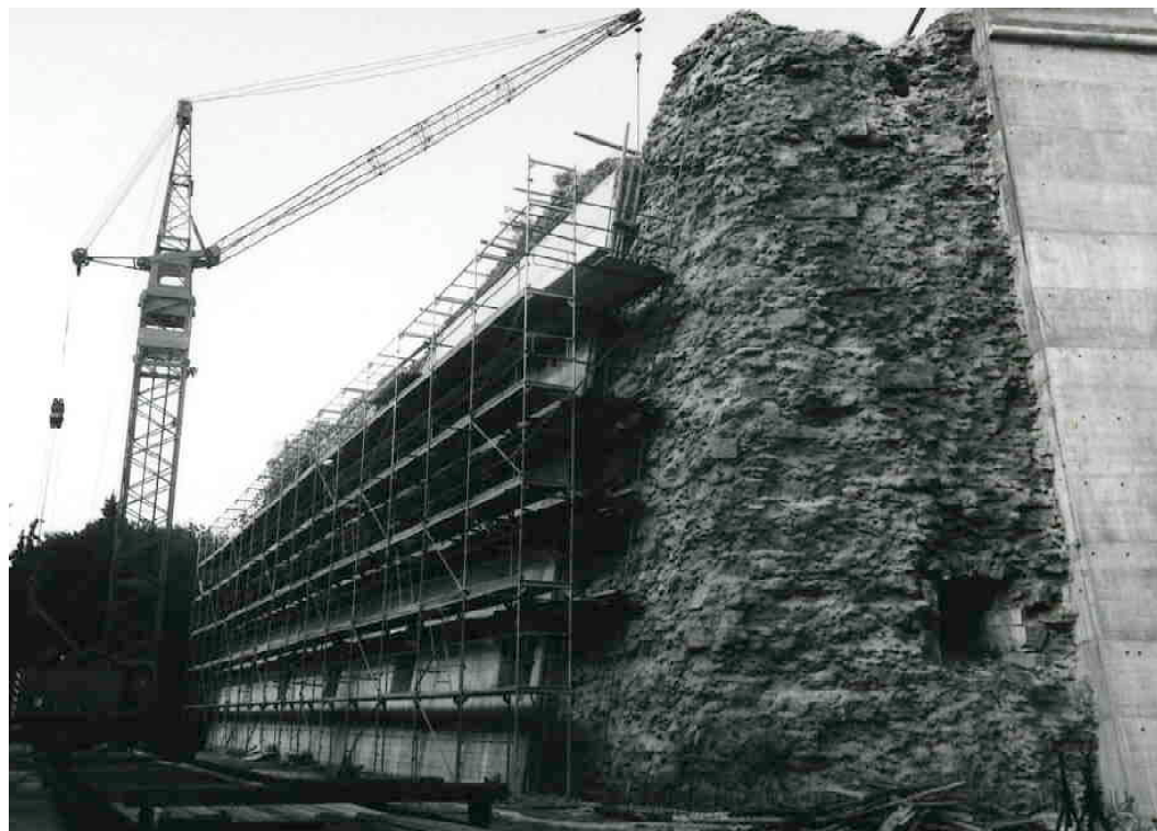
F 259 Bastion Amalie Instandsetzungsarbeiten
