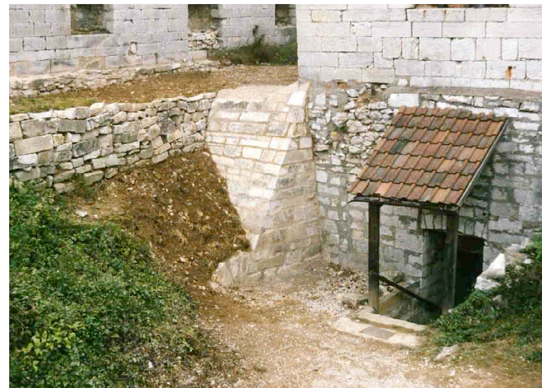
F 286 Kommandantur Fertige Stützmauer an der Ecke 1987 W. Kaschel Heimatverein Schnaittach
