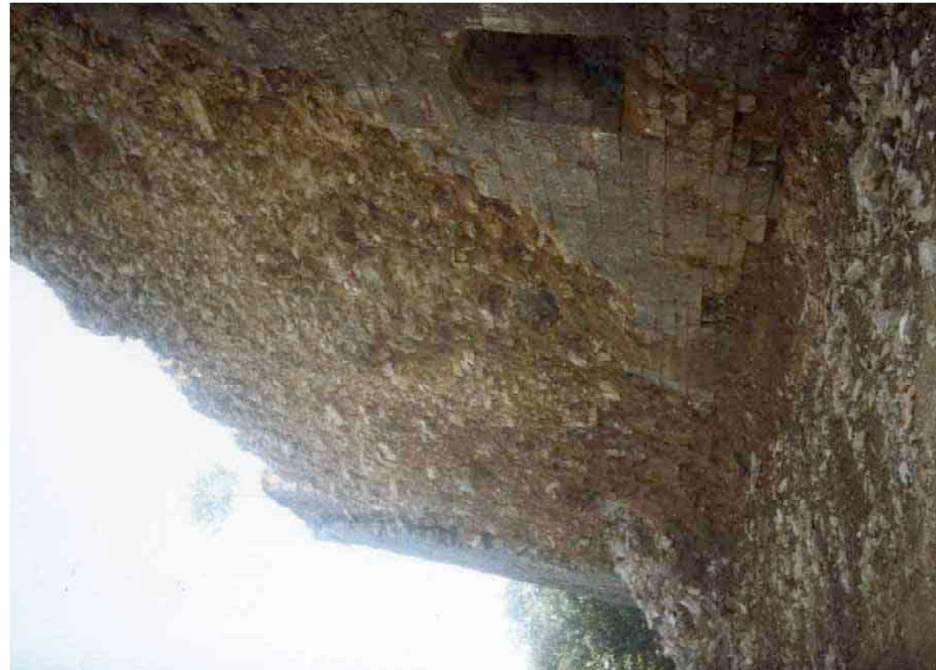
F 275 i Bastion Karl Nordface vor der Sanierung 1985 Unbekannt
