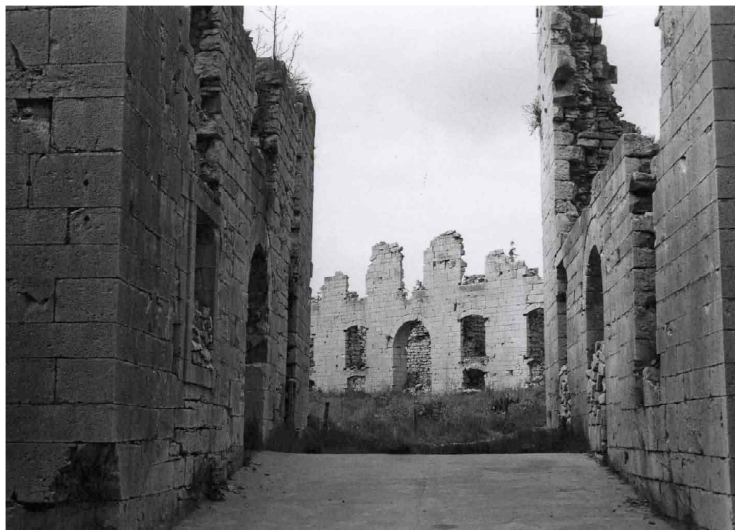
F 059 Karlskaserne Zeughaus Amalienkaserne Blick vom Torhaus 1966 Maul, Schnaittach Heimatverein Schnaittach
