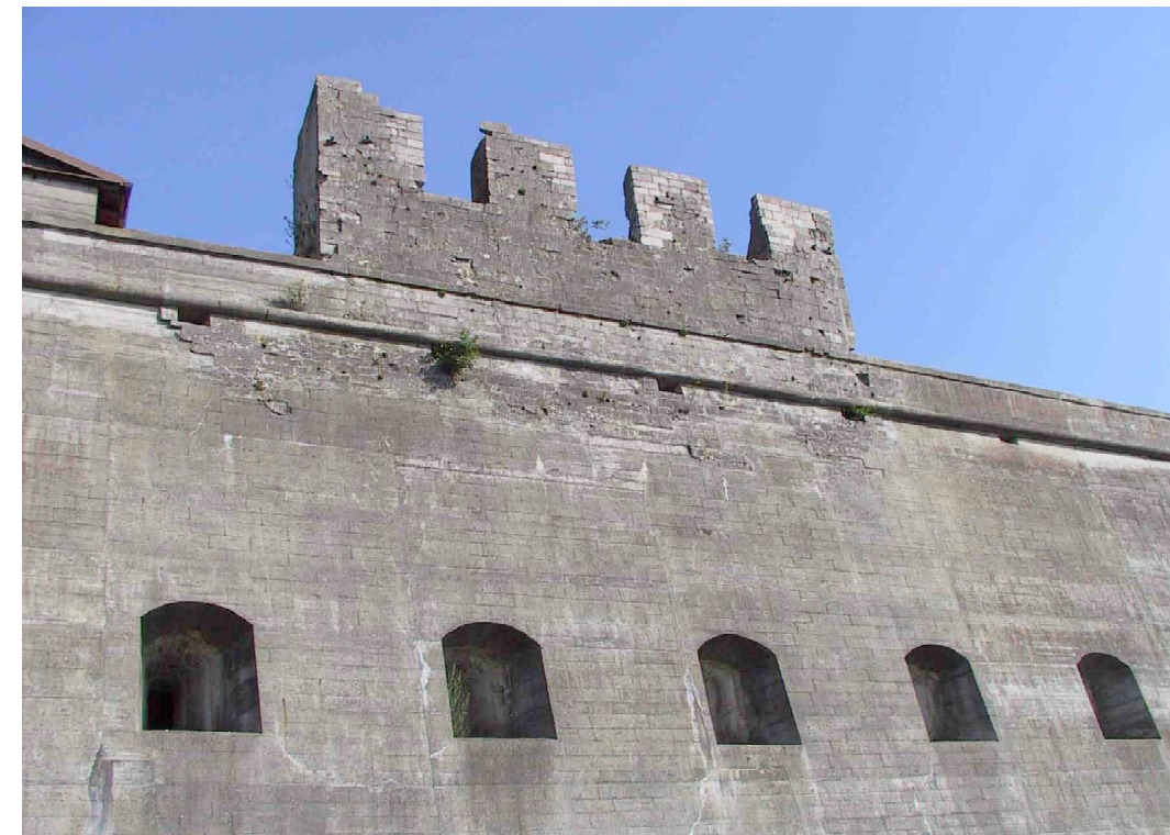
F 444 Kurtine zwischen den Bastionen Amalie und Schnaittach 2004 S. Thole
