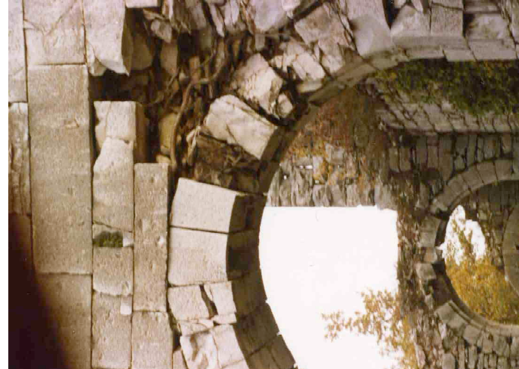
F 166 Zeughaus Durchgang von der Südseite 1978 Unbekannt Heimatverein Schnaittach
