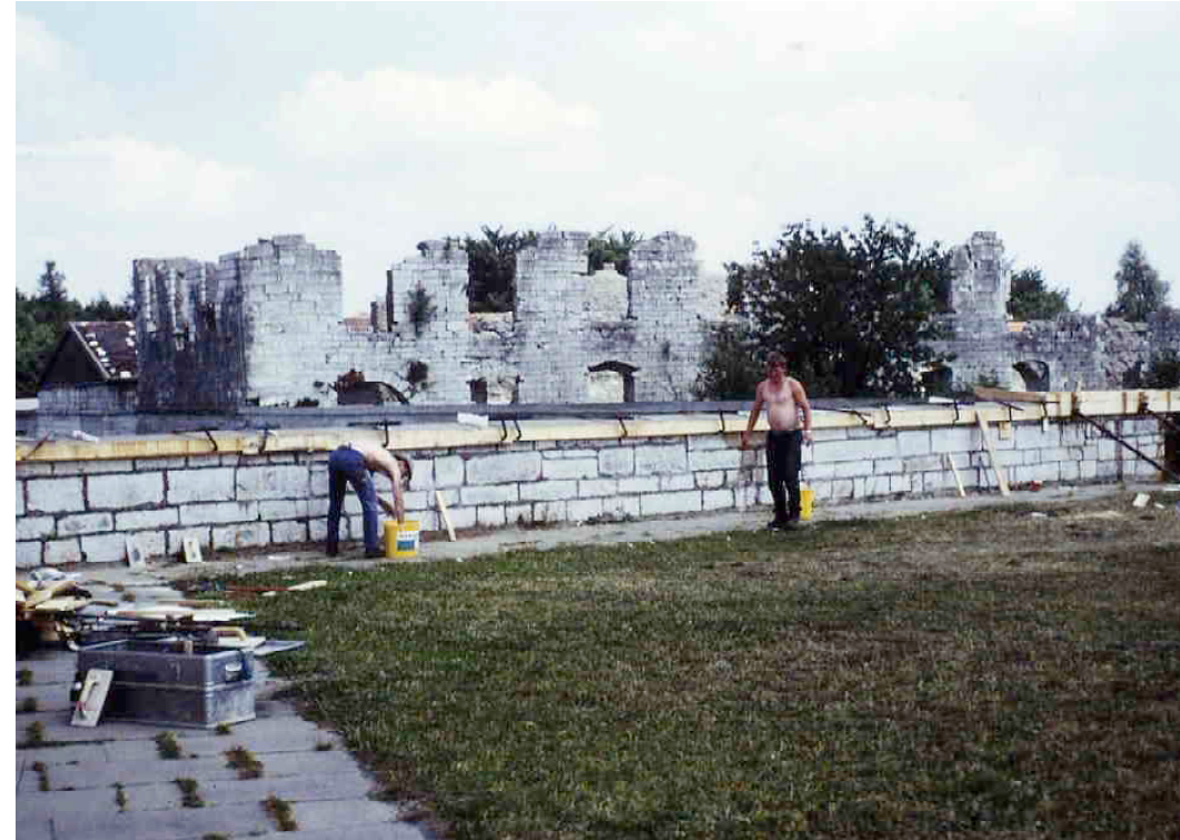
F 304 Bastion Schnaittach Erneuerung der Brüstung 1990 W. Kaschel Heimatverein Schnaittach
