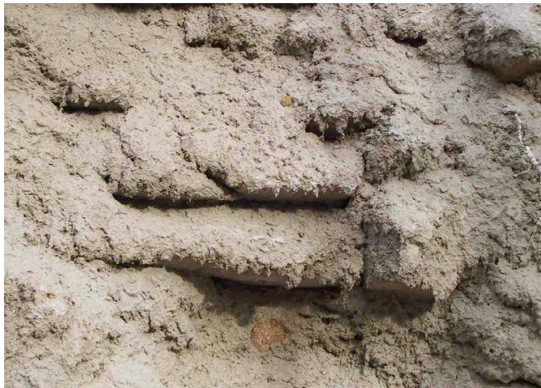
F 323 Bastion Glatzenstein Spritzmörtel, Detail
