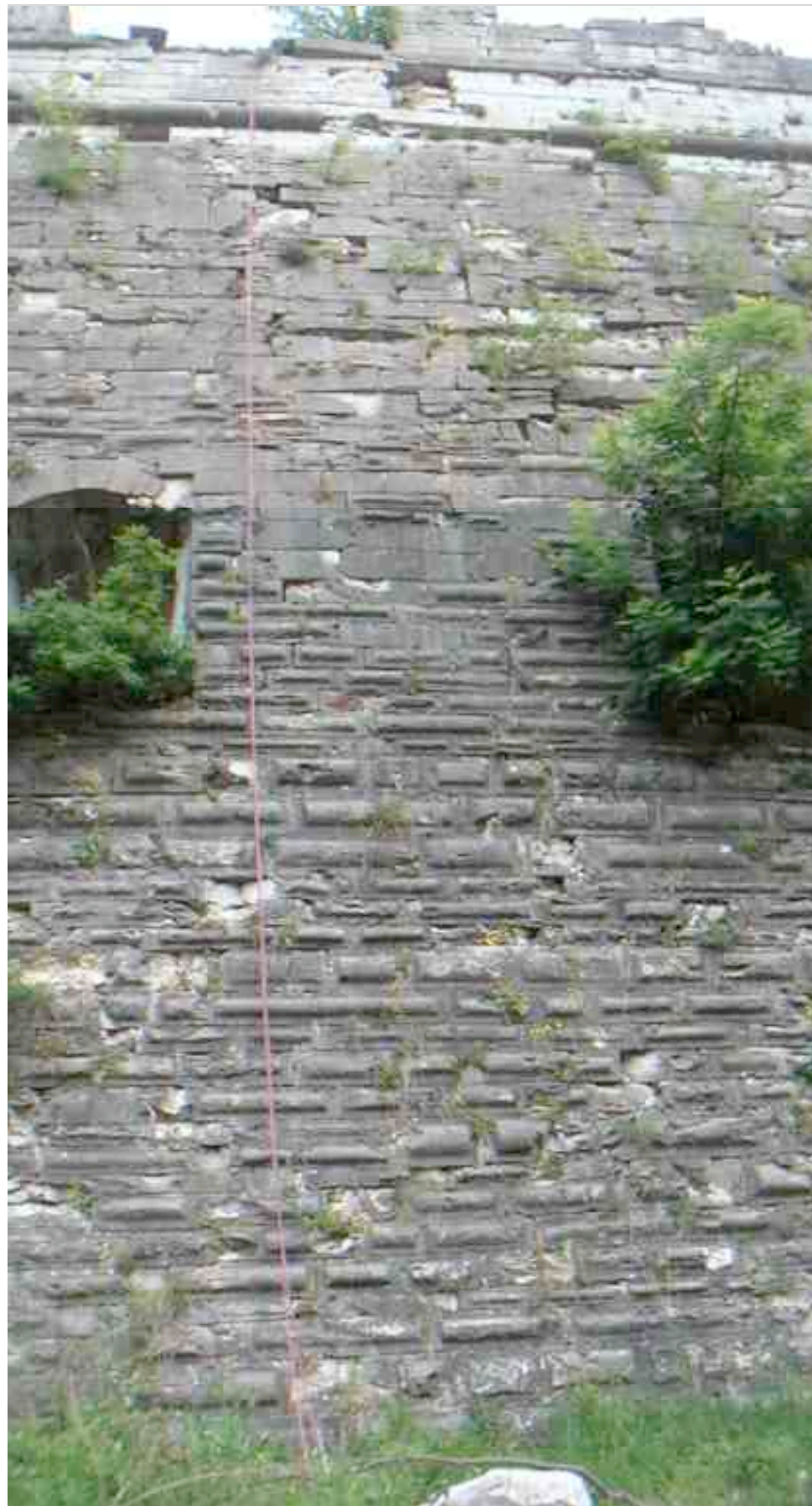
F 457 Mauerwerksstreifen Südostkurtine
