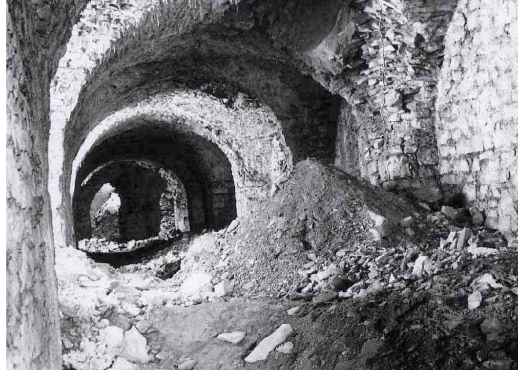
F 078 Kasematten Unter der Kommandantur 1966 Maul, Schnaittach Heimatverein Schnaittach
