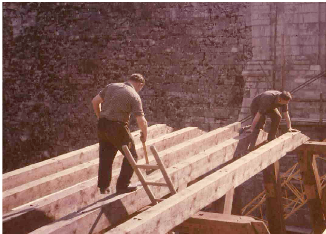
F 115 Brückenbau Durch die Bayrische Schlösserverwaltung 1968 Unbekannt Heimatverein Schnaittach
