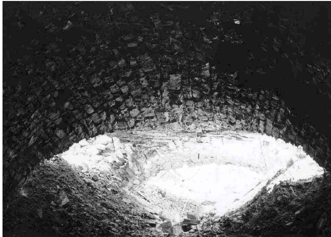
F 077 Kasematten Unter der Kommandantur 1966 Maul, Schnaittach Heimatverein Schnaittach
