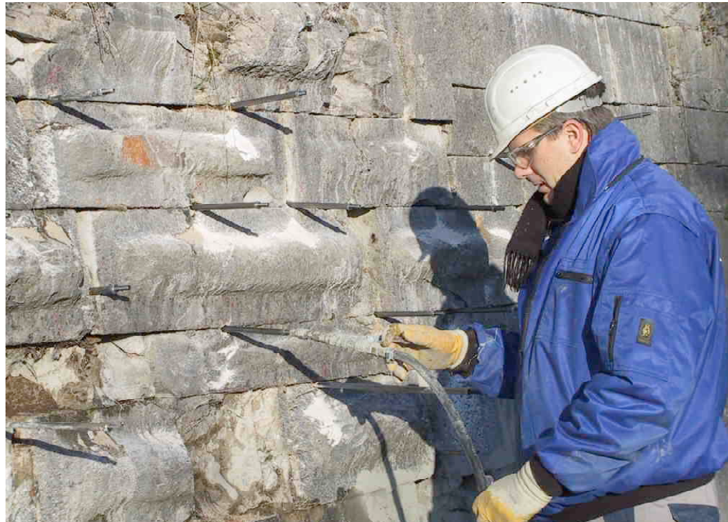
F 369 Verpressung 1 im November 2003 Injektionspistole 2003 S. Thole
