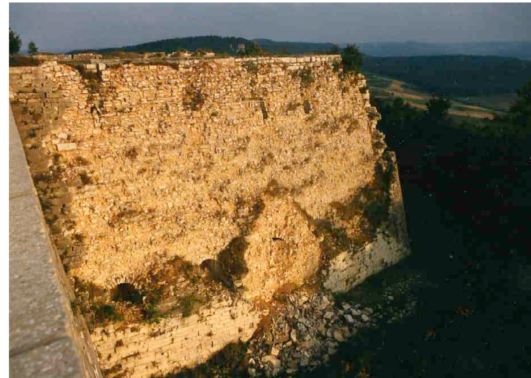
F 256 Bastion Nürnberg Abbruch des Mauermantels 1986 Unbekannt Heimatverein Schnaittach
