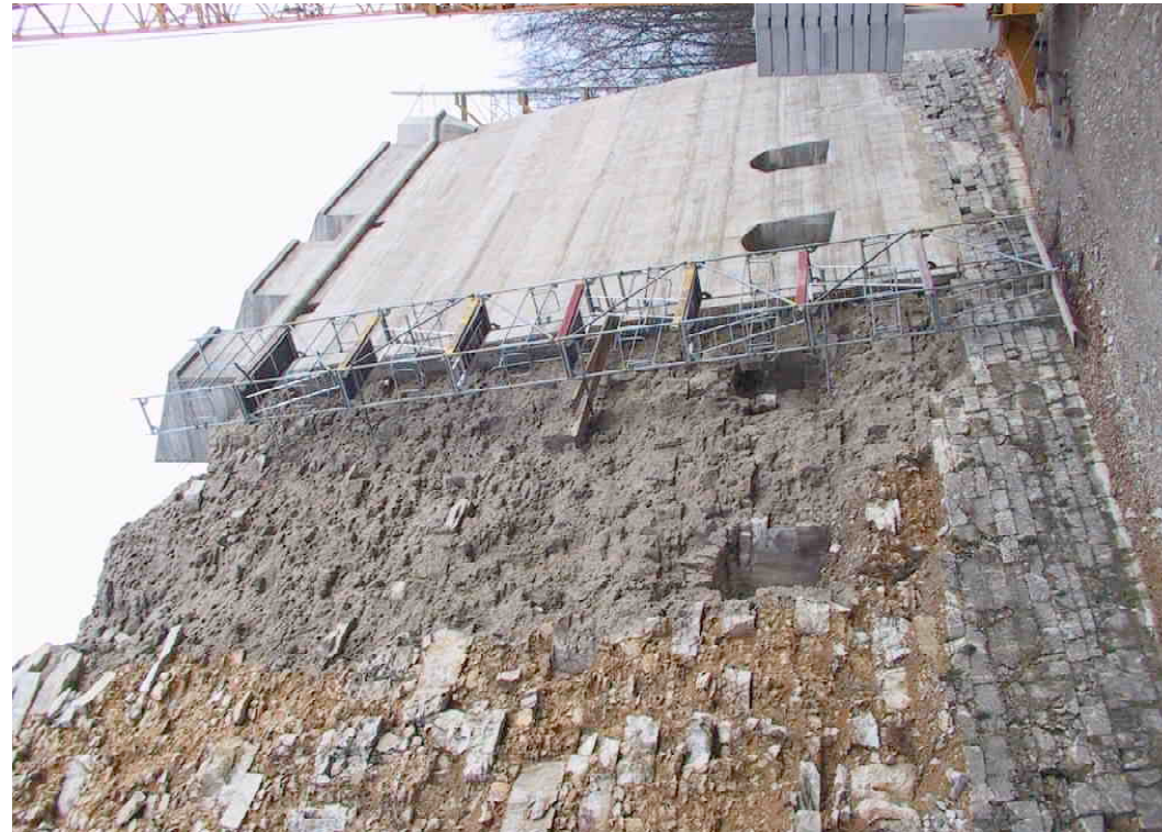
F 333 Vorbetonierte und betonverschaltete Mauer
