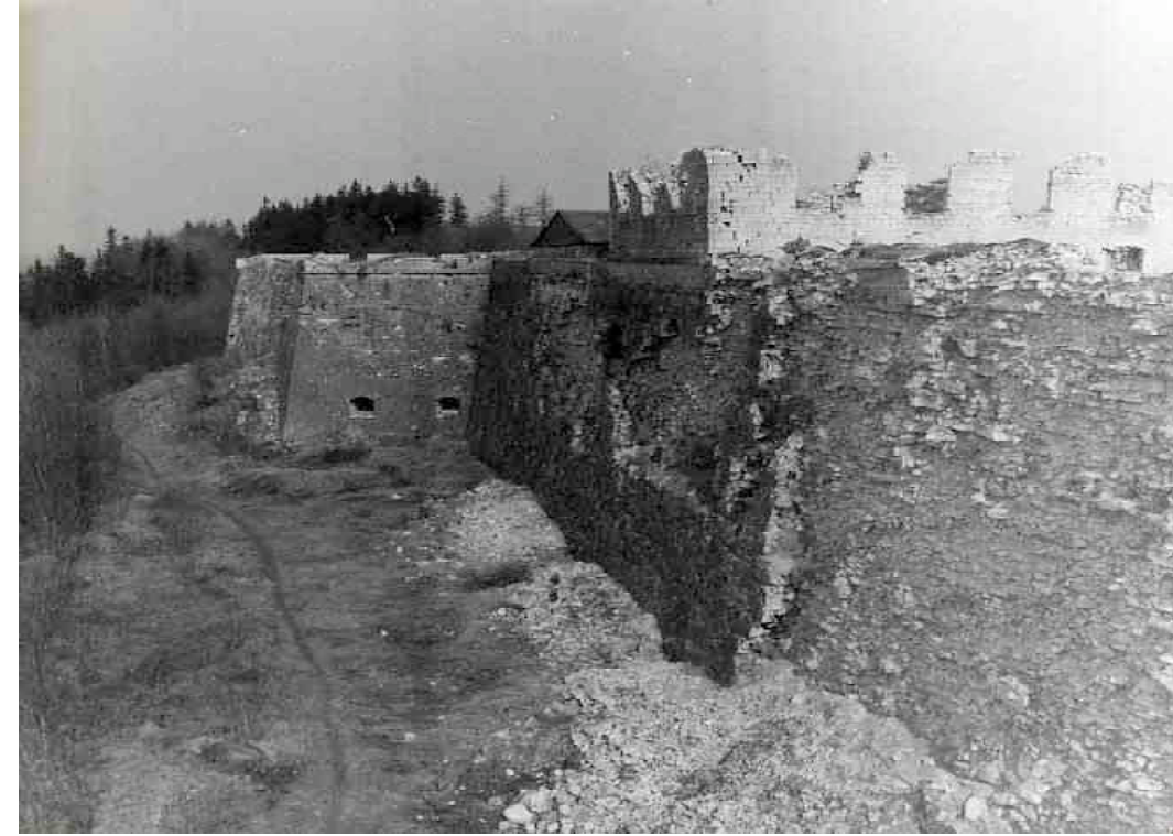
F 198 Kurtine zwischen den Bastionen Schnaittach und Amalie Abbruch des Mauermantels
