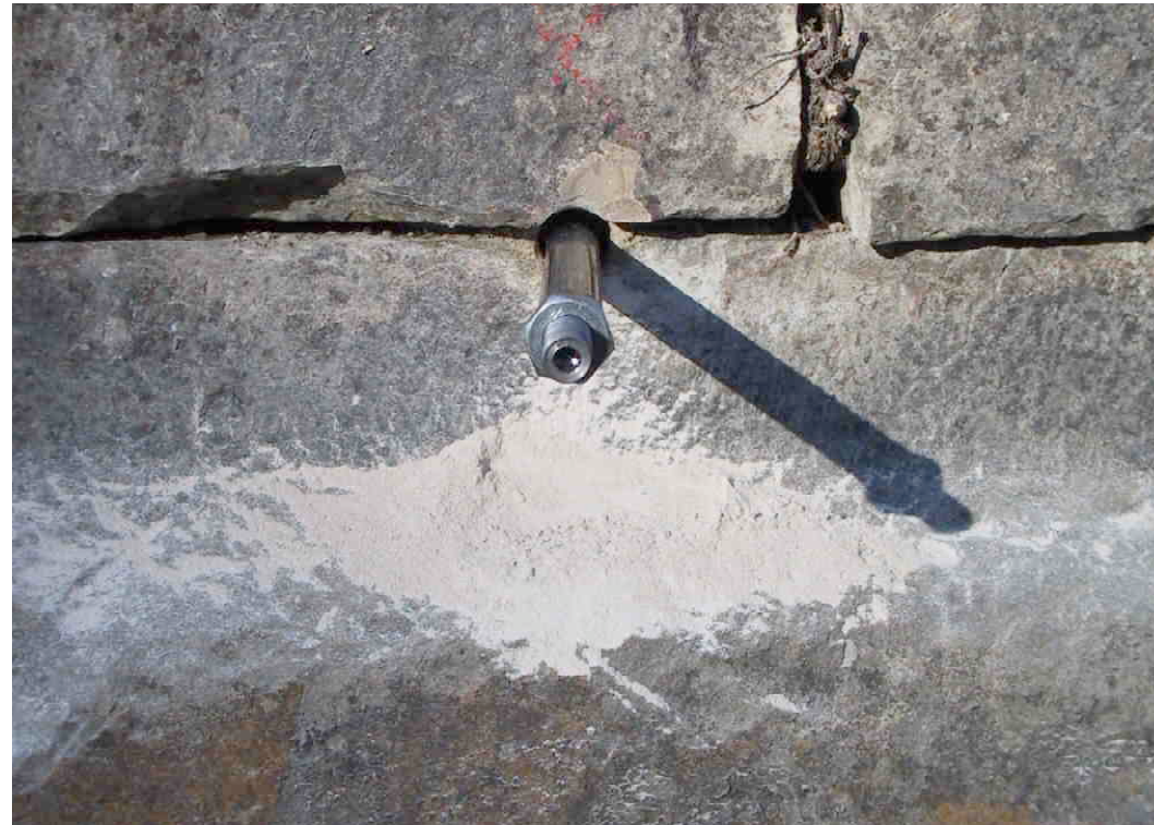
F 361 Verpressung 1 im November 2003 Eingesetzter Packer 2003 S. Thole
