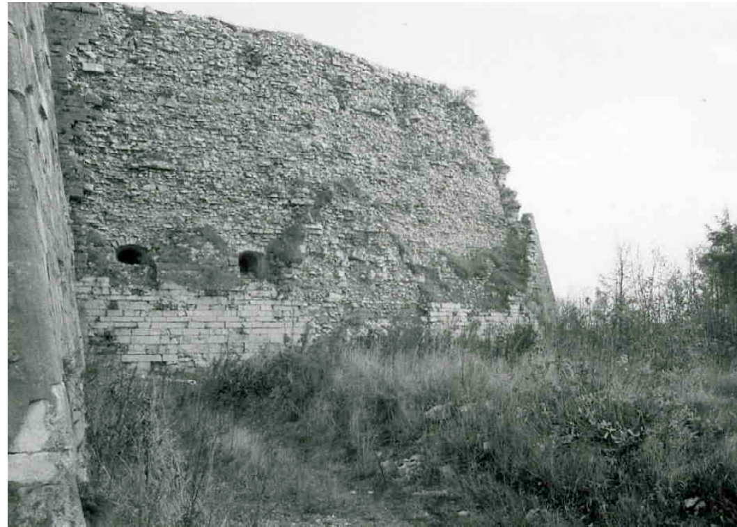
F 249 Bastion Nürnberg Abbruch des Mauermantels
