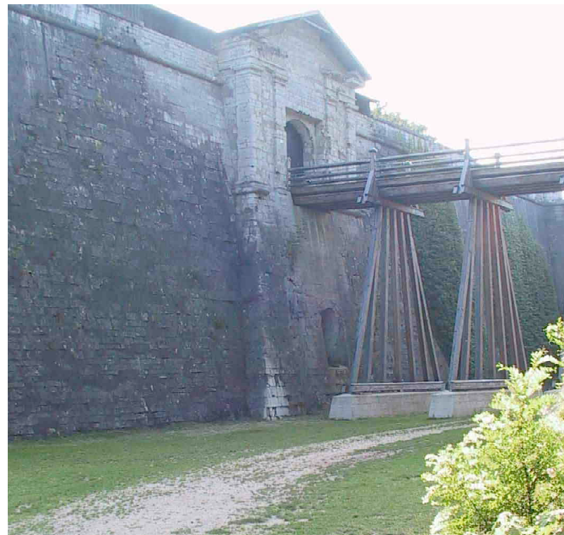
R 12 Portal F 447 2004 S. Thole
