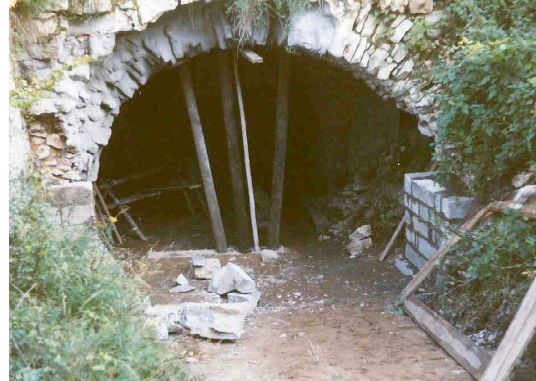
F 288 Zugang zu den Kasematten Beginn der Instandsetzungsarbeiten
