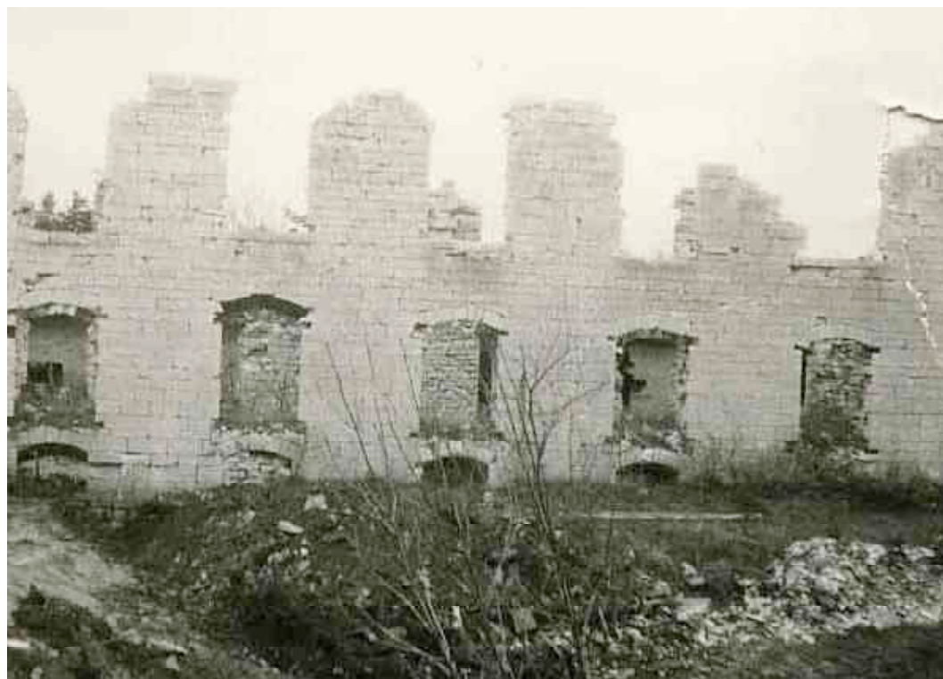
F 047 Zeughaus Ansicht von Süden
