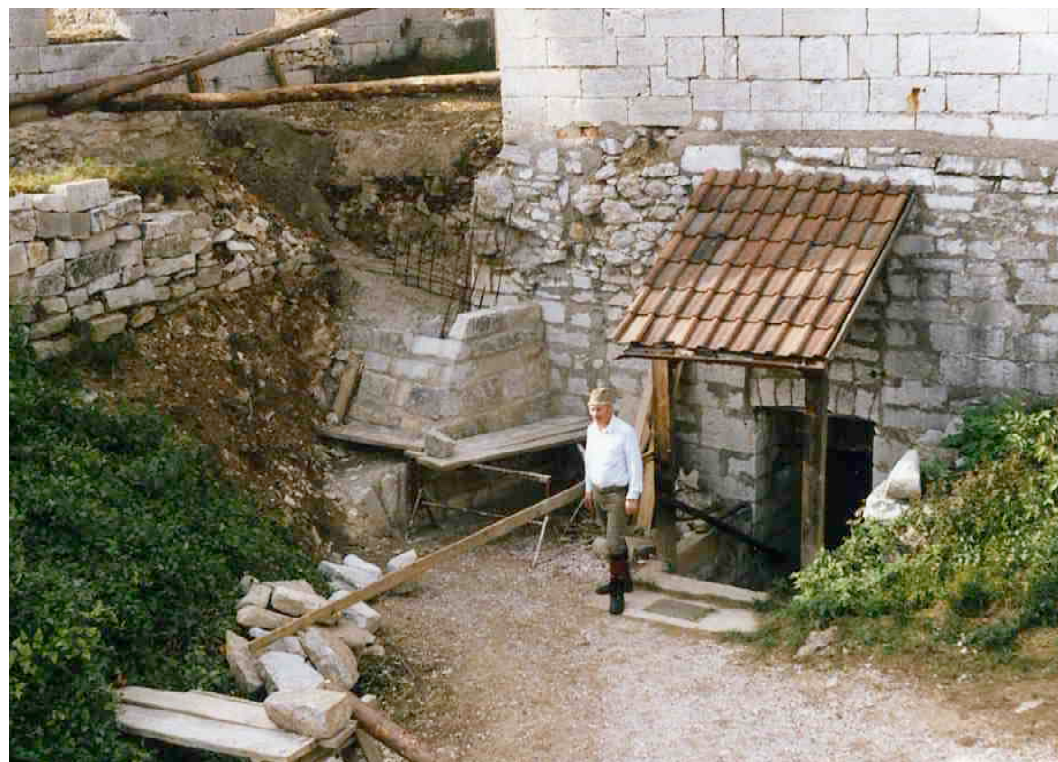
F 285 Kommandantur Bau der Stützmauer an der Ecke 1987 W. Kaschel Heimatverein Schnaittach
