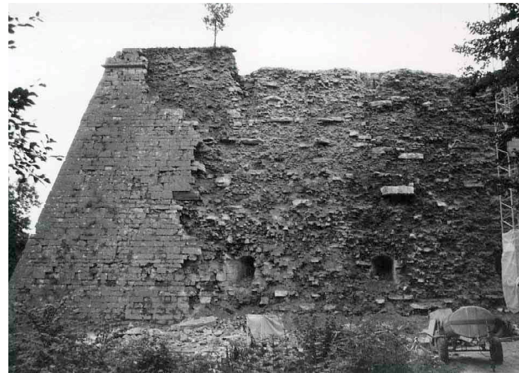
F 275 d Bastion Karl Nordface vor der Sanierung 1985 Unbekannt Heimatverein Schnaittach
