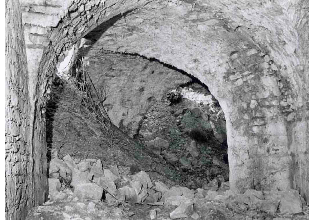
F 082 Kasematten Unter der Kommandantur 1966 Maul, Schnaittach Heimatverein Schnaittach
