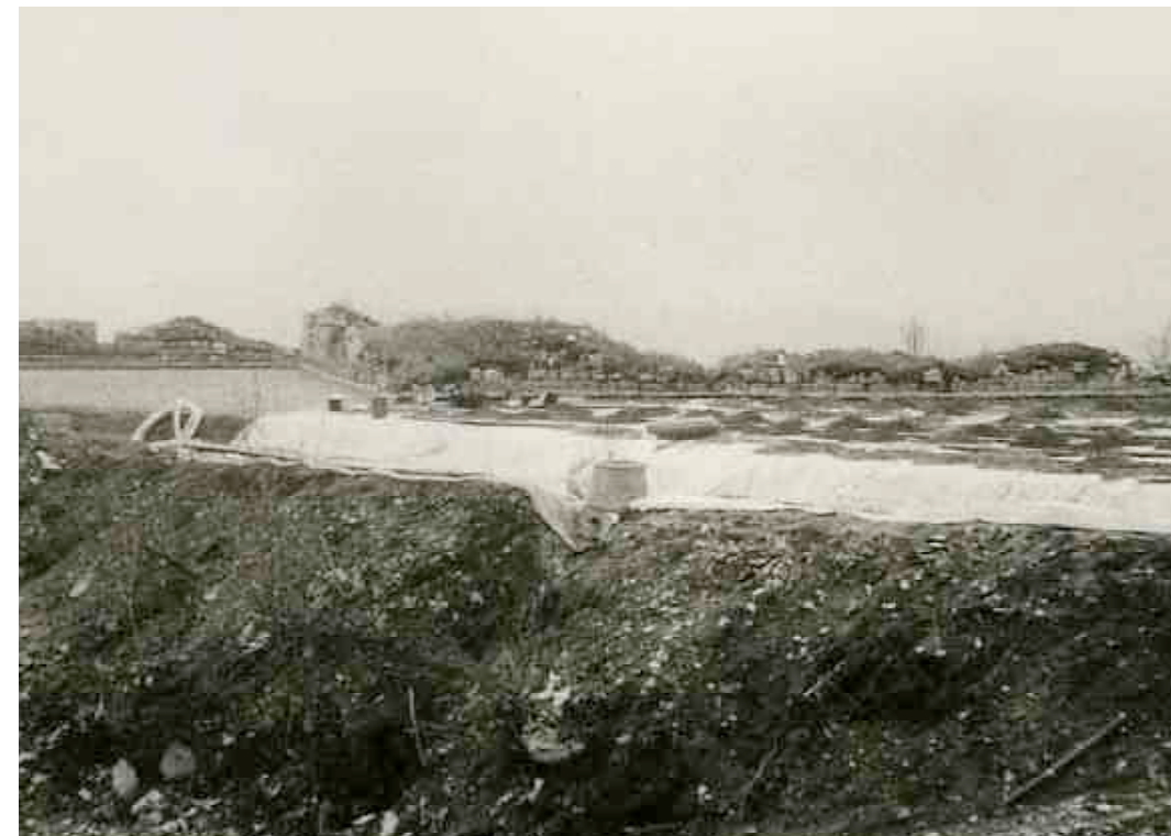
F 128 Bastionen Nürnberg und Kersbach Isolierung mit Folie 1970 Unbekannt Heimatverein Schnaittach
