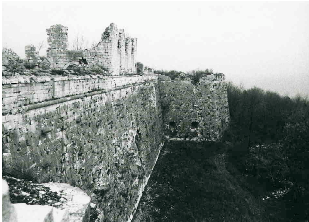
F 245 Bastion Glatzenstein und Kurtine zwischen Bastion Kersbach Zustand der Mauer 1984 1984 Unbekannt Heimatverein Schnaittach
