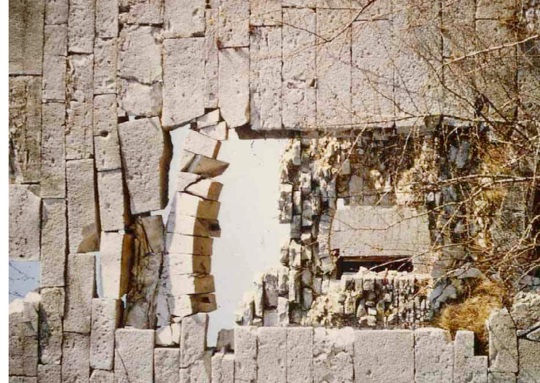
F 162 Zeughaus Fensterbogen, eingebrochen 1978 1976 W. Kaschel Heimatverein Schnaittach
