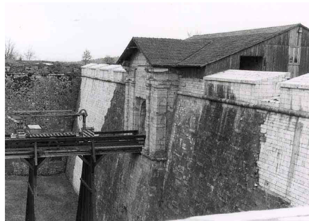
F 212 Portal Sanierte Mauer 1983 Unbekannt Heimatverein Schnaittach
