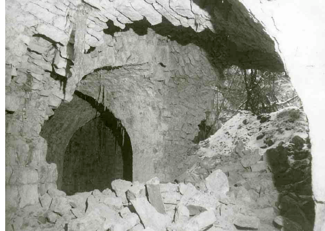
F 174 Kasematten Einbruch der Gewölbe 1981 W. Kaschel Heimatverein Schnaittach
