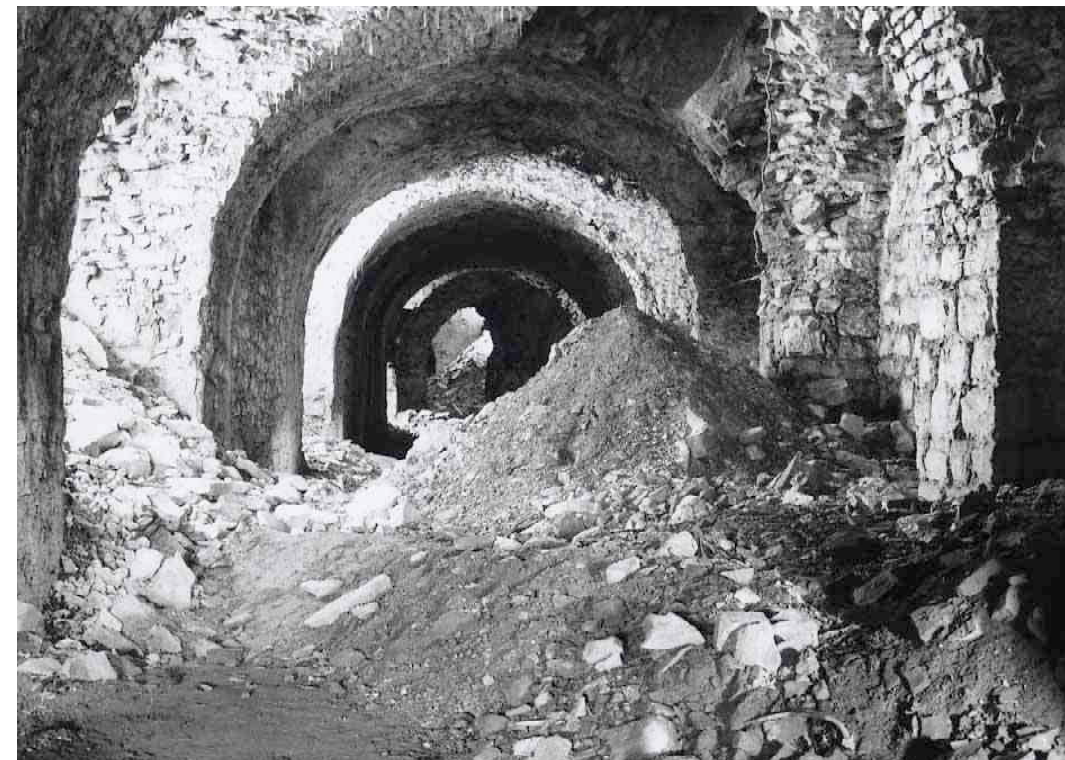
F 076 Kasematten Unter der Kommandantur 1966 Maul, Schnaittach Heimatverein Schnaittach
