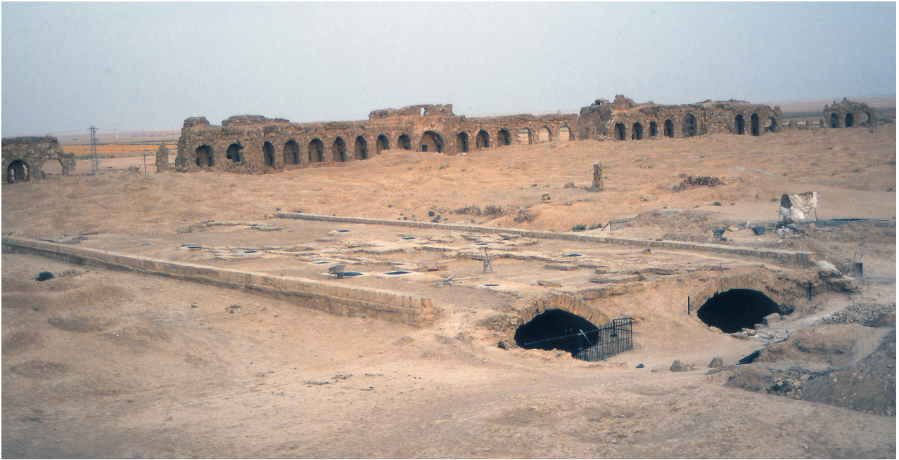
13a RESAFA. PLATZANLAGE ÜBER DEN ZISTERNEN (ANSICHT VON SÜDOSTEN)
