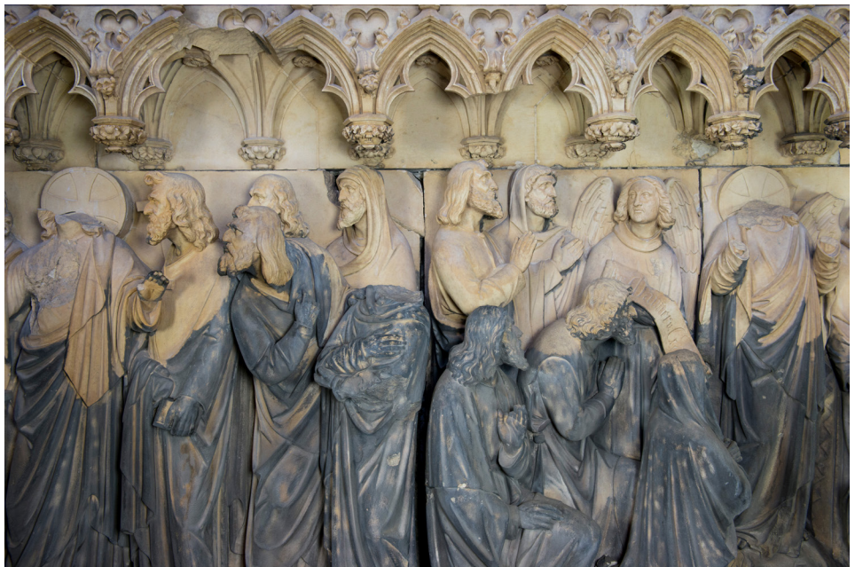
Abb. 5 Köln, Dom, Michaelsportal, Ansicht des Tympanons während der Laserreinigung. Deutlich heben sich die gereinigten Partien von den fast schwarzen ungereinigten Oberflächen ab
