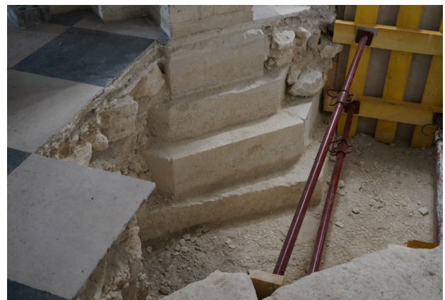
Abb. 3 Paris, Notre-Dame, westliches Langhaus, freigelegte Fundamente eines Mittelschiffspfeilers
