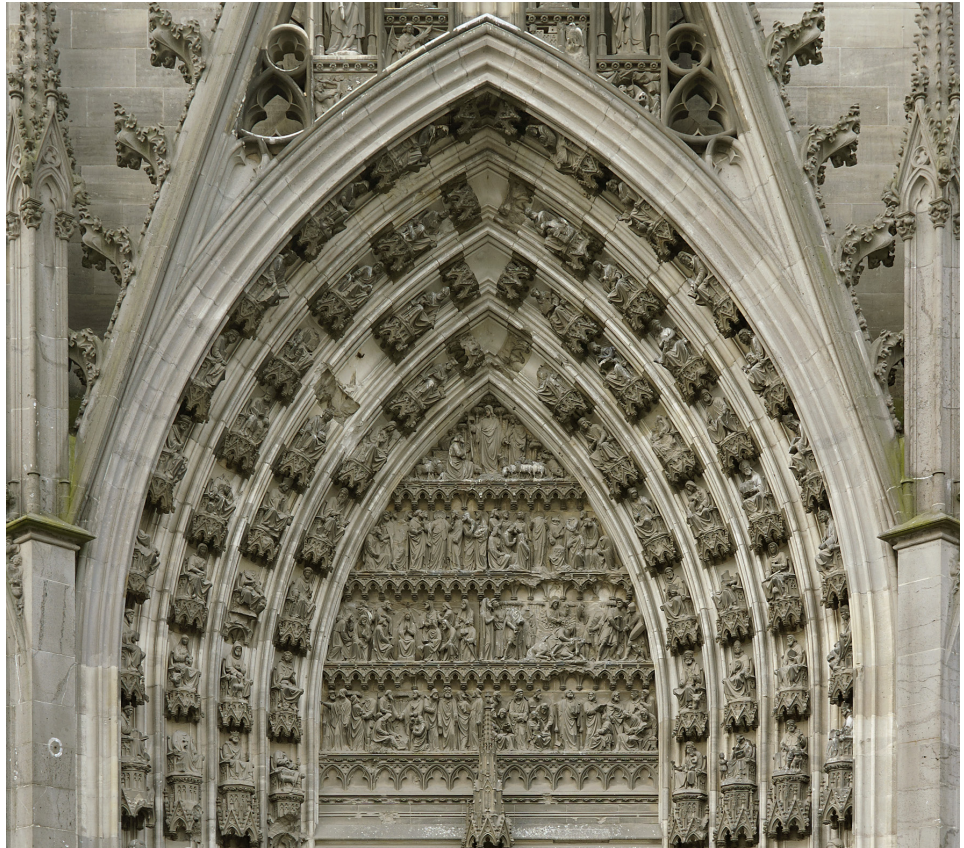
Abb. 4 Köln, Dom, Michaelsportal, Ansicht der Archivolten und des Tympanons vor der Restaurierung, messgenaue Fotografie (Detail), Februar 2013
