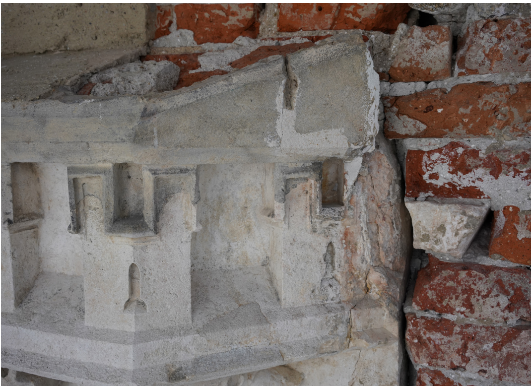
Abb. 11 Passau, St. Stephan, Portal zum ehemaligen Kreuzgang, seitliche Anschlussstellen des Zinnenfrieses an das Bruchsteinmauerwerk
