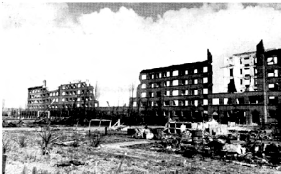
EINZELHAUS — Zerstörungsgrad ca. 90 0/0. Merkmale: Zerstörung aller Bauteile einschl. Kellerdecke und Außenwände.
