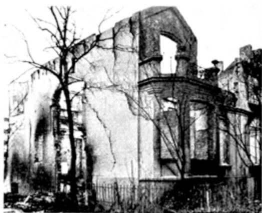
EINZELHAUS — Zerstörungsgrad ca. 90 0/0. Merkmale: Zerstörung aller Bauteile einschl. Kellerdecke und Außenwände.
