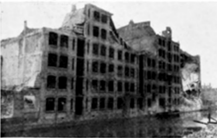
SPEICHER-GESCHOSSBAU — Zerstörungsgrad ca. 60 %. Merkmale: Fundamente und Hauptkonstruktionen einschl. Decken weitgehend erhalten.
