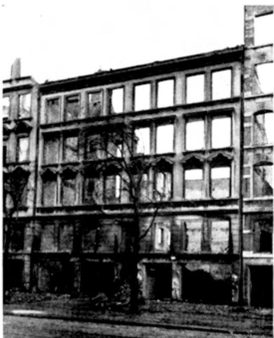
KLEINES VERWALTUNGSGEBAUDE — Zerstörungsgrad ca. 90 0/0. Zerstörung aller Decken und Außenwände.
