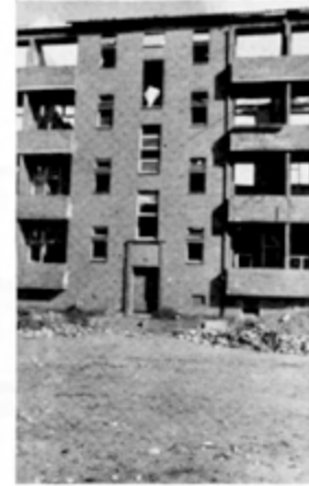
Das Haus ist langsam — nicht im Flächenbrand und Feuersturm ausgebrannt, Holzwerk erhalten.
