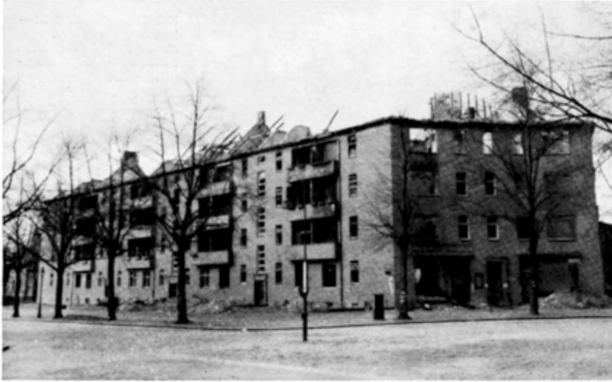
MIETWOHNHAUSER-GESCHOSSBAU — Zerstörungsgrad ca. 55 %. Merkmale: Keller voll erhalten, Decken über Küdien und Bädern erhalten, Treppenhäuser teilweise erhalten.
