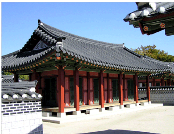
Abb. 35-30 Amtsgebäude der Generäle, Bijangcheong , nach der Rekonstruktion 2008
