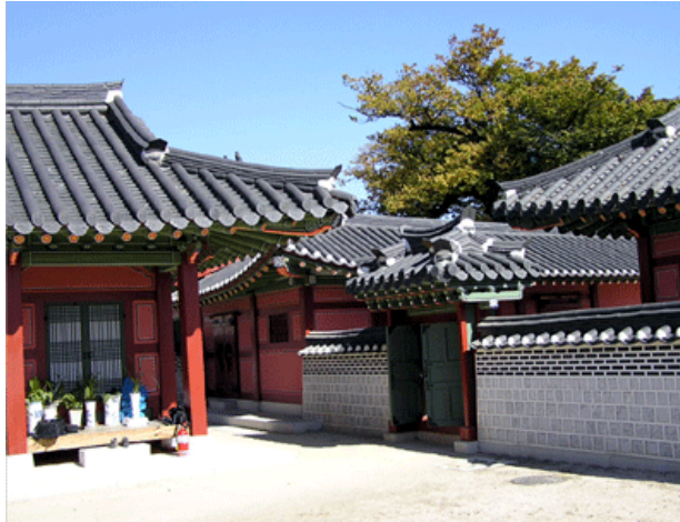
Abb. 35-29 Tor zwischen dem Pavillon Seoricheong und der Kaserne im Süden, Namgunyeong , nach der Rekonstruktion 2008
