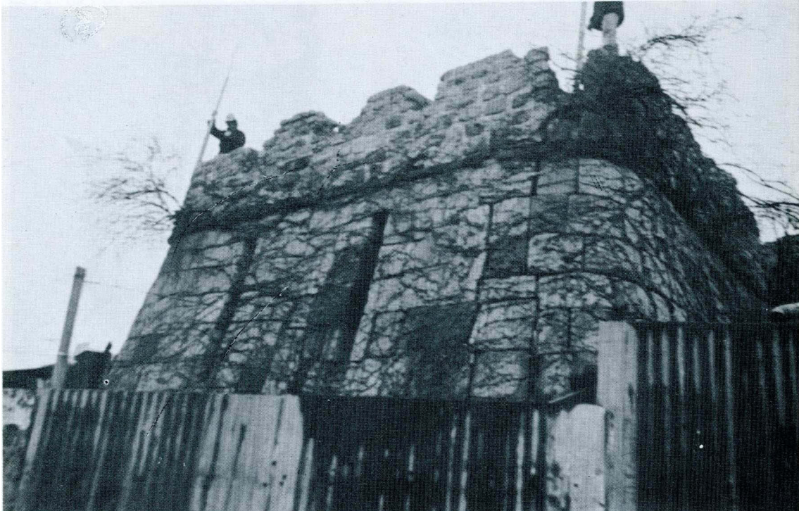
Abb. 31-8 Feldseite der 3. einfachen Bastion im Osten, Dongsamchi , 1975
