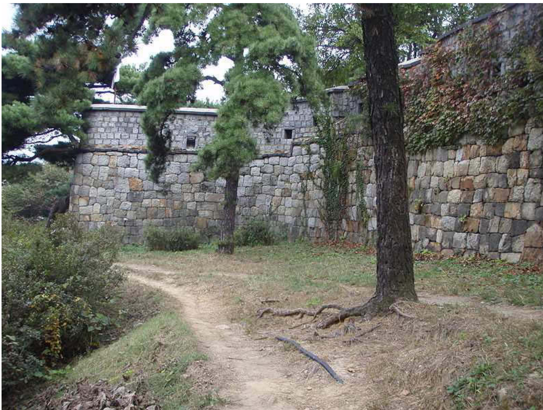
Abb. 31-13 Südflanke der 2. einfachen Bastion im Westen, Seoichi , nach der Rekonstruktion 2008
