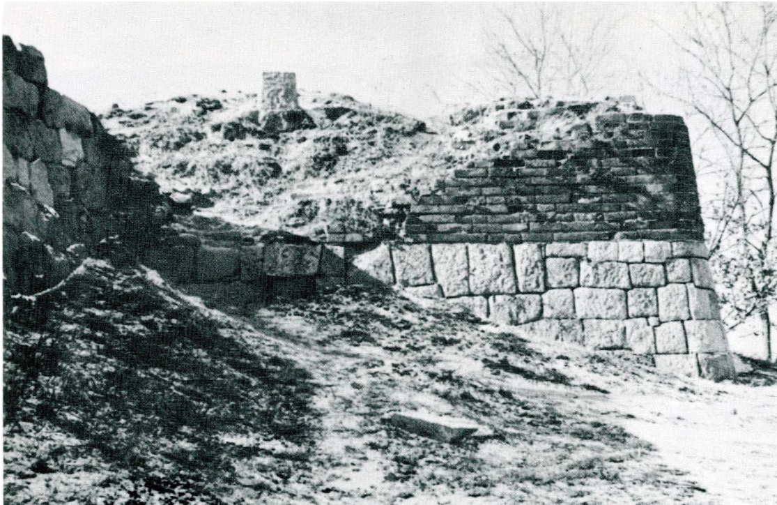
Abb. 28-3 Fundamente des Wachturms im Nordosten, Dongbukporu (東北舖樓) ( Gakgeondae ), 1975
