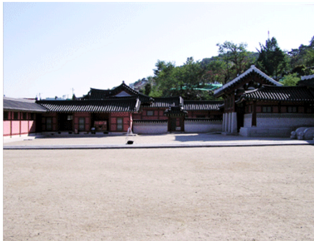
Abb. 35-7 Nordansicht des Pavillons Yuyeotaek , nach der Rekonstruktion 2008
