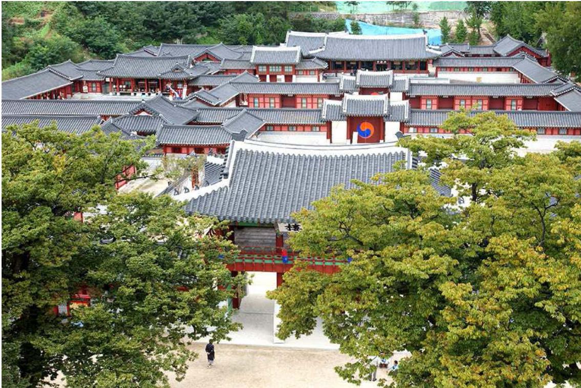
Abb. 54-13 Palast Haenggung nach der Rekonstruktion 2009
