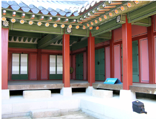
Abb. 35-13 Pavillon Bongnaedang , nach der Rekonstruktion 2008
