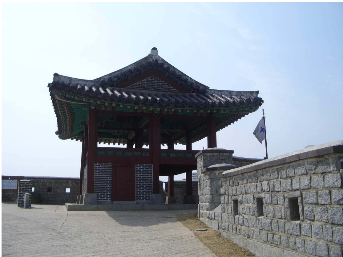
Abb. 24-4 Innenseite des Eckpavillons im Nordwesten, Seobukgangnu , nach der Rekonstruktion, 2008
