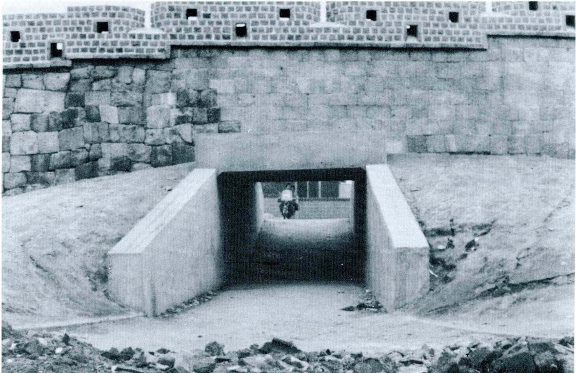
Abb. 31-20 Bau einer Unterführung durch den Wall, 1979
