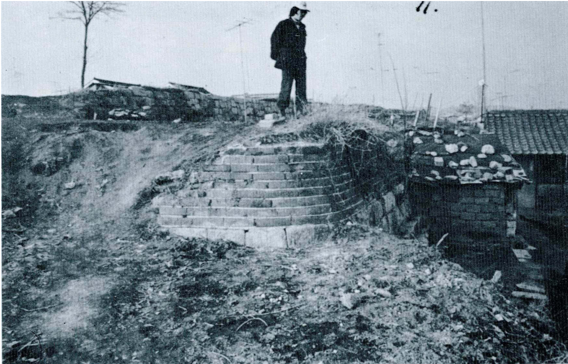
Abb. 27-17 Zustand des Kanonenturms Dongporu (東砲樓), 1975
