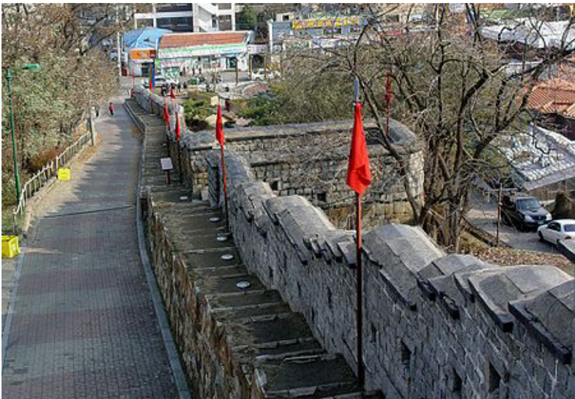
Abb. 31-17 Wehgang und Westflanke der einfachen Bastion im Süden, Namchi , 2008
