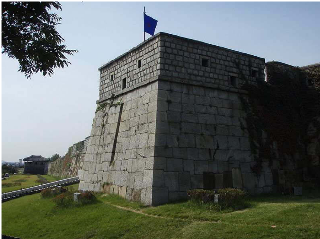
Abb. 31-5 Feldseite der 1. einfachen Bastion im Osten, Dongilchi , nach der Rekonstruktion 2008
