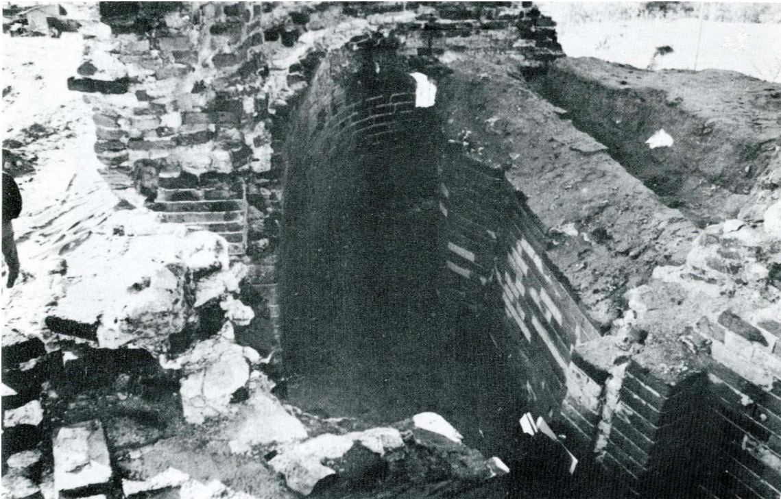
Abb. 21-5 Zustand des Eingangsbereiches nach der archäologischen Grabung im Turm mit Aufenthaltsräumen im Nordosten, Dongbukgongsimdon , 1976
