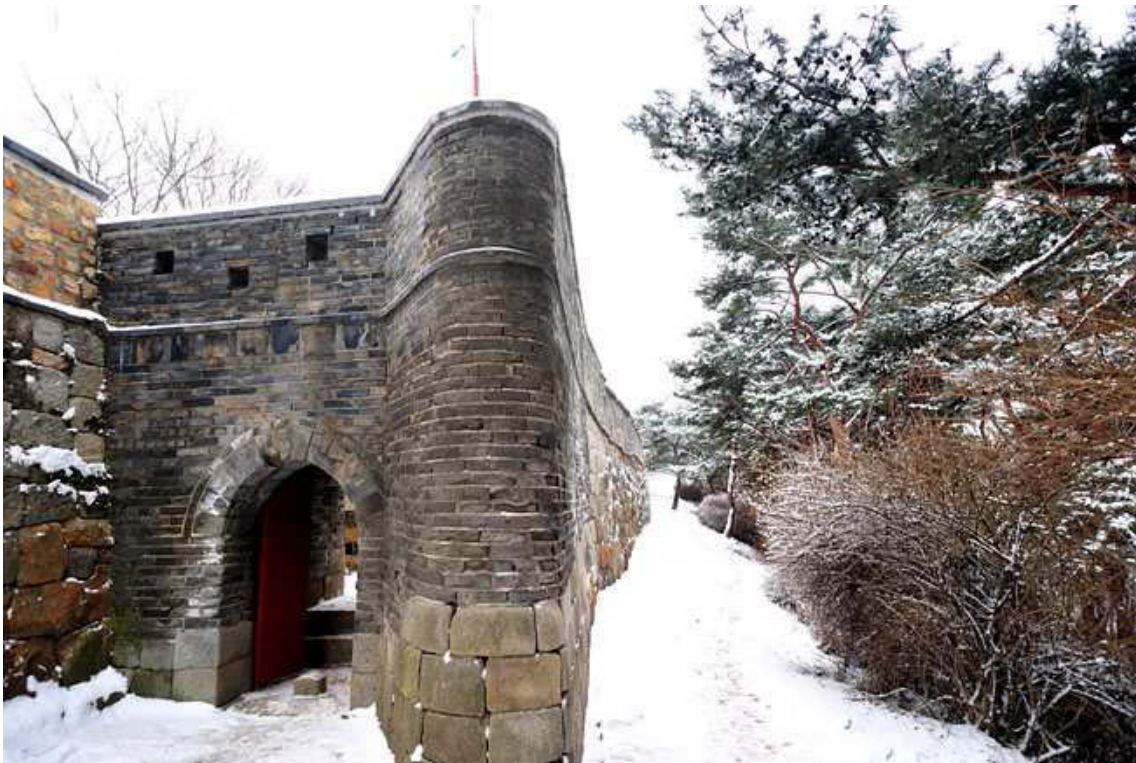
Abb. 10-3 Außenansicht der versteckten Pforte im Westen, Seoammun , mit deckenden Orillon Bastionsohr nach der Rekonstruktion 2008
