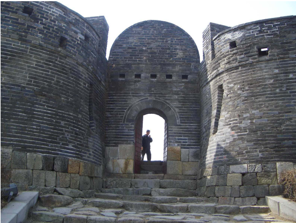
Abb. 9-4 Außenansicht der versteckten Pforte im Norden, Bukammun , nach der Rekonstruktion 2008
