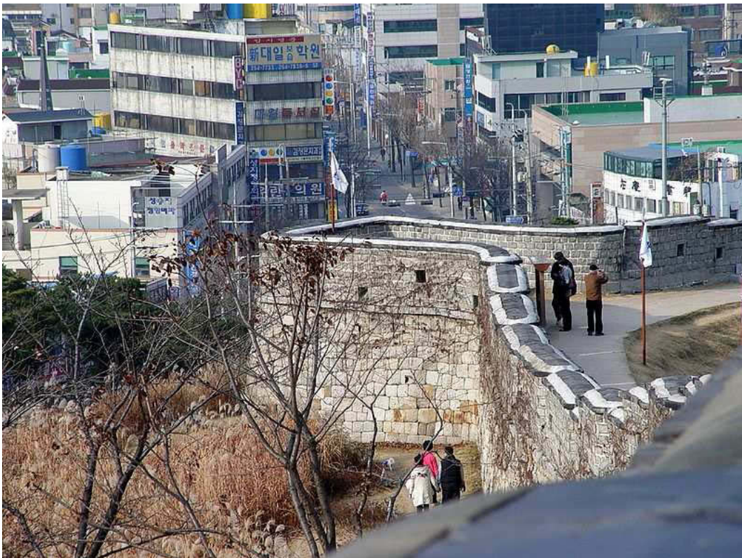
Abb. 31-11 Südflanke der 1. einfachen Bastion im Westen, Seoilchi , nach der Rekonstruktion der Brustwehr 2008
