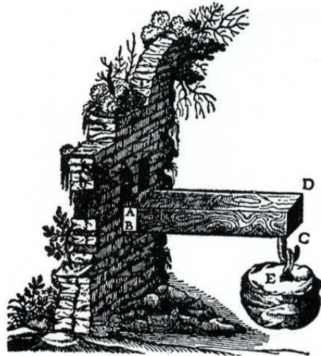
Kragbalken unter Zugbelastung. Galileo Galilei, Zwei neue Wissenszweige , 1638.
