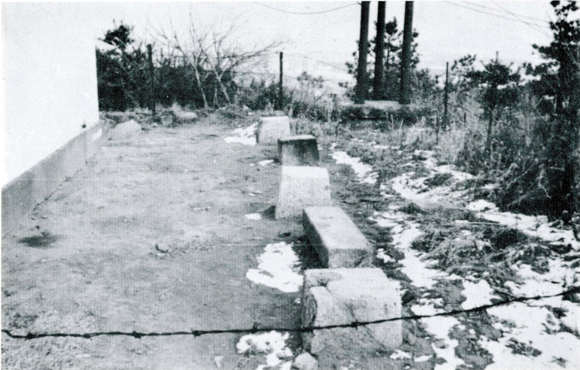
Abb. 25-2 Zustand auf der Südostseite des Seonamgangnus ( Hwayangnu ), 1975
