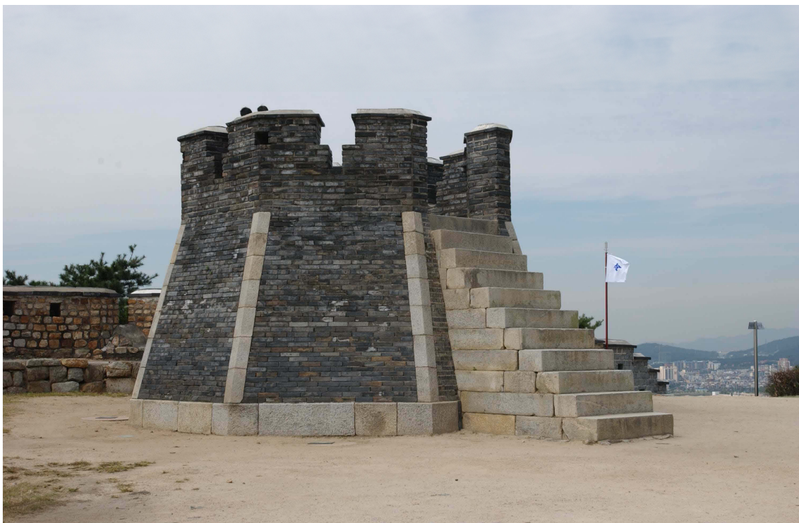
Abb. 16-2 Ansicht des Turms für die Bogenschützen im Westen, Seonoda , nach der Rekonstruktion 2008
