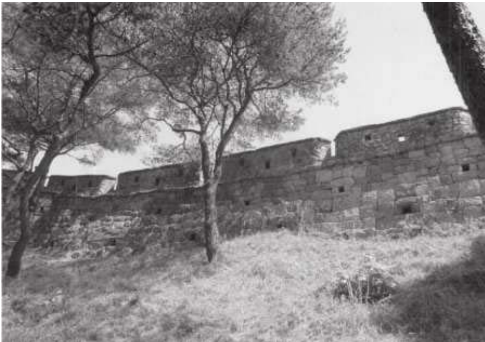
Abb. 16-10 Wallabschnitt am Pavillon der Generäle im Westen mit zwei Reihen Schießscharten. Die Scharten in der unteren Ebene sind höhenversetzt. 2005
