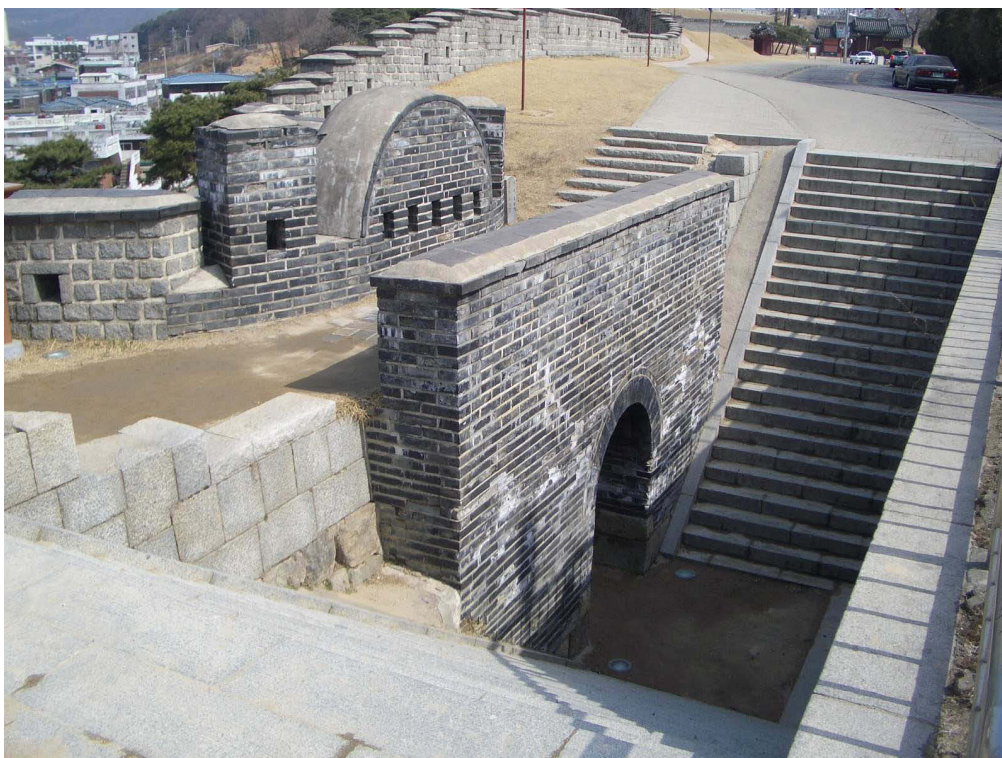
Abb. 8-5 Innenansicht der versteckten Pforte im Osten, Donggammun , nach der Rekonstruktion 2008
