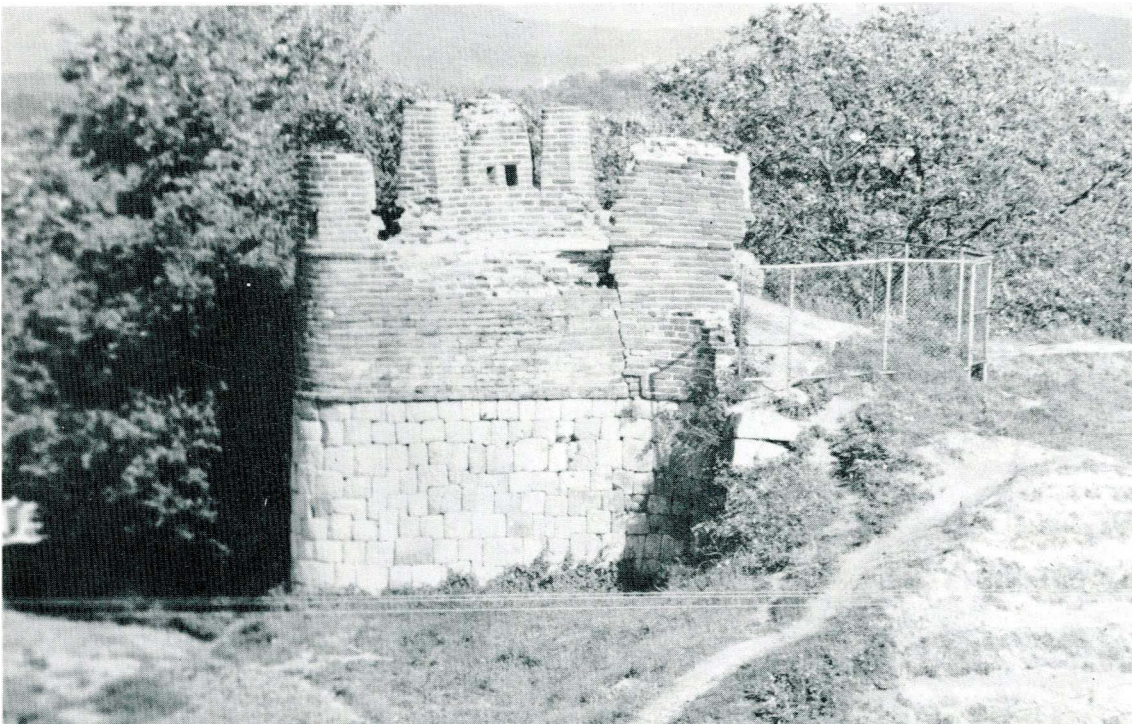
Abb. 18-4 Linke Flanke des Turms für die Bogenschützen im Nordosten, Dongbuknodae , 1975
