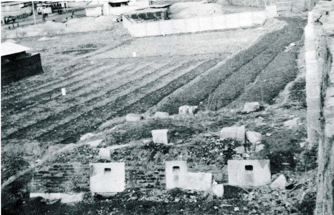
Abb. 27-34 Ruine des Kanonenturms im Nordwesten, Bukseoporu (北西砲樓), 1975
