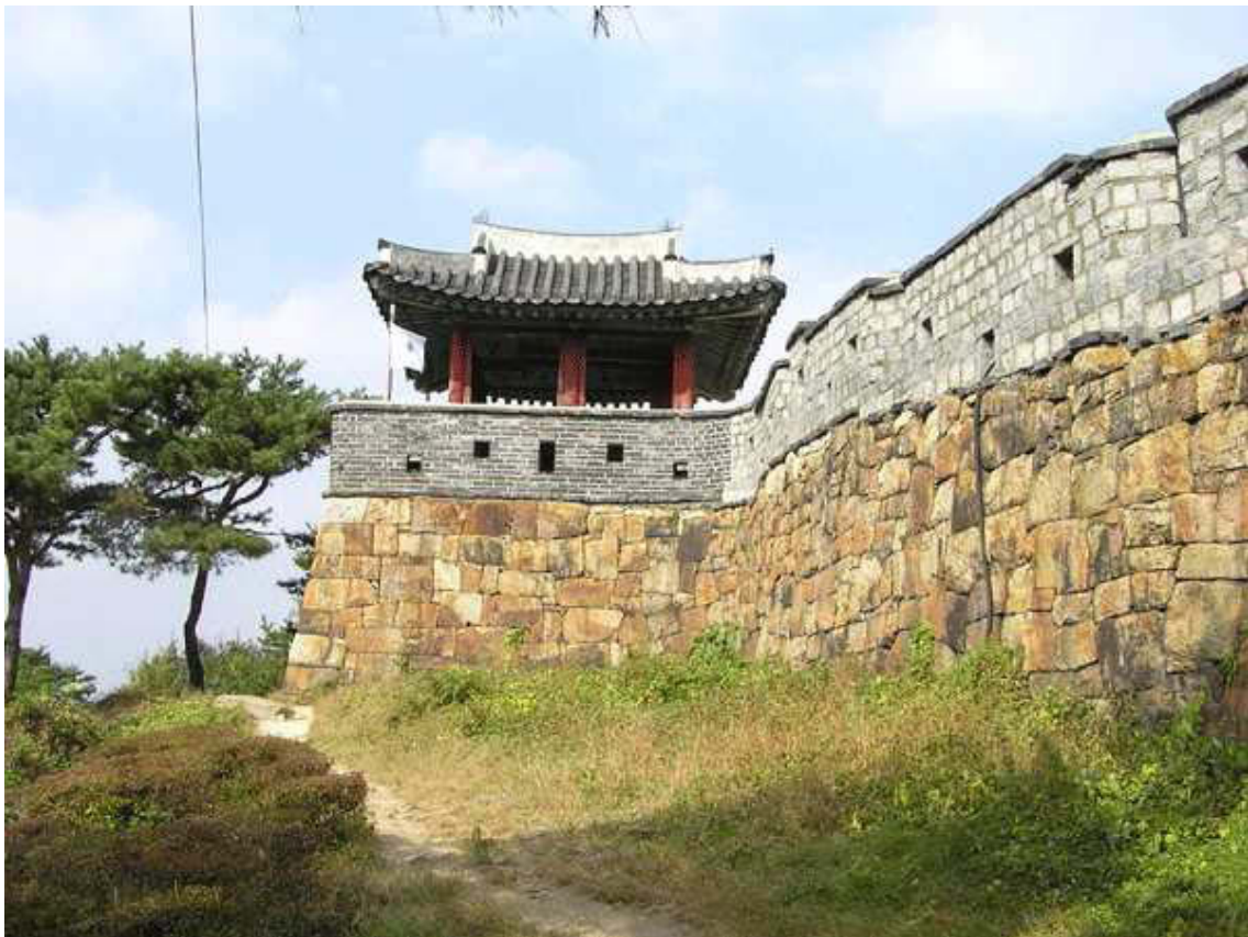
Abb. 30-18 Westflanke des Wachturms im Westen, Seopori , nach der Rekonstruktion 2008
