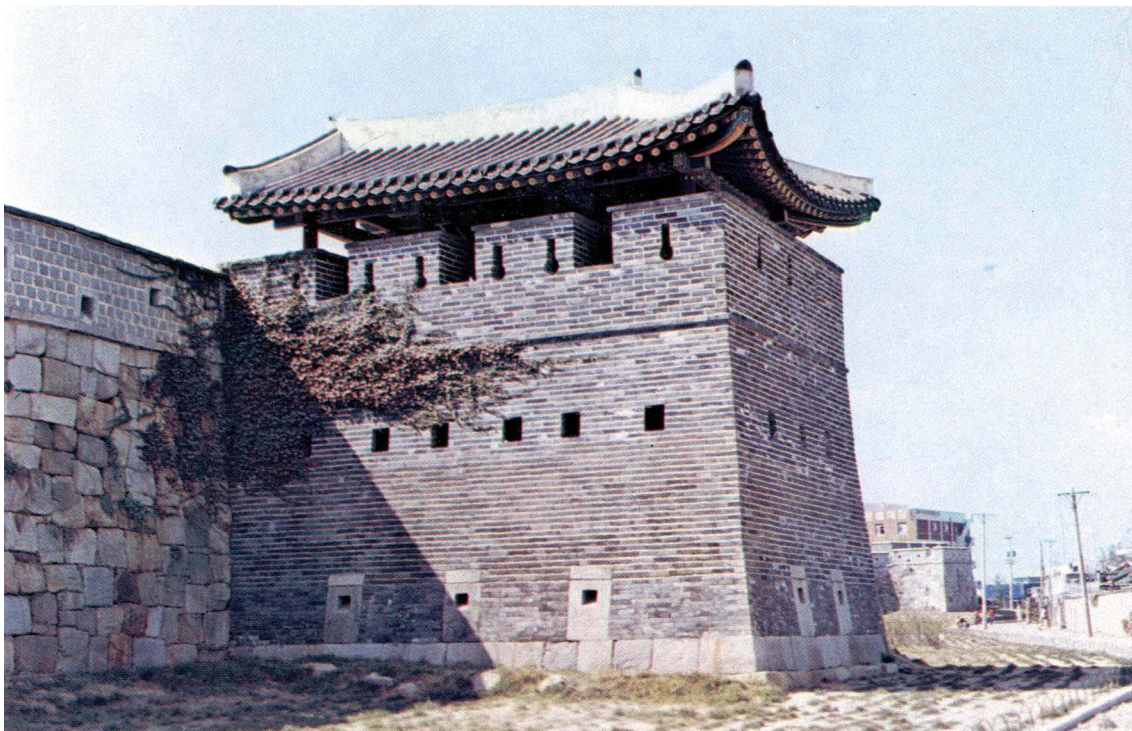
Abb. 27-13 Außenansicht des Kanonenturms Bukdongporu (北東砲樓), nach der Rekonstruktion 1979
