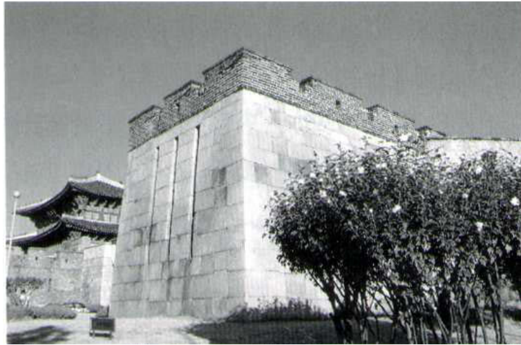
Abb. 3-9 Flankierungsturm im Nordwesten, 1999
