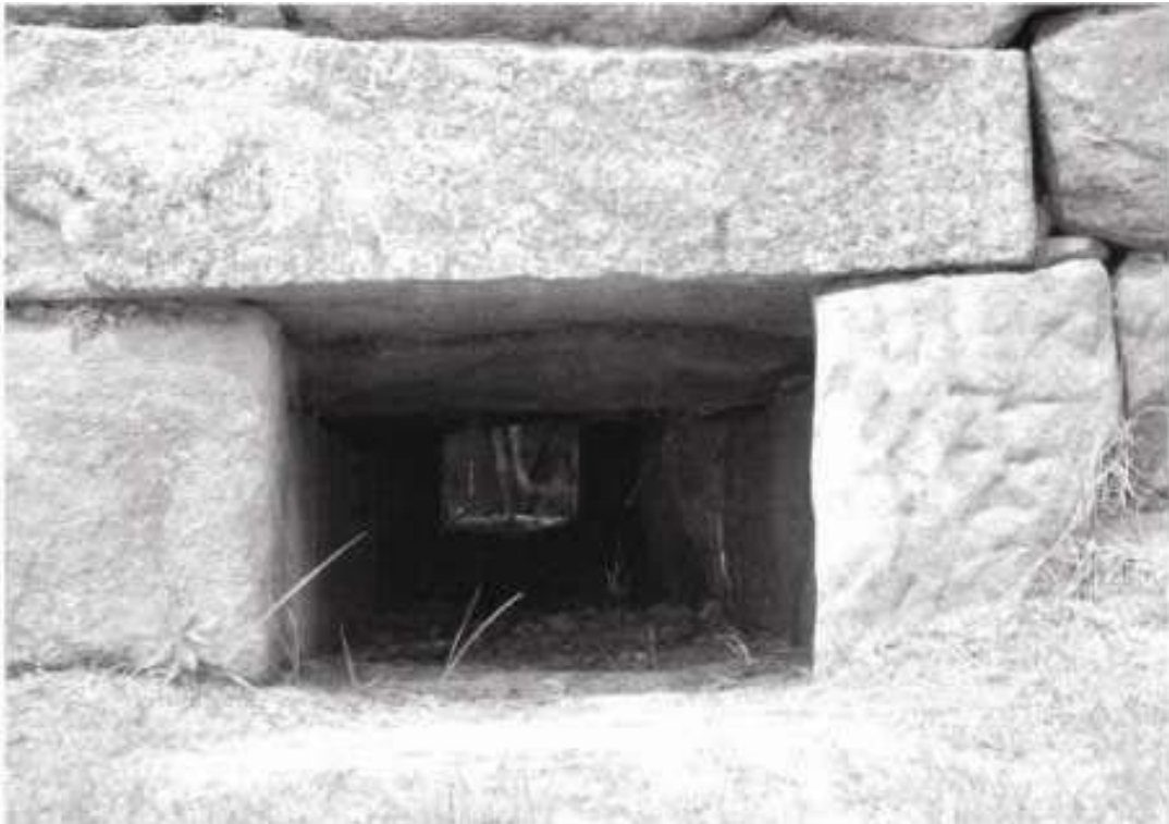
Abb. 16-7 Innenansicht einer Schießscharten in der Mauer um den Pavillon der Generäle im Westen, Hwaseong Jangdae , 2005
