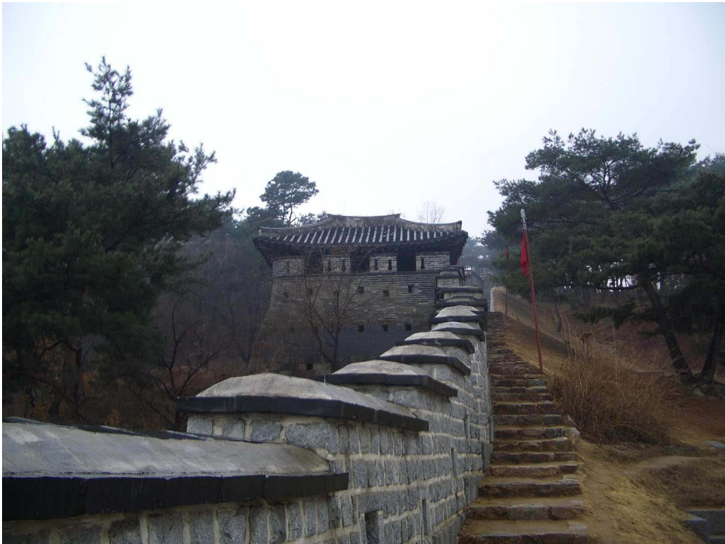
Abb. 27-5 Ostflanke des Kanonenturms im Süden, Namporu (南砲樓), nach der Rekonstruktion 2008
