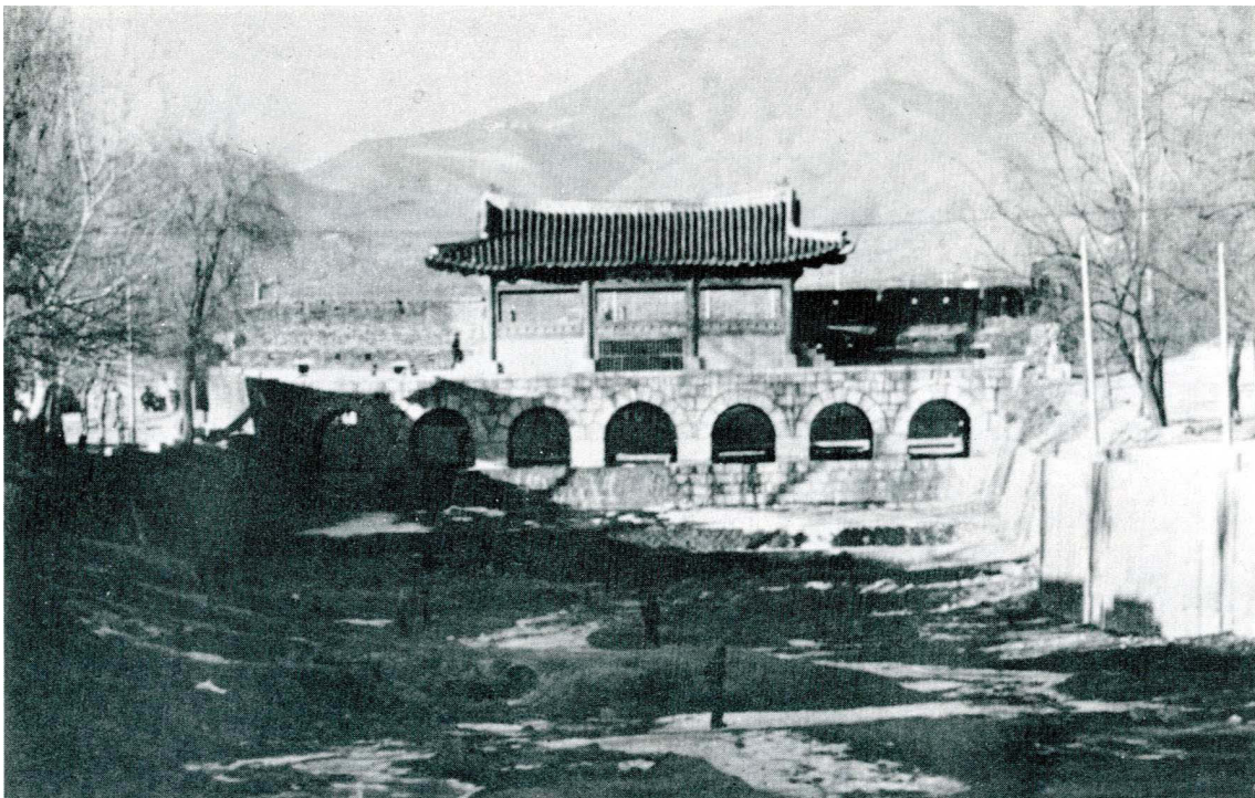
Abb. 12-4 Flussschleuse Buksumun ( Hwahongmun (華虹門)), 1976
