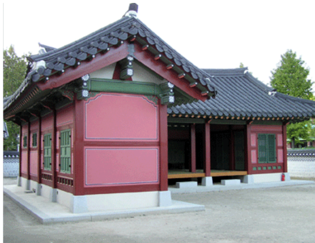
Abb. 35-26 Kaserne im Norden, Bukgunyeong , nach der Rekonstruktion 2008
