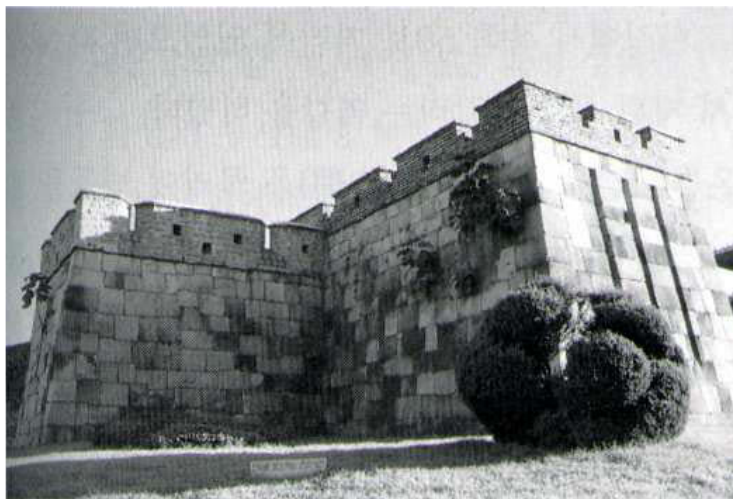
Abb. 3-8 Flankierungsturm im Nordosten, 1999
