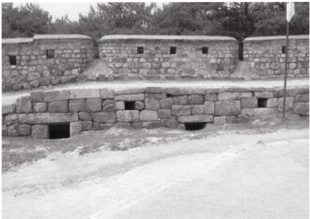
Abb. 16-8 Die beiden Feuerebenen in der Enceinte am Pavillon der Generäle im Westen, Hwaseong Jangdae , 2005
