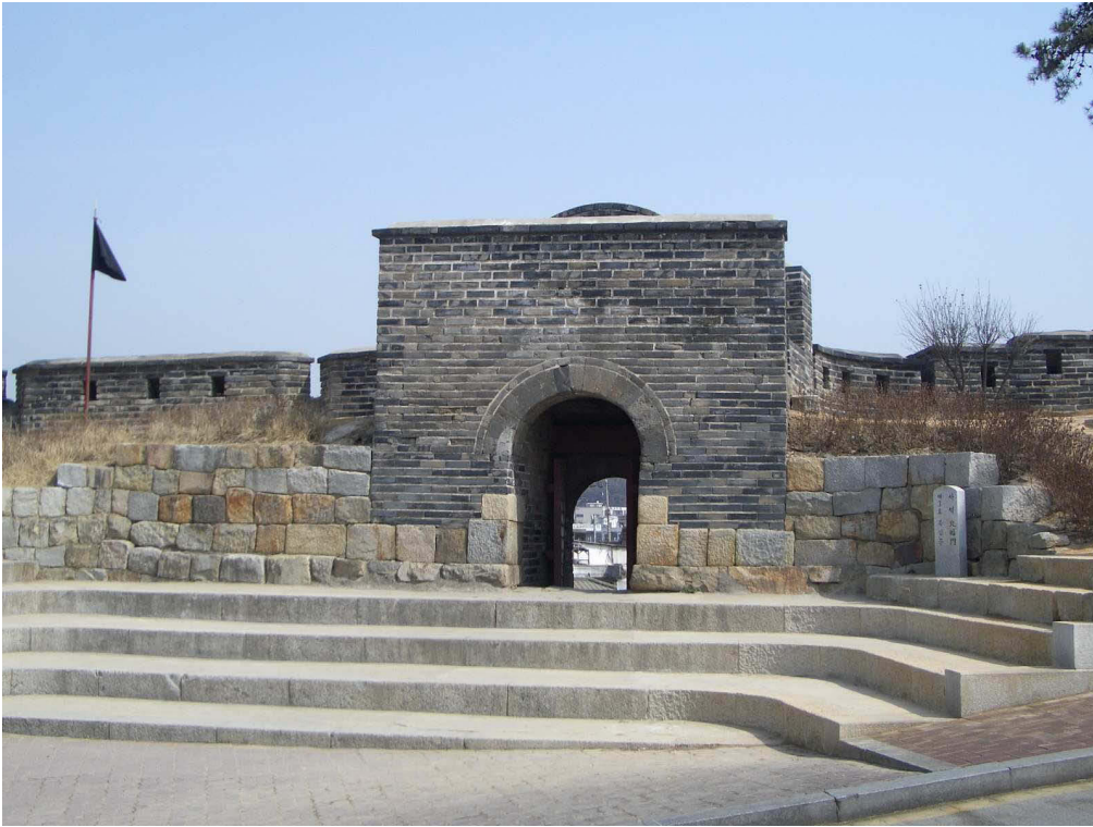
Abb. 9-3 Innenansicht der versteckten Pforte im Norden, Bukammun , nach der Rekonstruktion 2008
