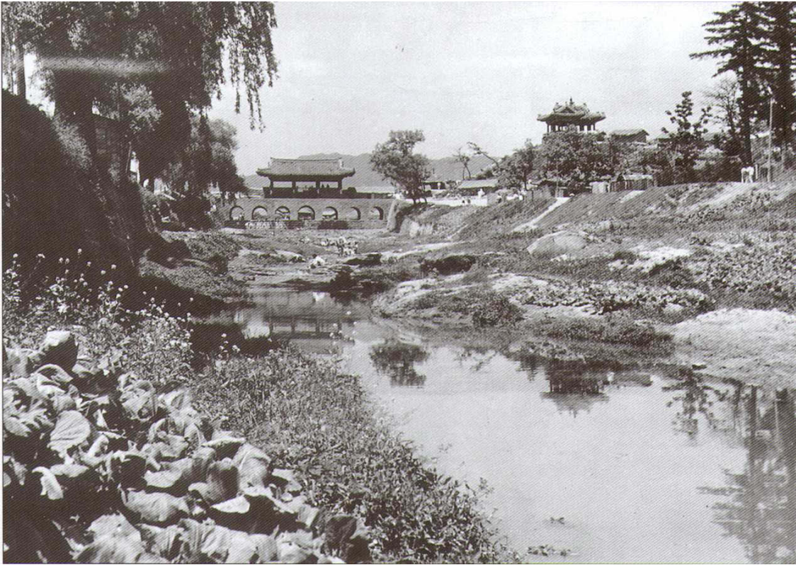
Abb. 12-3 Flussschleuse Buksumun ( Hwahongmun (華虹門)), 1920
