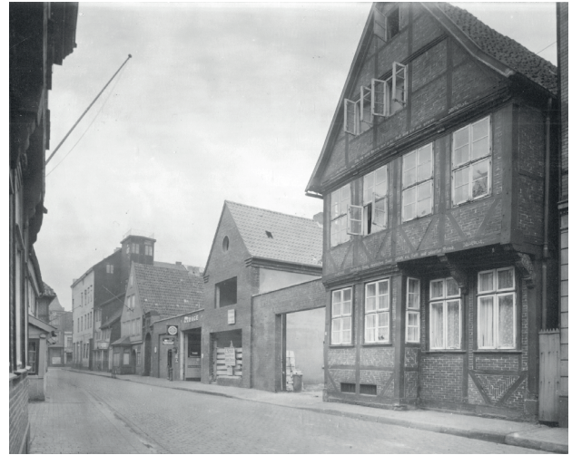
14 Blick in die Lämmertwiete von Westen, 1937.
