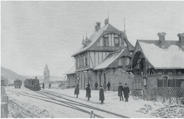
24 Bahnhof Bad Münstereifel, zwischen 1890–1905.
