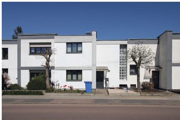
10 Damaschkestraße , 2016. Am mittleren Gebäude sind die Stahlfenster sehr wahrscheinlich noch erhalten, wobei ein Flügel fehlt,
