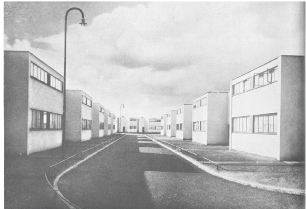
5 Haustyp SieTö II 1927 , Blick in den Kleinring in Richtung Südosten, Foto: Baubüro Gropius, um 1930.
