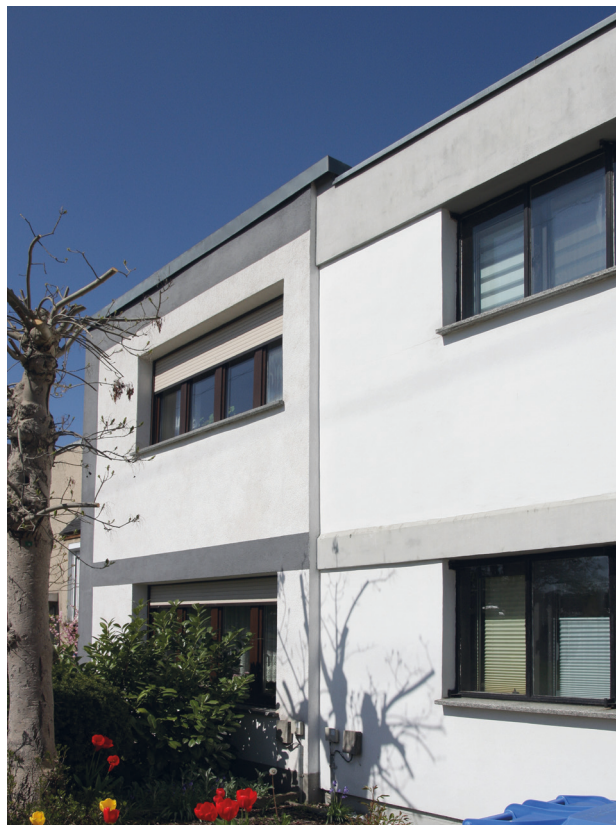
19 Fassaden in der Damaschkestraße , 2016.
