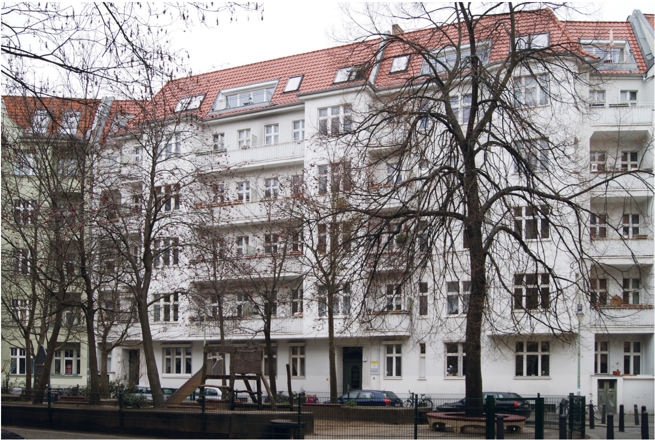
1 Sanierter Altbau an der Göhrener Straße mit Dachausbau, Prenzlauer Berg, 2016.
