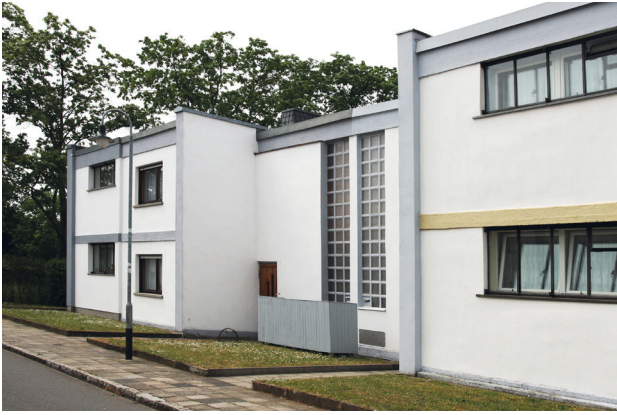
14 Kleinring 1–5 stellt eine Reihe gut erhaltener Fassaden dar, 2016.
