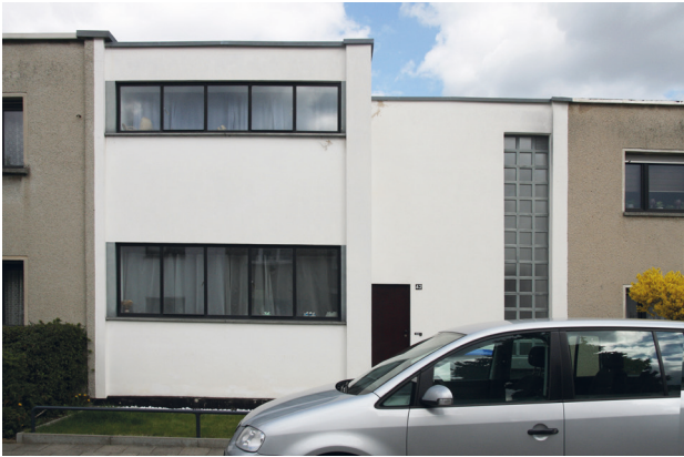
20 Die Rekonstruktion des Typs SieTö II 1928 im Kleinring verfügt über nachempfundene Stahlfenster, 2016.
