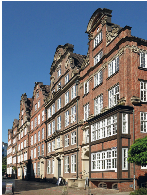
6 Nordseite der Peterstraße von Osten, 2017.
