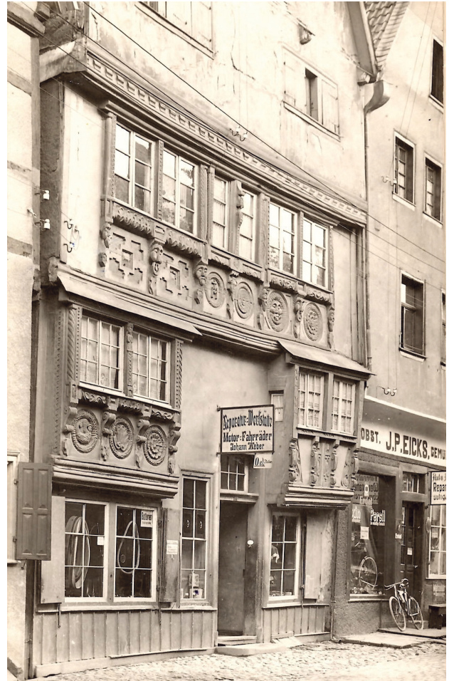
11 Fassadendetail Windeckhaus, Orchheimer Straße. 23, vor 1930.
