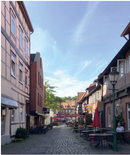
13 Blick in die Lämmertwiete von Osten, 2017.
