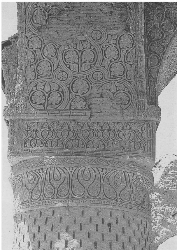
13,1 Balh. Ҳағғи Piyāde, Stuckdekor. – Photogr. Verf.
