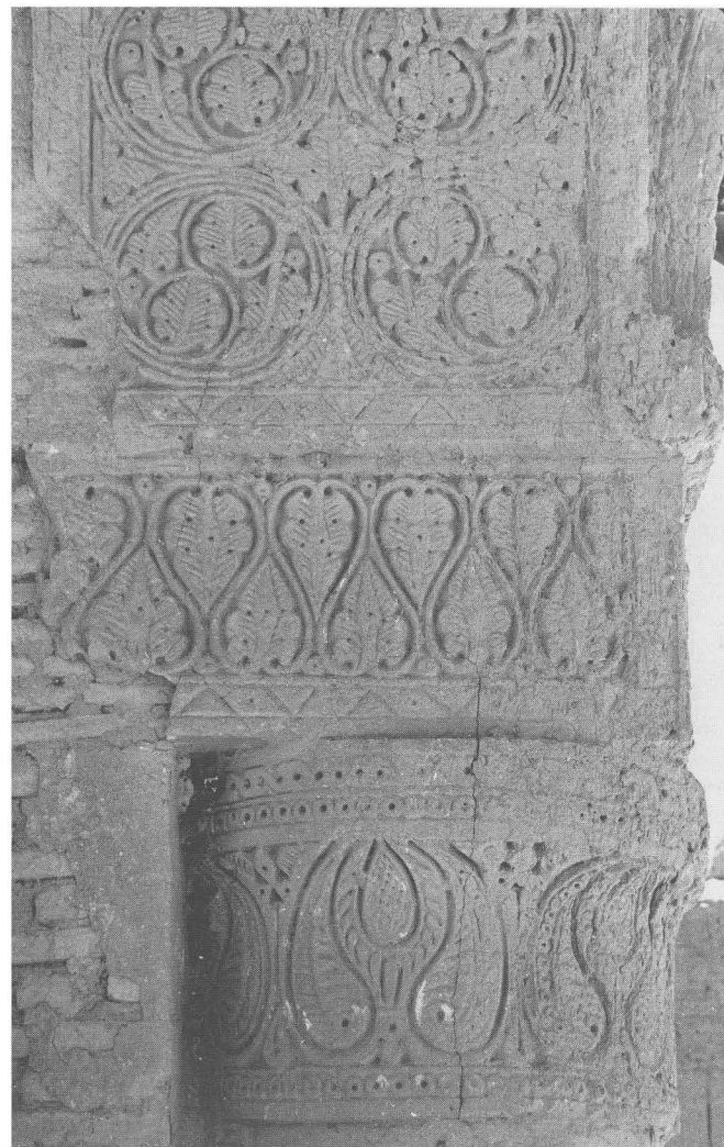
12,2 Balı. Hāğği Piyāde, Stuckdekor. – Photogr. Verf.
