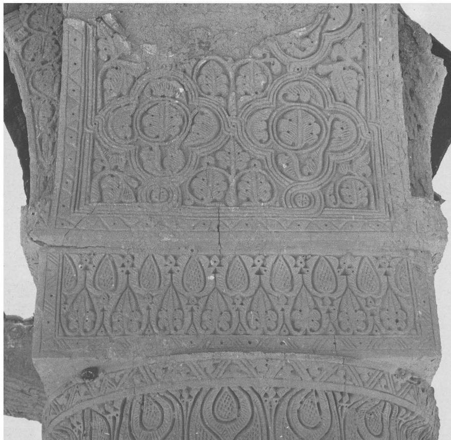
13,2 Balh. Ҳағғи Piyāde, Stuckdekor. – Photogr. Verf.
