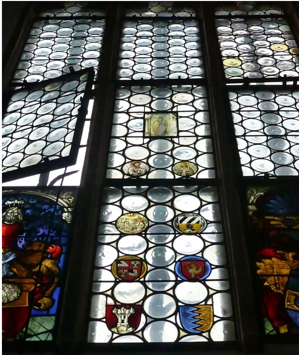
30a Fenster in St. Wolfgang, Puschendorf bei Fürth, mit einigen in situ erhaltenen klaren Butzenscheiben 1490
