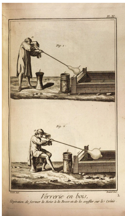
Tafel 15 Pl. XI Fig. 1: Ausbildung eines Knopfes an der Spitze Fig. 2: Weiteres Einblasen
