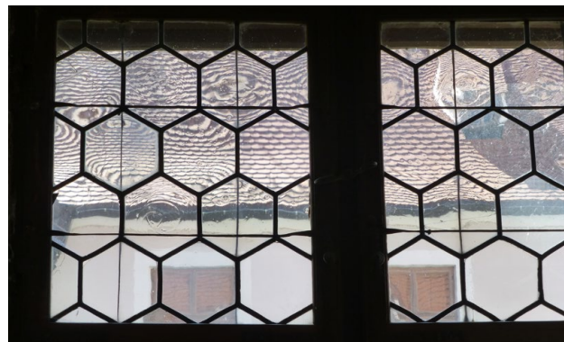
74a Waben aus Teller Glas mit konzentrischen Schlieren und einem Durchmesser von 13,8 cm. Klostergebäude Thierhaupten
