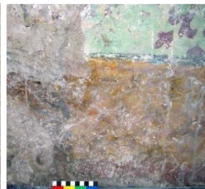
Abb.17.564: Während der Abnahme von verbliebenen Tüncheresten.
