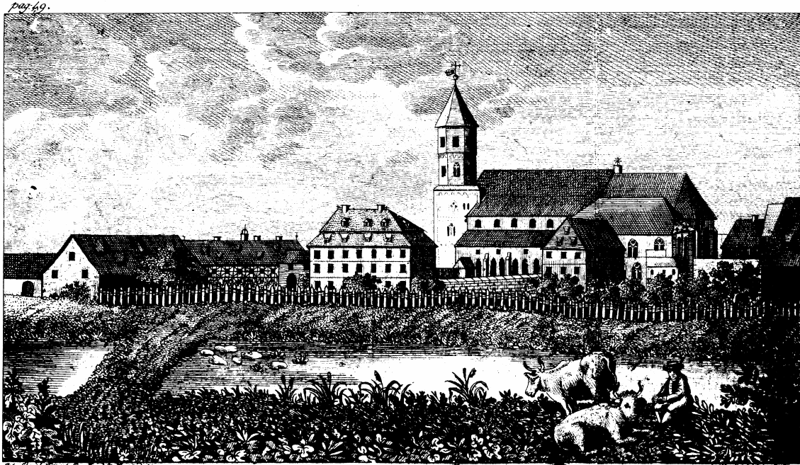
Südliche Ansicht des ehemaligen Klosters Neunkirchen am Brande
