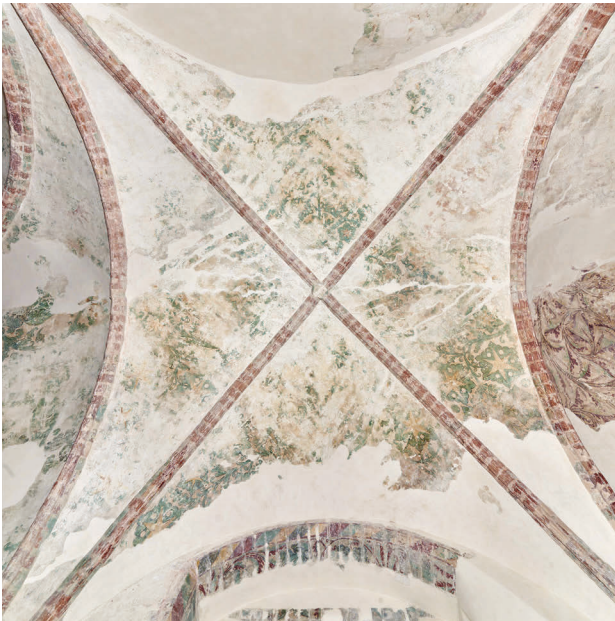
Abb. 1: Joch 2 der ehemaligen Bibliothek im Oberen Kreuzgang, Nordflügel der ehemaligen Domklausur, Brandenburg an der Havel [Noll-Minor].
