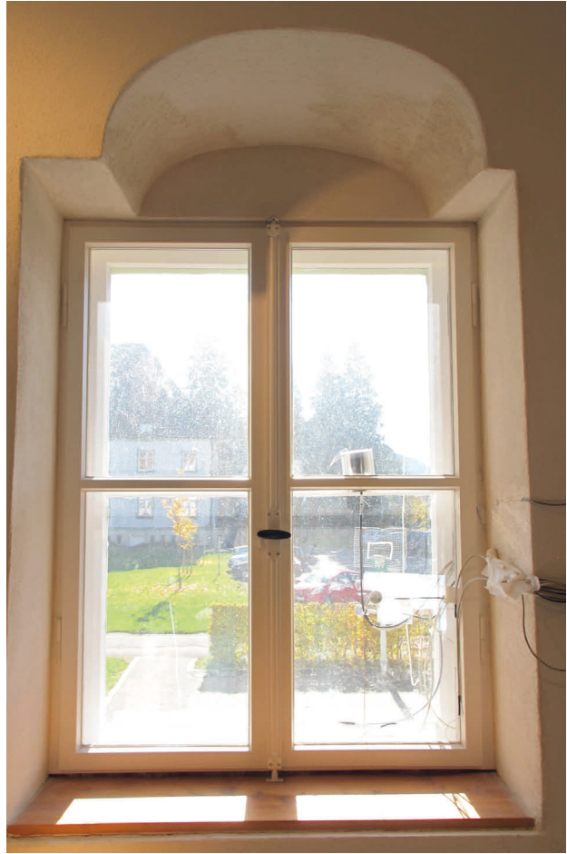
Abb. 5: Energetisch ertüchtigtes Fenster in der Alten Schäferei, Benediktbeuern, mit Messaufbau [Fraunhofer IBP 2019].
