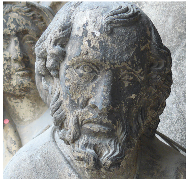
Abb. 4: Figurengesichter mit Korrosionserscheinungen, Südportal, Tympanon [Drewello 2012].
