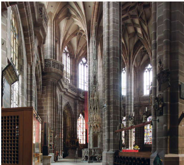
Abb. 1: St. Lorenz, Nürnberg; nördlicher Chorumgang des Hallenchores, erbaut 1439–77, mit Sakramentshaus von 1493–96 [Arera-Rütenik 2008].
