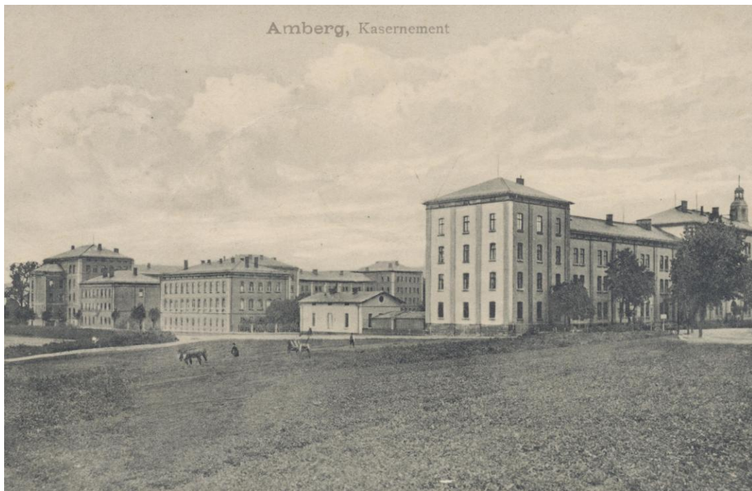
Abb.63: Blick auf die „Neue Infanteriekaserne“ vom Stadtrand aus, auf der um 1910 geschriebenen Postkarte ist rechts der Kasernenblock von 1868 zu erkennen mit dem zeitgleich errichteten Nebengebäude und von der Mitte her nach links die später erbauten Stabsgebäude und der zweite große Kasernenblock.
