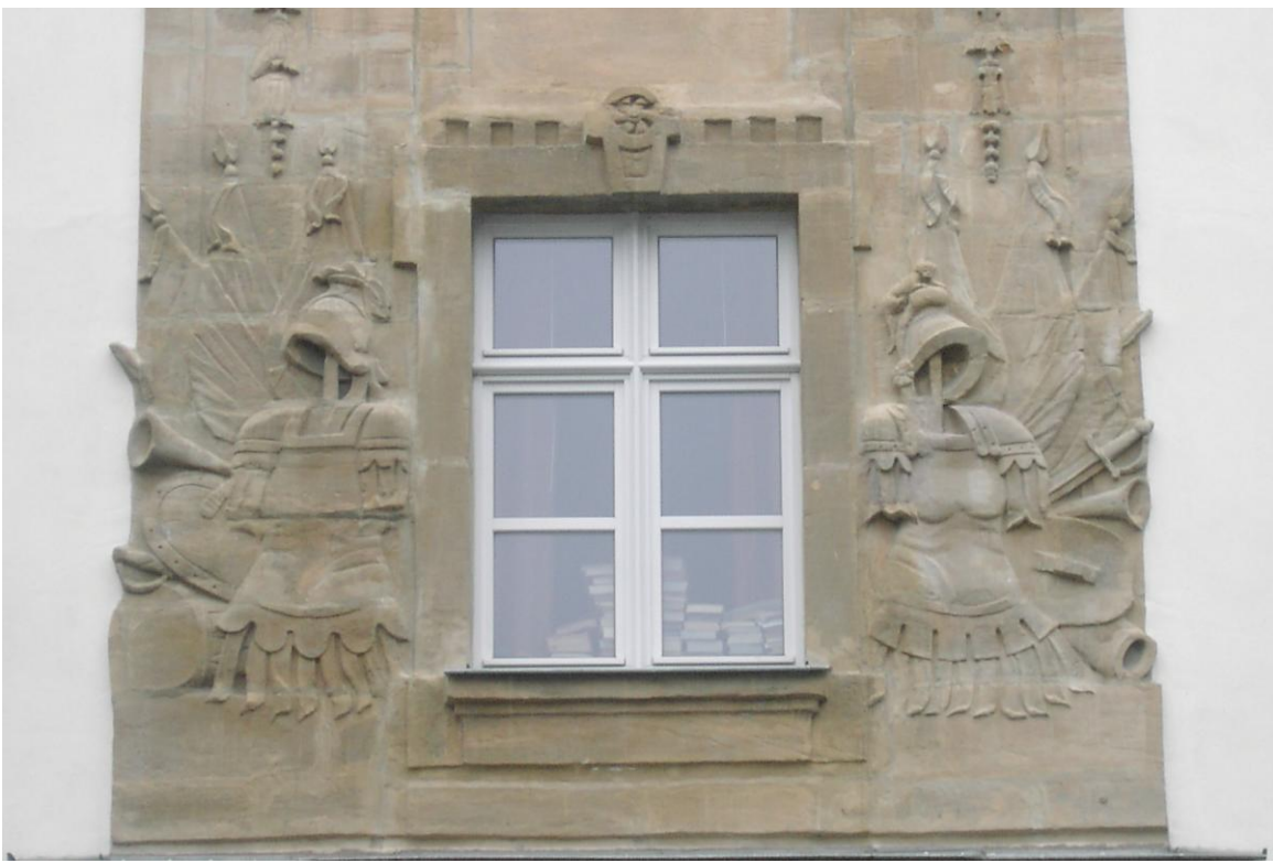
Abb.2: Beim Umbau zur Kaserne wurde über dem Hauptportal eine plastisch hervorgehobene Fensterachse mit Militärmotiven eingefügt.
