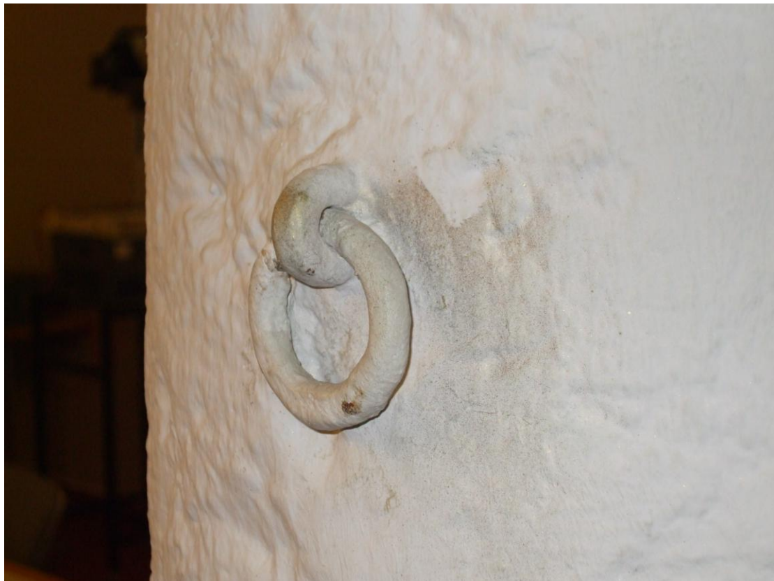
Abb.24: Sogar die Eisenringe an den Säulen des früheren Militärstalls blieben bei der Um- nutzung der „Steinhofkaserne“ als städtisches Behördengebäude erhalten.
