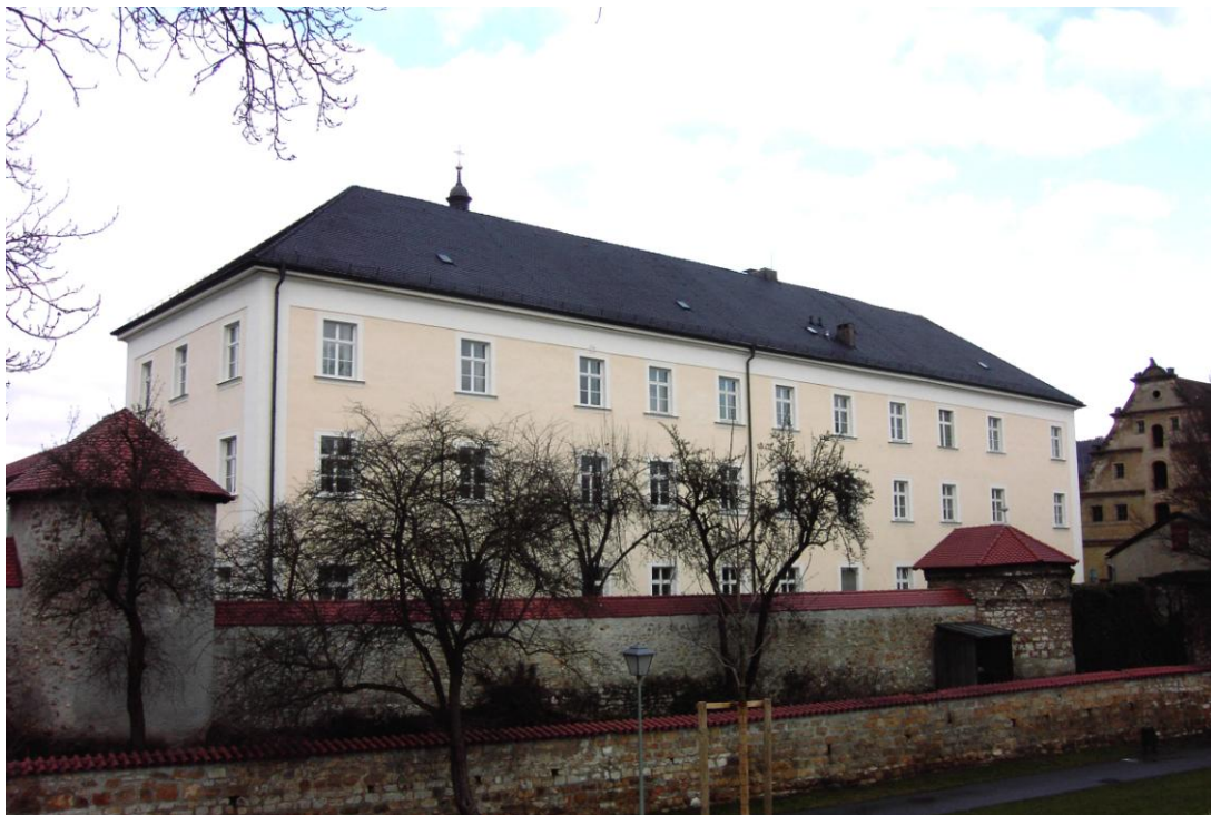
Abb.33: Das ehemalige Militärlazarett und heutige Amtsgericht in Amberg von der Stadtmauerseite her gesehen.
