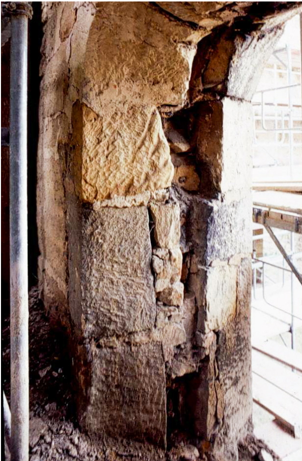
Abb. 01: Stiftskirche Walbeck, Auffindungszustand eines ottonischen Fensters in der südlichen Chorwand [Breitling 2001].
