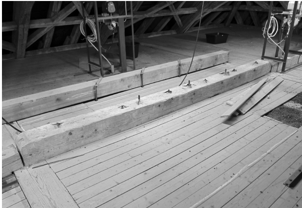
11 Wie Abb. 7. Mittlerer Überzug über dem Gewölbe zwischen den Sägezahnbalken mit sichtbaren Spuren aus Vorverwendungen.
