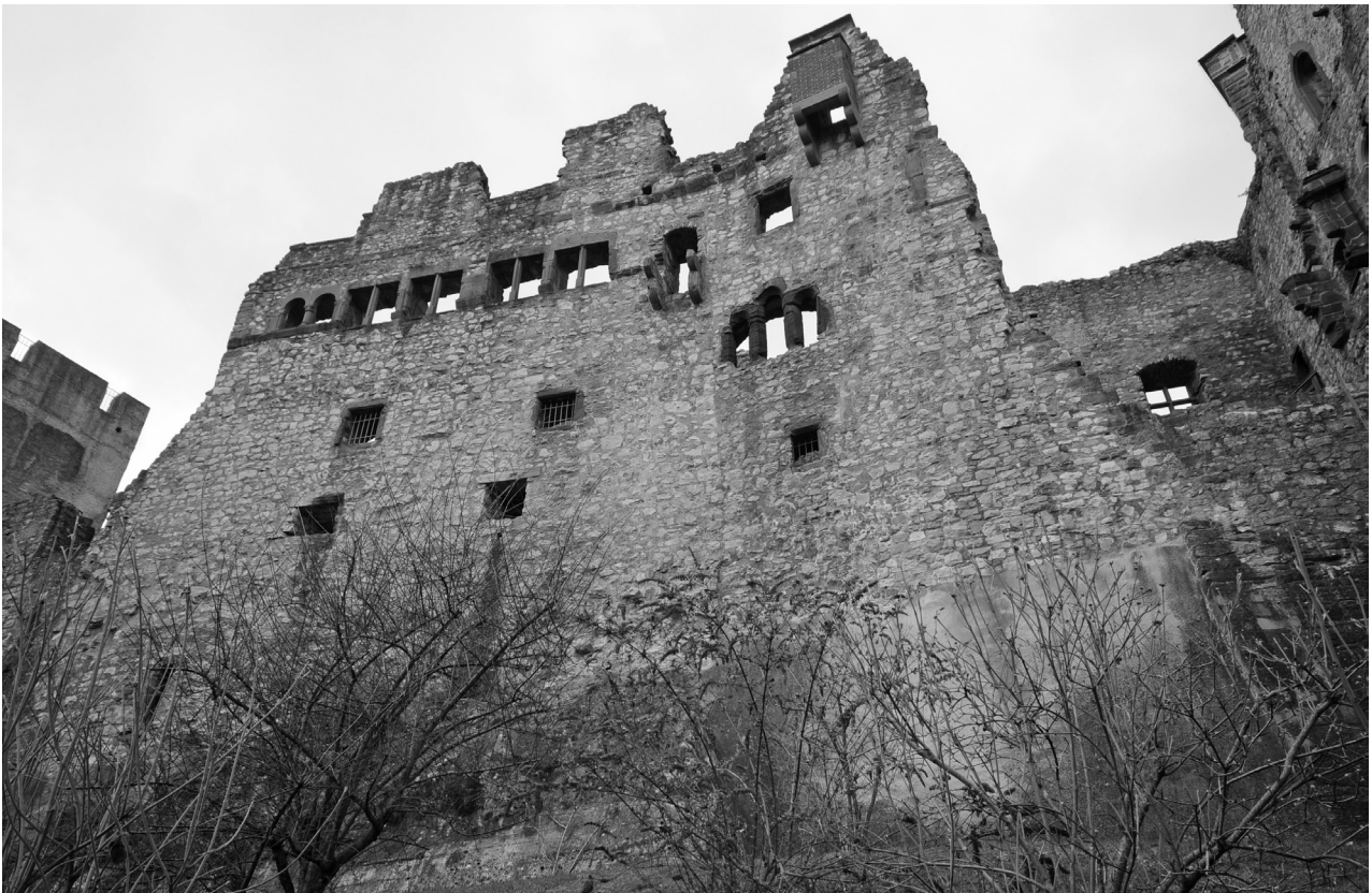
13 Burg Rötteln, Talfassade des Wohnbaus („Palas“).
