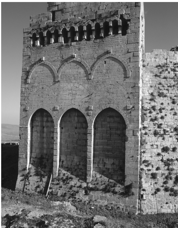
4 Crac des Chevaliers, Abtritt-Turm.
