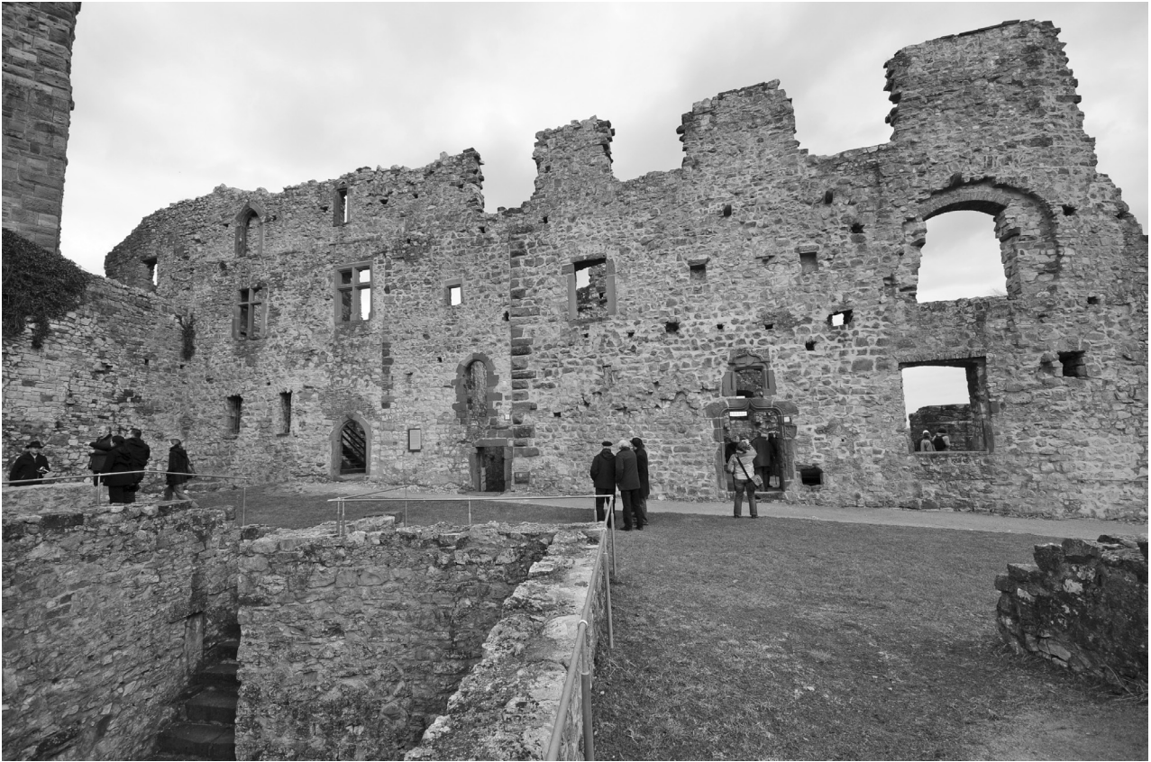
12 Burg Rötteln, Hoffassade des Wohnbaus („Palas“).
