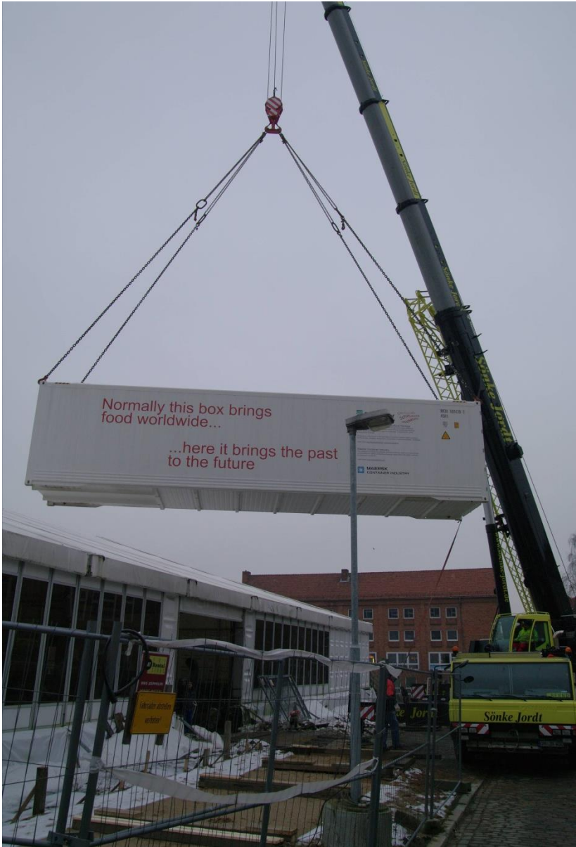
Abb. 7: Lübeck, Gründungs Viertel. Bergung und Lagerung der Holzkellerkonstruktionshölzer in speziellem Klimacontainer.
