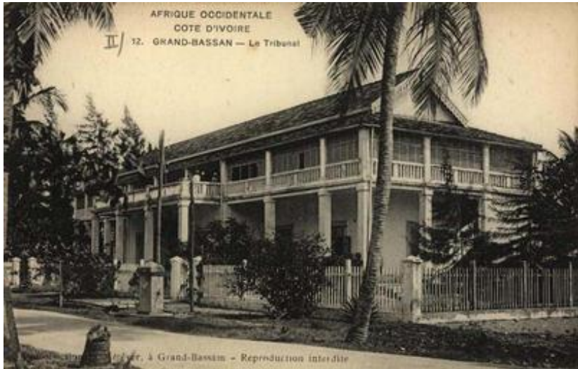
Abb. 11: Das Gerichtsgebäude (Tribunal) von Grand Bassam (errichtet 1911, Schauplatz der geplanten Prozesse von 1949).
