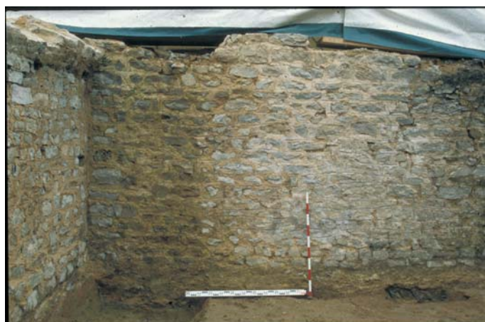
Abb. 14.3: Schnitt 2, Innenraum des Kellers ( Südwest-Ecke ) mit "pietra-rasa"-Putz und Ansätzen des nachträglich eingezogenen Tonnengewölbes.
