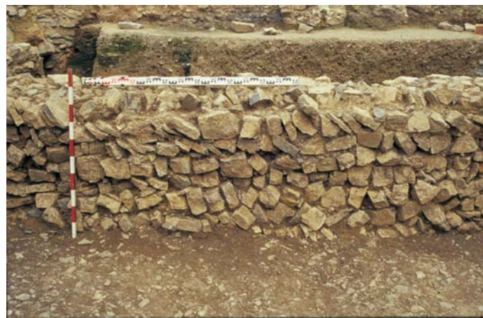
Abb. 16.3: Schnitt 2, Detailaufnahme der lehmgebundenen Mauer (Bef.-Nr. 597).
