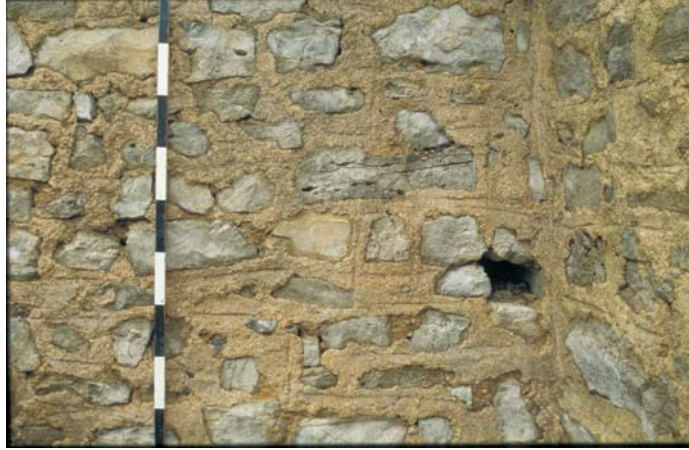
Abb. 15.1: Schnitt 2, Detailaufnahme der Südwand des Kellers mit "pietra-rasa"-Putz.
