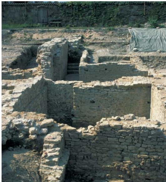
Abb. 14.2: Schnitt 2, Obere Hälfte des längsrechteckigen Kellers mit nachträglich angefügtem Kellervorraum samt Kellerhals ( Blick von Norden ).
