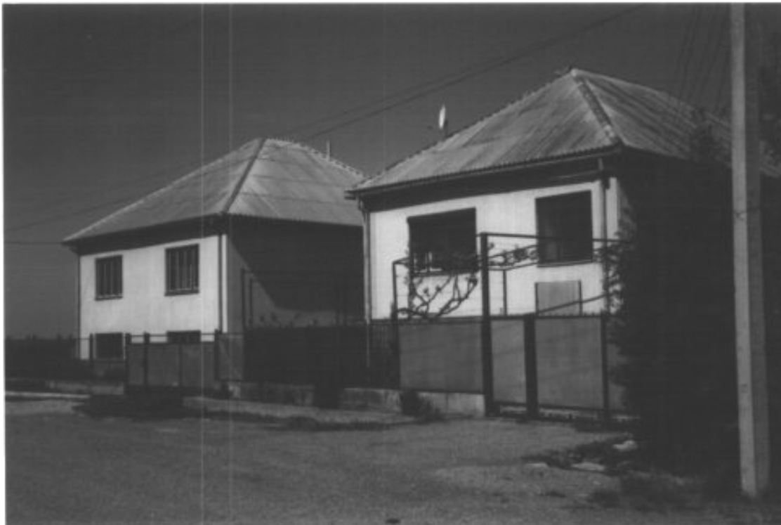
130. Lisna-Straße (Waldstraße), Siedlungsgebiet am Ortsrand
