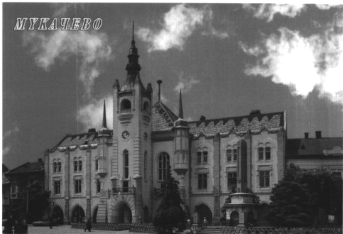
99 b. Rathaus von Munkatsch
