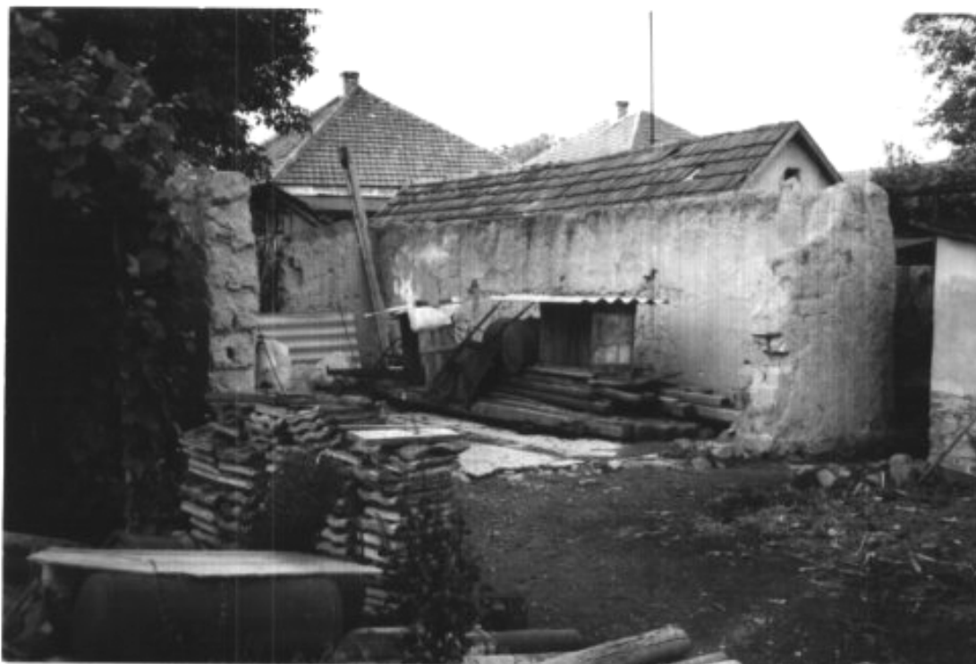
40. Viehstall, Mauerreste mit eingelegtem Gebälk und Dachziegeln
