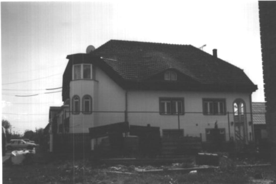
128. Nowa-Straße, individuelle Bauweise
