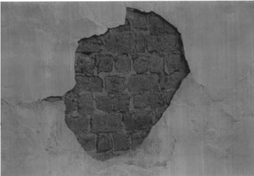
43. Walkenmauer des Wohnhauses
