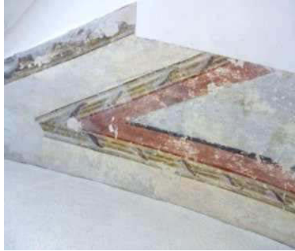
Abb.4.11: Freigelegte Malerei am Gewölbe der Dominikuskapelle
