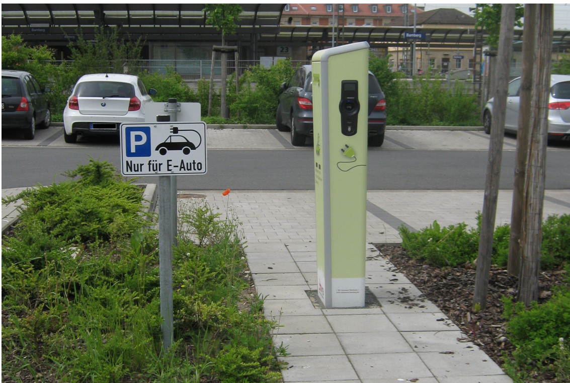
Abbildung 7.1: Parkplatz für Elektroautos am Bahnhof Bamberg
