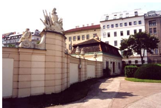
Abb. 1360 Wien, Oberes Belvedere Wirtschaftsgebäude
