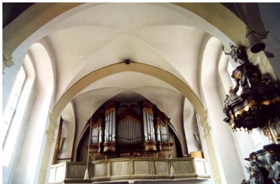
Pettstadt, Wandpfeiler, Gurtbögen, Kreuzgratgewölbe
