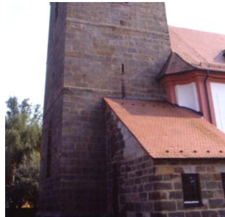
Kersbach, Sakristei und Turmerdgeschoss
