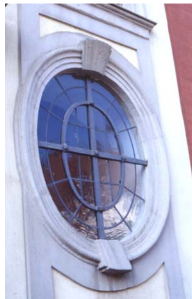
Spital Kupferberg, Kapellenfenster im Erdgeschoss
