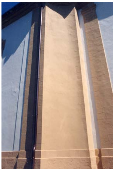
Pretzfeld, Übergang Fassadenturm/Langhaus
