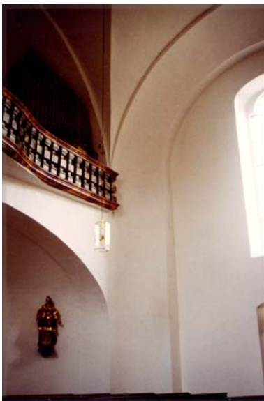
Pretzfeld, Übergang Empore/Fensterische
