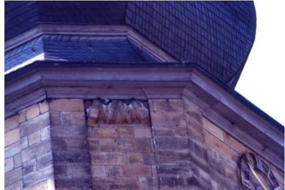
Kupferberg, St. Veit, Außenkantenlisenen, Volutenband und Kranzgesims
