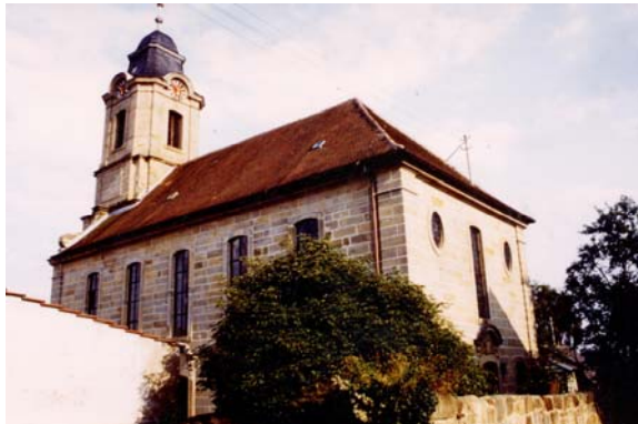
Heiligersdorf, Langhaus und Fassadenturm
