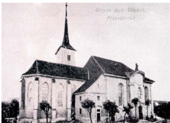
Vilseck historische Aufnahme um 1900 mit ehemaliger Langhausgiebelwand (jetzt Anbindung von Chor und Langhaus durch Abwalmung) und Sakristeipultdach (jetzt Walm)
