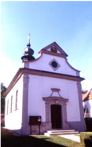
Lembach, Gesamtansicht nach der letzten Sanierung
