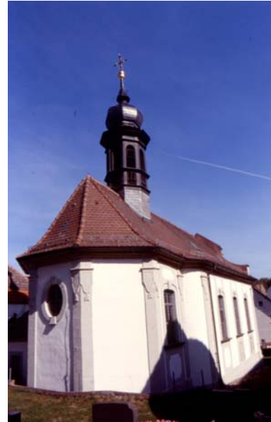
Lembach, Chor nach der letzten Sanierung
