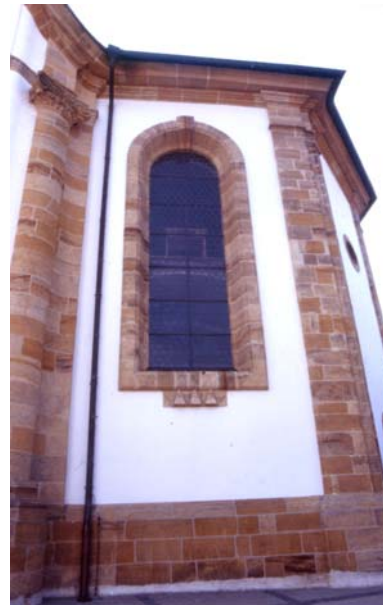
Vilseck, westliche Seitenachse der Nordfassade
