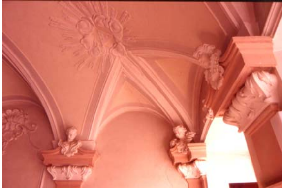
Spital Kupferberg, Gewölbeekkonflikt
