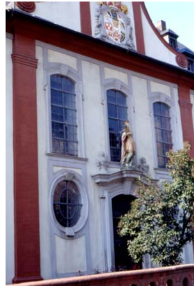
Spital Kupferberg, Kapellenfassade
