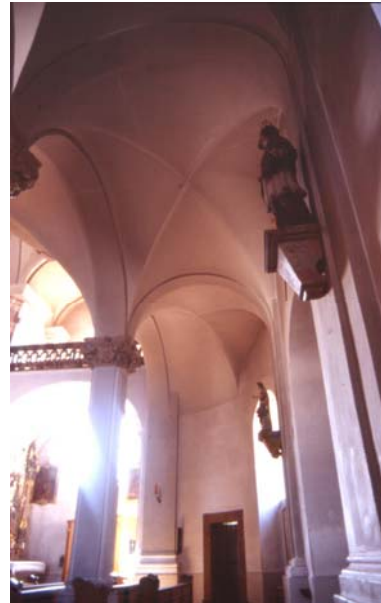
Vilseck, Emporenunterkonstruktion
