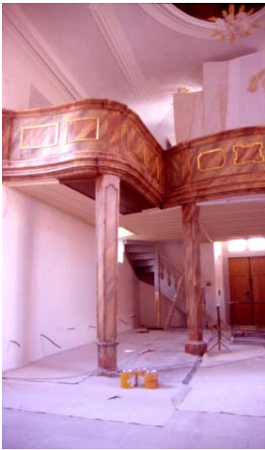
Straßgiech, Empore - während der Sanierung 2004
