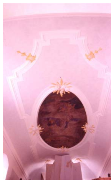
Strabgösch, Decke nach Sanierung 2004 mit veränderter Farbgebung
