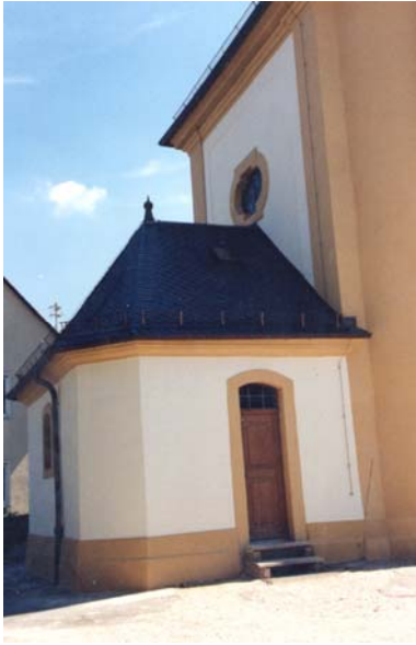
Pretzfeld, Chorstirnwand und Sakristei
