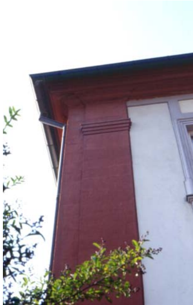
Spital Kupferberg, Außenkantenlisenen
