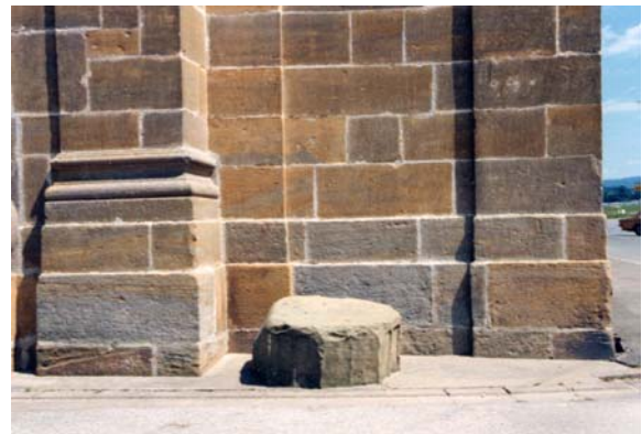
Oberbrunn, Fassadensockel und Rest einer mittelalterlichen Außenkanzel
