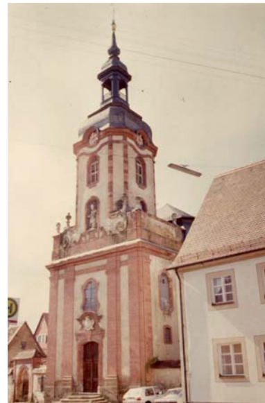
Pretzfeld, Fassade vor der letzten Sanierung
