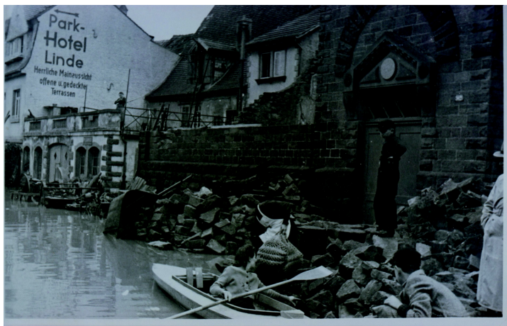
Abb. 20: Die neue Synagoge nach ihrer Zerstörung: Das Foto entstand 1942 (Quelle: Museen der Stadt Miltenberg)
