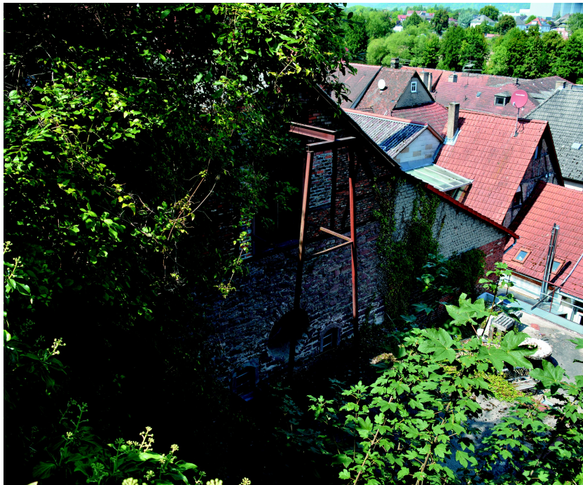
Abb. 9: Nach ihrem Verkauf 1877 wurde die Synagoge umfangreich umgebaut. Bis heute erhalten: Das auffällige, runde Mizrach-Fenster (Quelle: Jakob Link)
