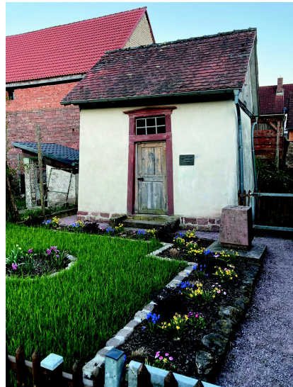
Abb. 30: Der Mikwen-Neubau in Kleinheubach (Quelle: Marktgemeinde Kleinheubach)
