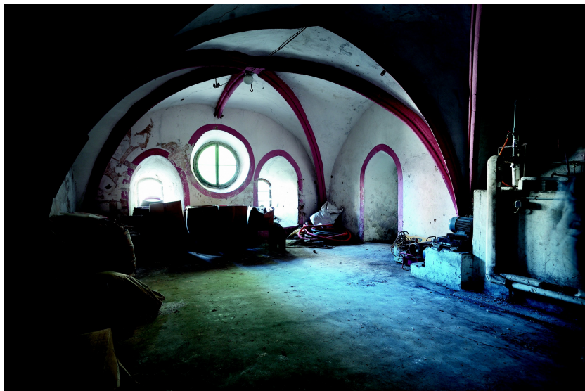
Abb. 15: Der Innenraum der ersten Synagoge. Nach ihrem Verkauf wurde diese umgebaut: Ein Fachwerk-Dach lässt das Gebäude heute unscheinbar wirken. Innen wurde eine Zwischendecke (auf dem Bild der Boden) eingezogen, die den Raum in zwei Etagen teilt (Quelle: Museen der Stadt Miltenberg)
